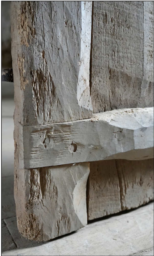
Fig. 3.3. Assemblage inférieur
