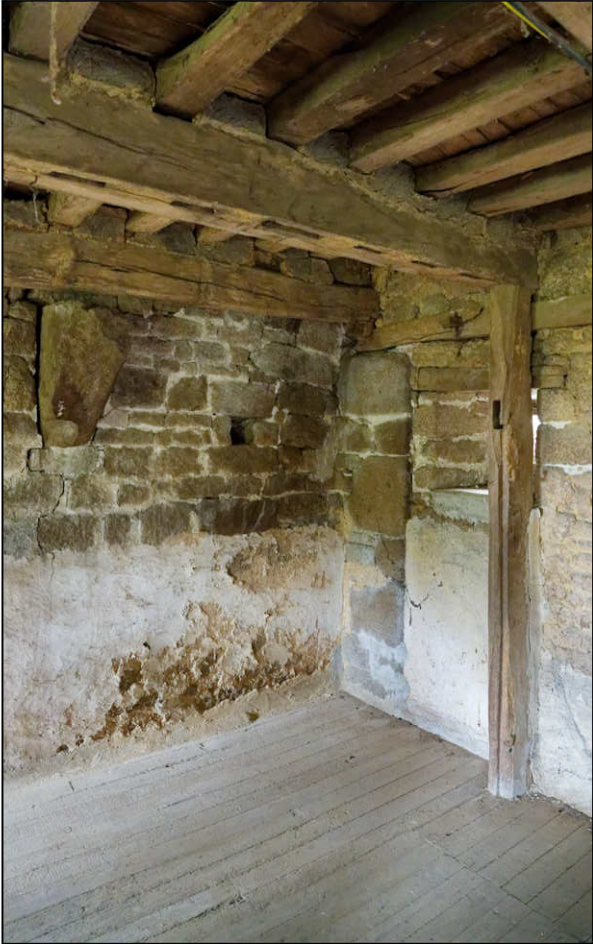
Fig. 1.2. Cloison en pan de bois de l'extension
