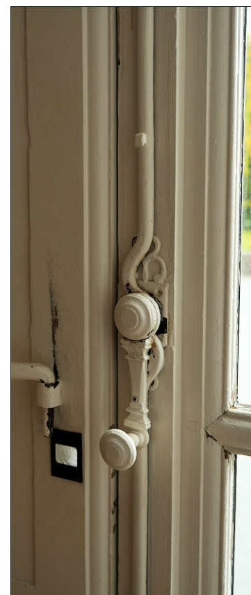
Fig. 10 et 11. Villons-les-Buissons (Calvados), château. Verrou à bascule pour volets intérieurs et imposte. Fig. 12 et 13. Limoges (Haute-Vienne), palais épiscopal. Verrou à bascule de croisée.
