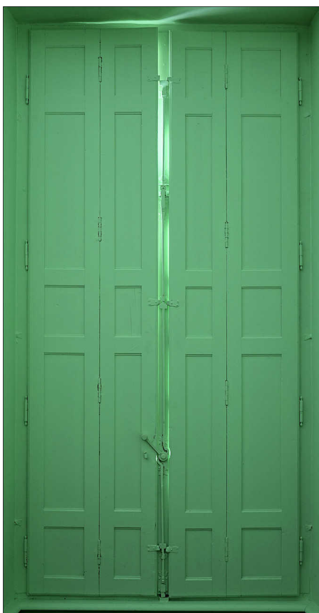
Fig. 4 et 5. Magny-en-Bessin (Calvados), château. Verrou à bascule et son mécanisme. Fig. 6 et 7. Villons-les-Buissons (Calvados), château. Verrou à bascule pour volets intérieurs et imposte.
