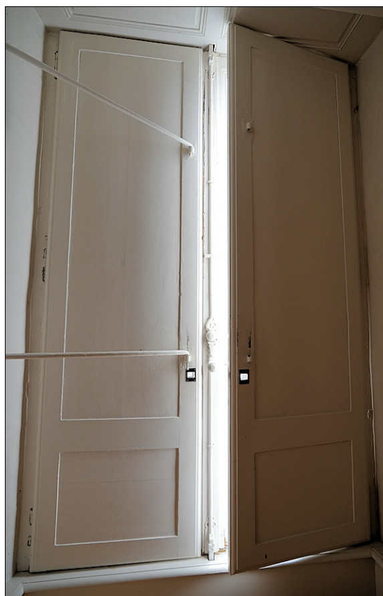
Fig. 10 et 11. Villons-les-Buissons (Calvados), château. Verrou à bascule pour volets intérieurs et imposte. Fig. 12 et 13. Limoges (Haute-Vienne), palais épiscopal. Verrou à bascule de croisée.
