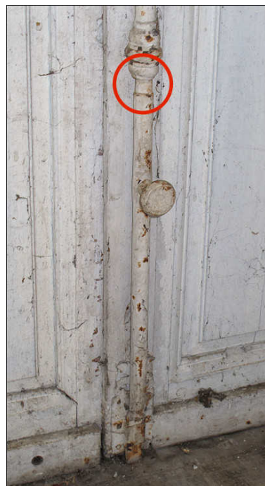
Fig. 40. Bénéville (Calvados), château. Le verrou est commandé par la tringle au travers d'une vis.
