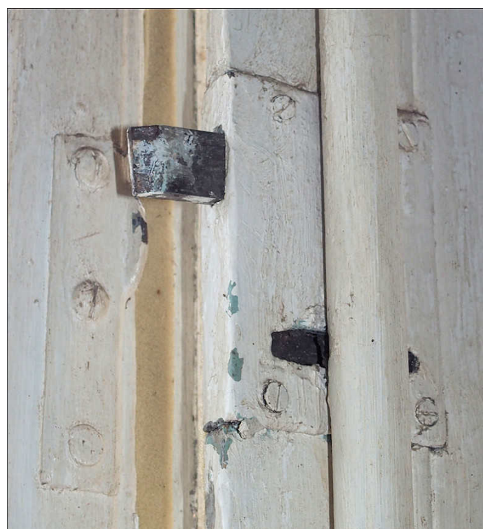
Fig. 46. Magny-en-Bessin (Calvados), château. Espagnolette de porte-fenêtre (fermeture intermédiaire).
