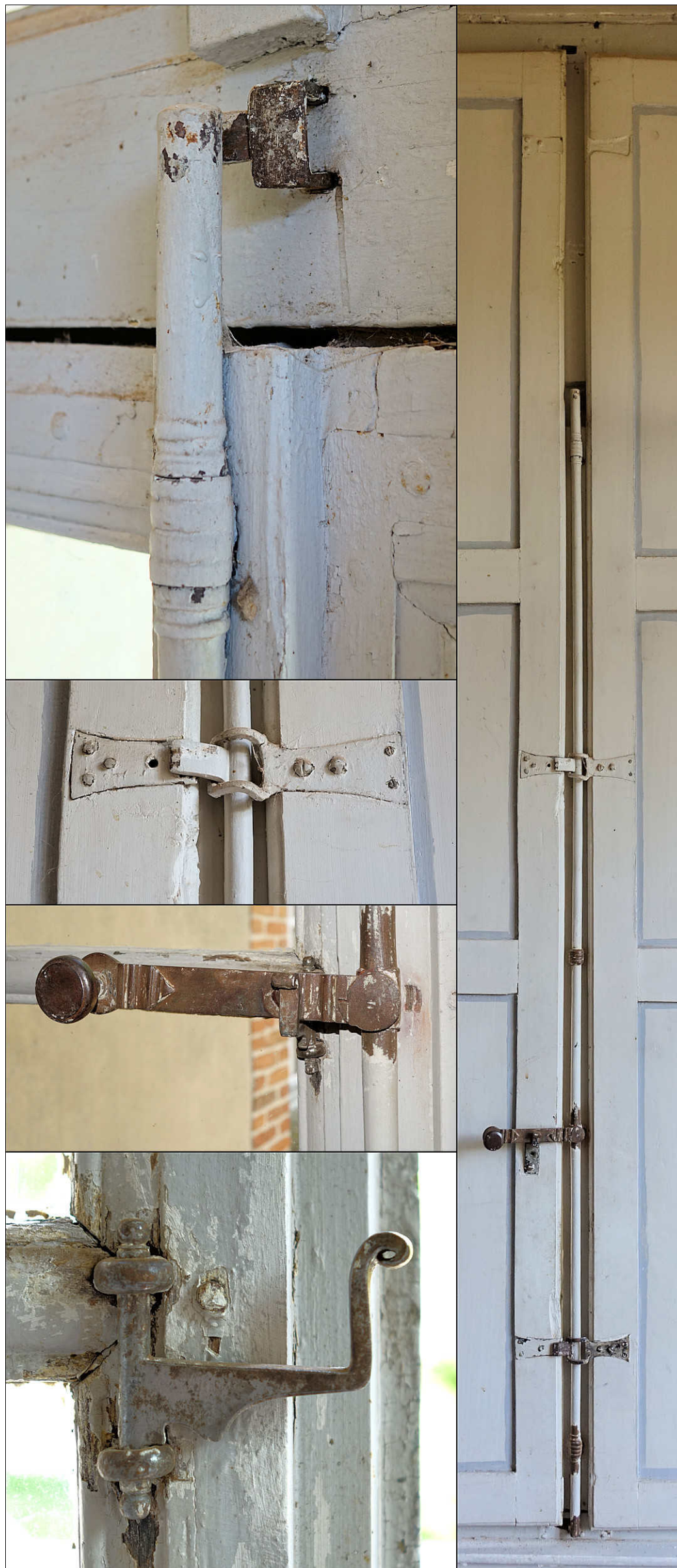
Fig. 34. Vaux-sur-Seulles (Calvados), château de Vausieux. Tringle d'imposte.
