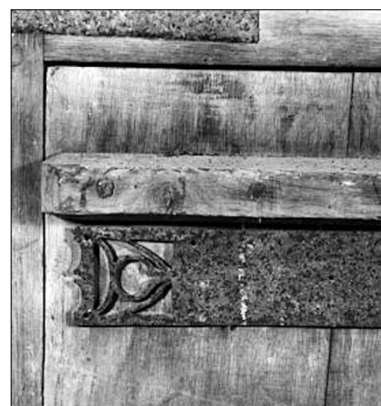
Fig. 16. Châteaudun, château, aile Dunois. Seuls les abouts de pentures sont décorés Médiathèque de l'architecture et du patrimoine Photo D. Bontemps (cl. MH 329273)
