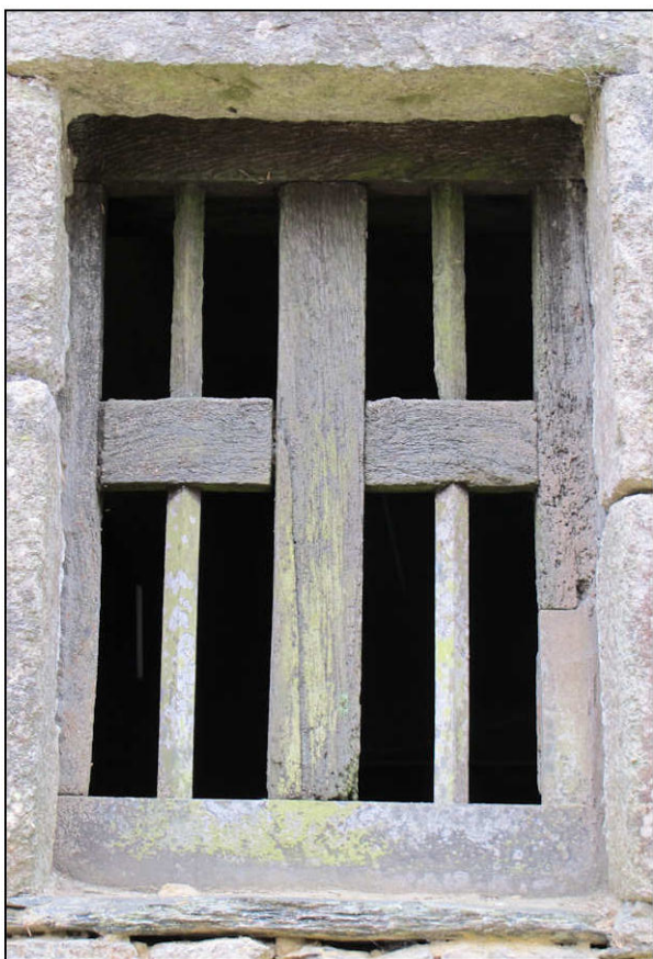
Fig. 1.5. Croisée du rez-de-chaussée
