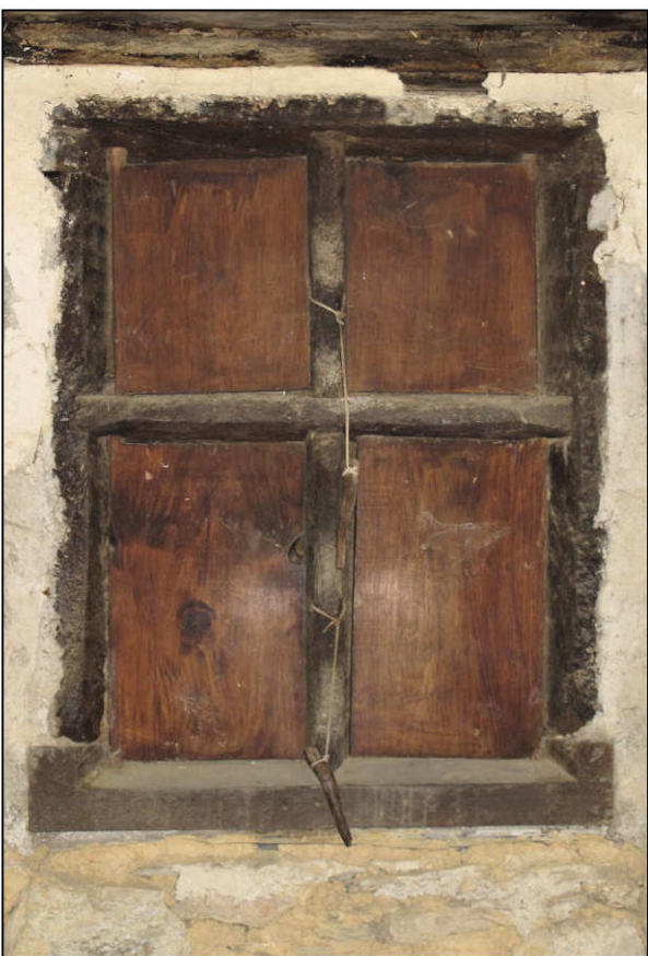
Fig. 1.6. Croisée du rez-de-chaussée
