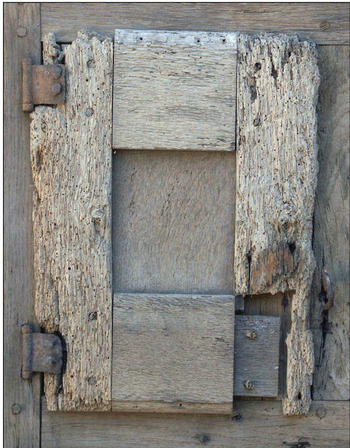
Fig. 19. Volet du manoir de la Croix-Courte à Miniac-sous-Bécherel (élévation intérieure)
