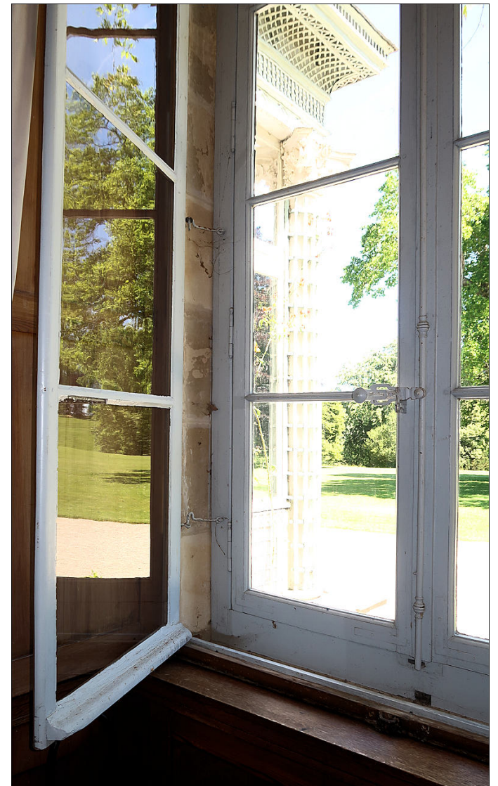
Fig. 3. Double-fenêtre du XIX e siècle posée en tunnel et maintenue par des crochets. (région de Lisieux)
