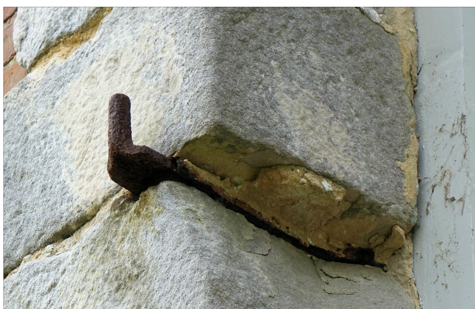
Fig. 21. Gond oxydé du château de Galleville à Doudeville
