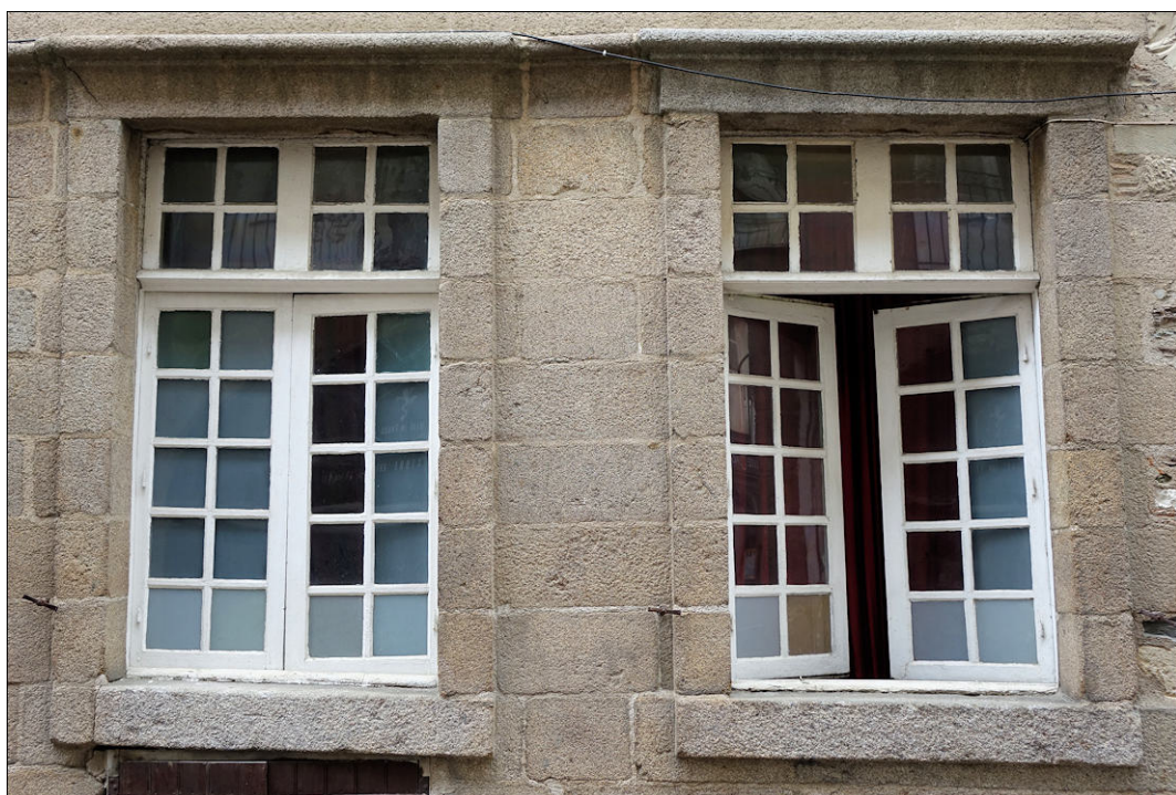
Fig. 35. Croisées conservant des ferrures de contrevents sur leur vantaux. Maison, rue du Chapitre à Rennes.
