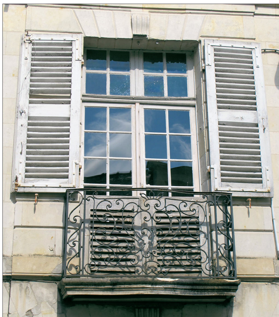
Fig. 15. Persiennes de balcon avec un soubassement. Maison, rue Clémenceau, à Baugé (Maine-et-Loire).
