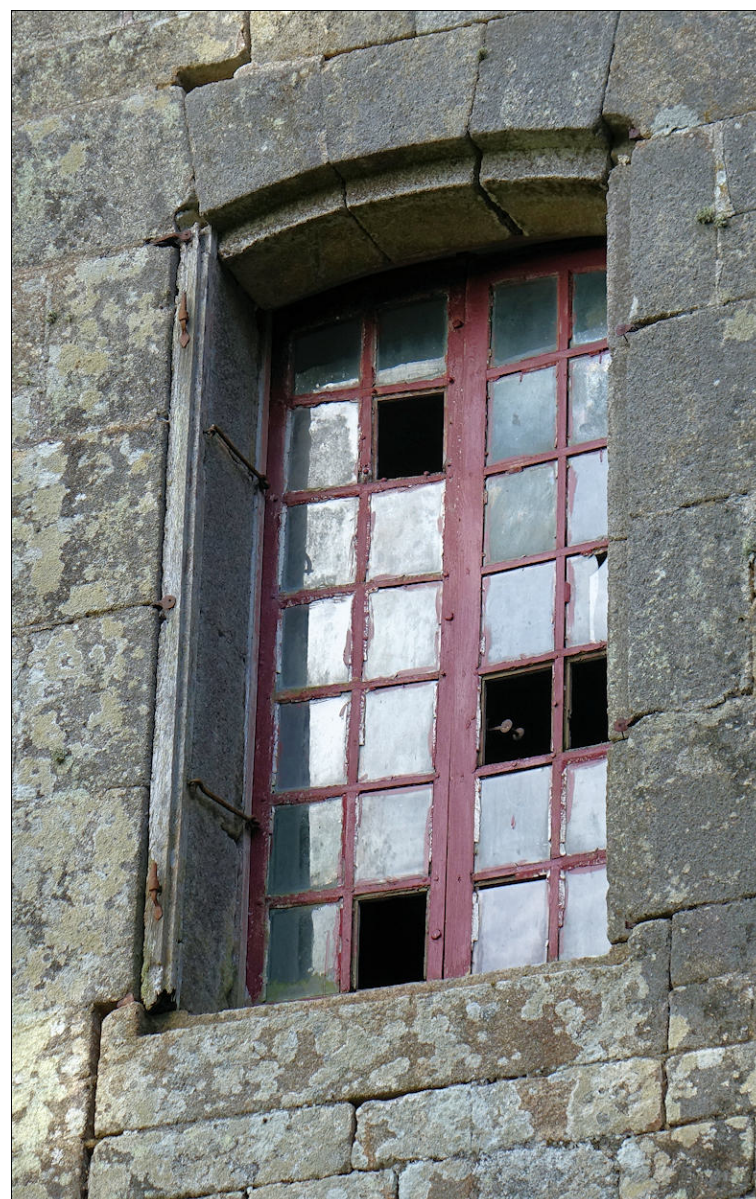
Fig. 22. Vestige de contrevents sur bâti dormant. (région de Pontivy)
