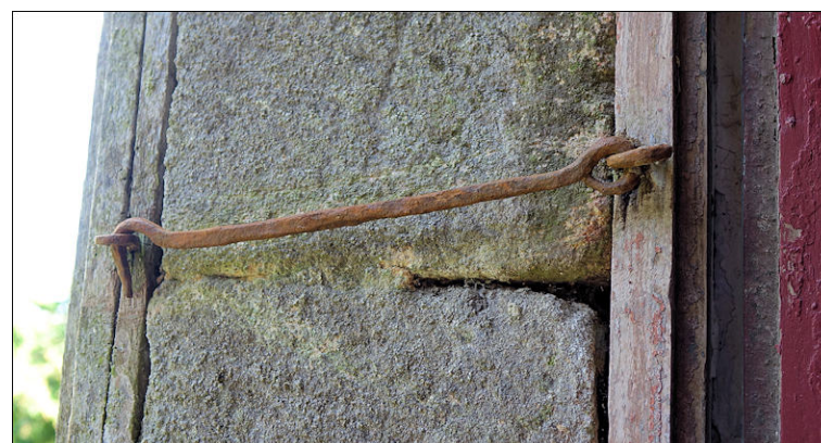
Fig. 23. Crochet pour maintenir le bâti dormant. (région de Pontivy)
