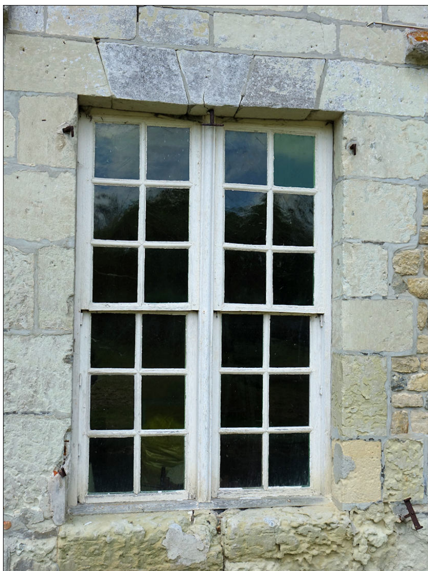
Fig. 20. Ancien presbytère de Bonnebosq
