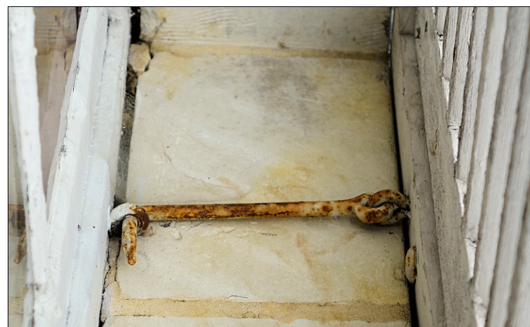
Fig. 24. Crochet pour maintenir le bâti dormant. Château de Boisgibault à Ardon.
