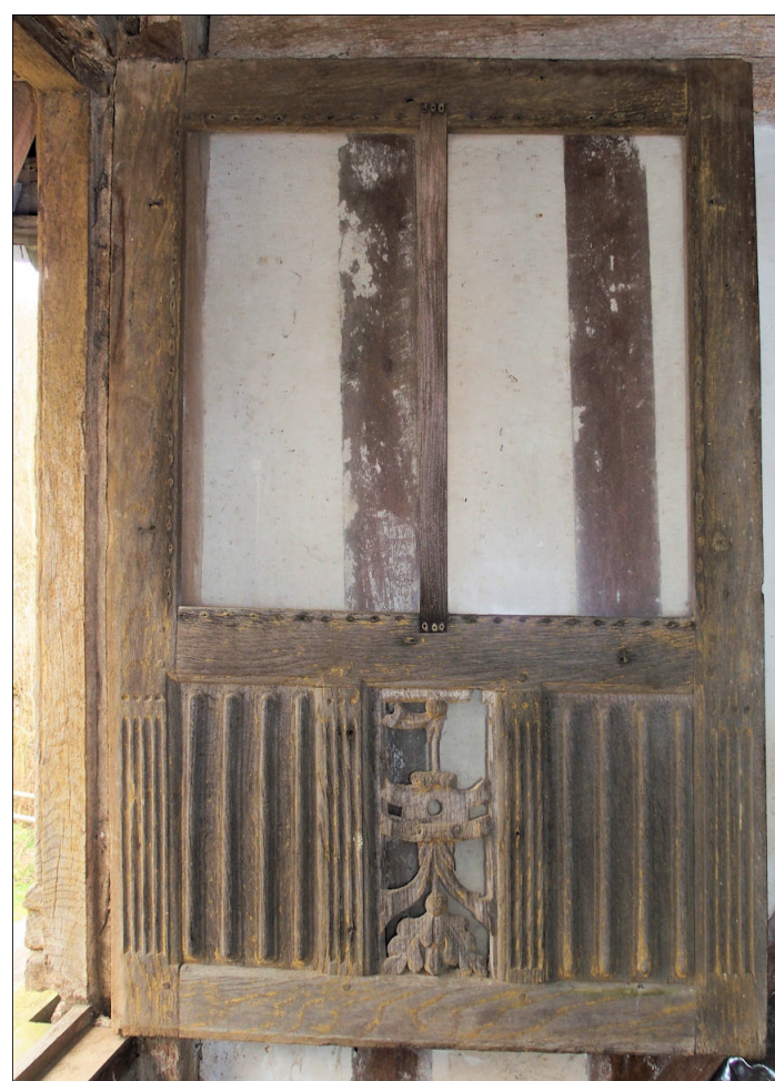
Fig. 1. Saint-Gatien-des-Bois (Calvados) Manoir du Vilambert. Châssis garni de toile (le petit-bois vertical a été ajouté)
