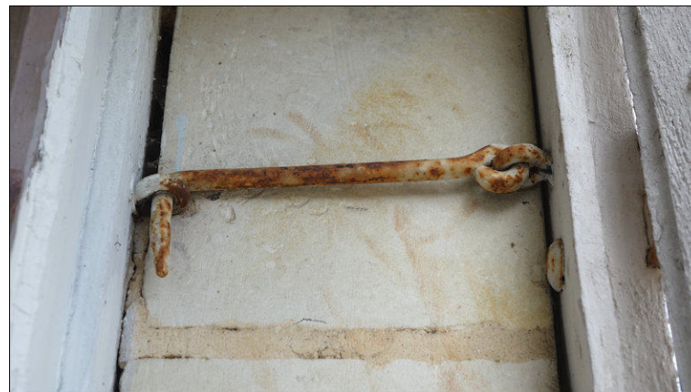
Fig. 23. Ardon (Loiret), château de Boisgibault A gauche, la croisée. A droite, les persiennes ferrées sur un bâti dormant, l'ensemble étant maintenu par des crochets à la croisée.
