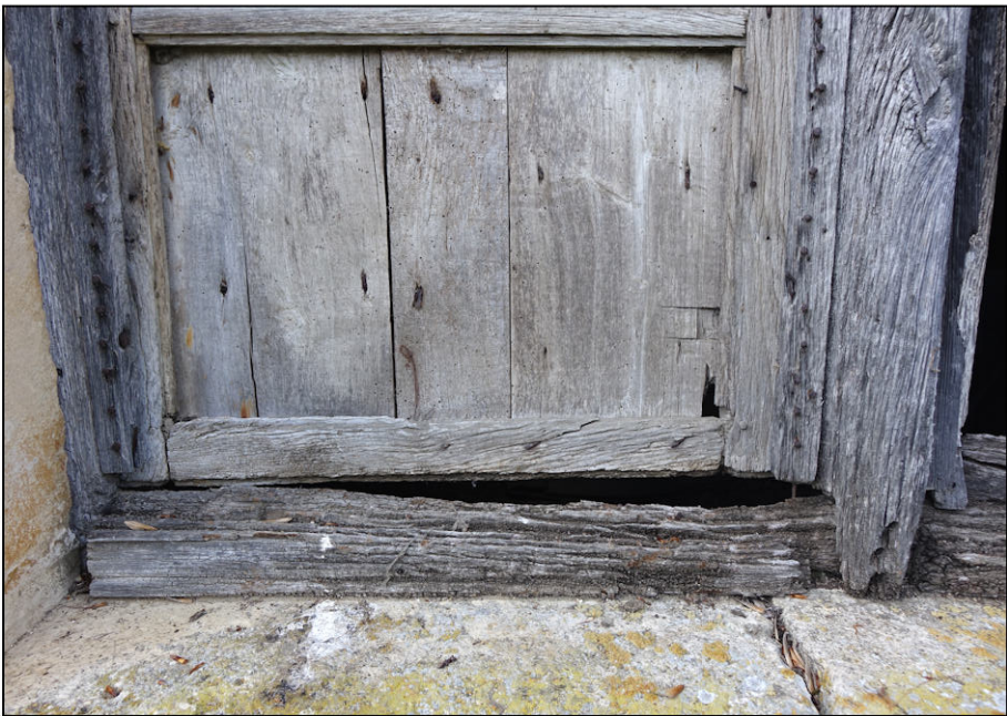
Fig. 7.4. Châssis C (pièce d'appui et meneau)
