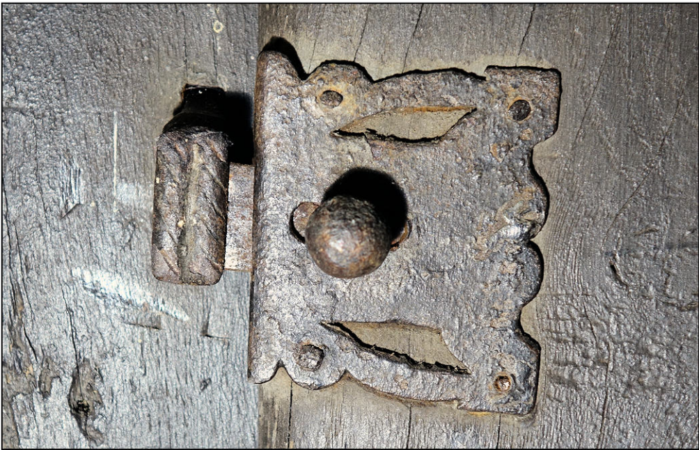
Fig. 4.3. Targette (volet inférieur)
