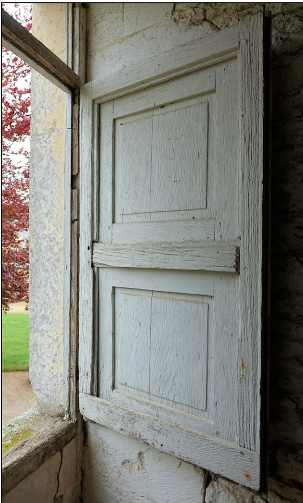
Fig. 3.5. Vantail vitré et volets
