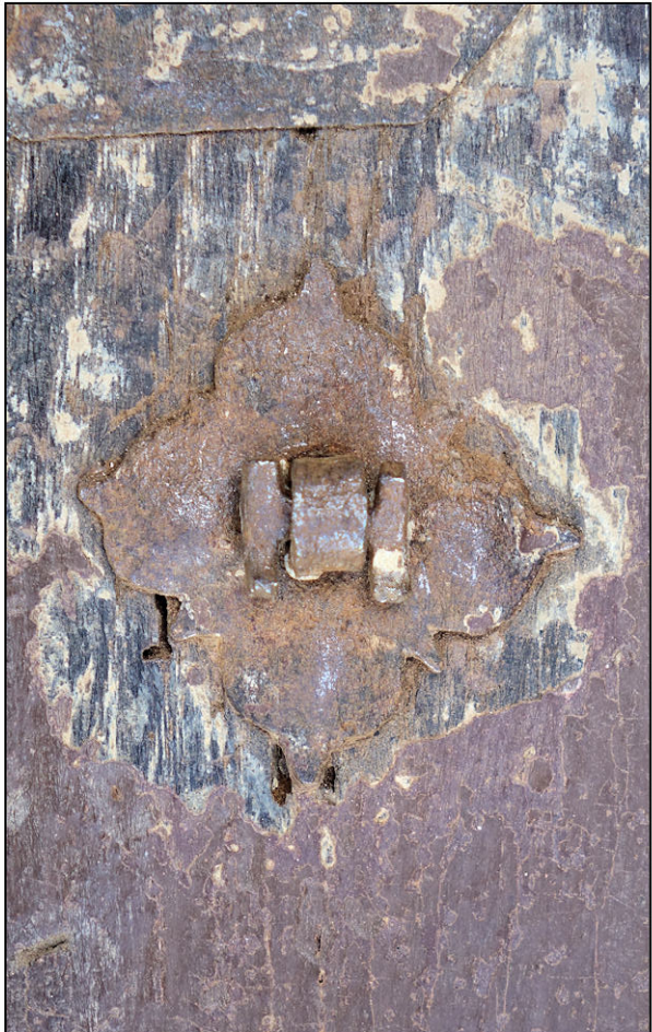
Fig. 4.4. Platine de pendeloque (2)
