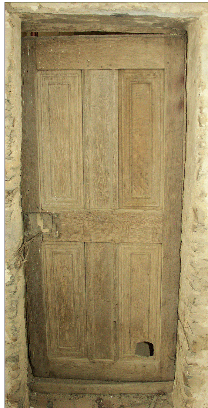
Fig. E.2. Vantaux de porte avec élégis identiques au châssis B
