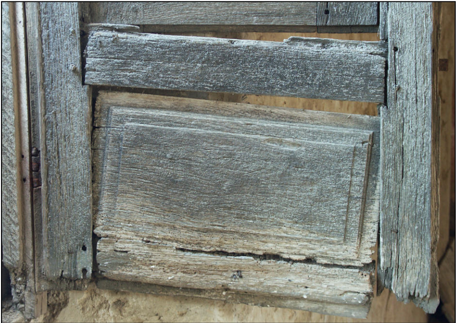
Fig. 2.5. Vantail vitré / soubassement à panneau
