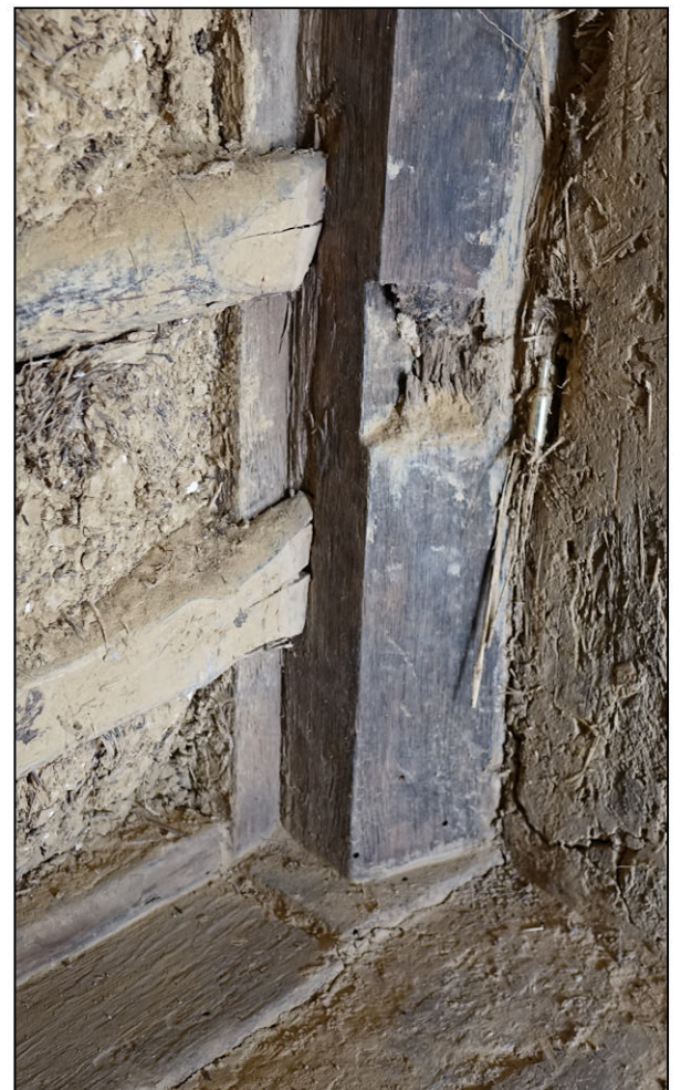
Fig. 2.6. Entaille de la fiche inférieure
