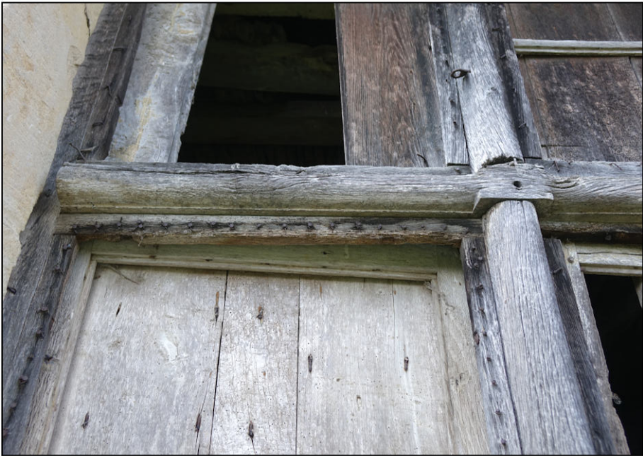
Fig. 7.2. Châssis C (meneau et croisillon)
