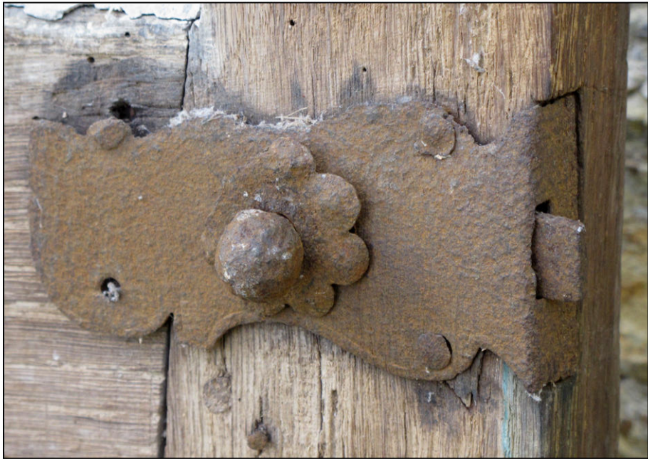
Fig. 4.1. Targette encloisonnée
