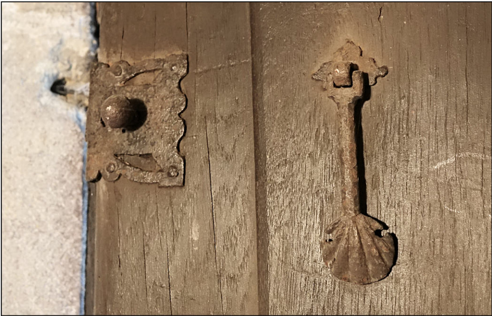
Fig. 4.2. Targette et pendeloque (volet supérieur)
