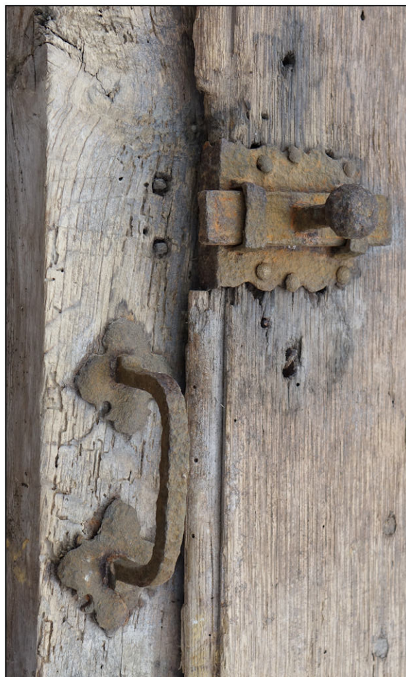
Fig. 5.4. Poignée verticale et targette
