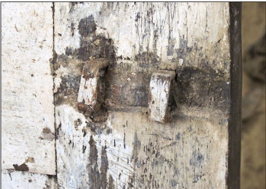
Fig. 2.6. Volet inférieur gauche / brides du pêne de la targette
