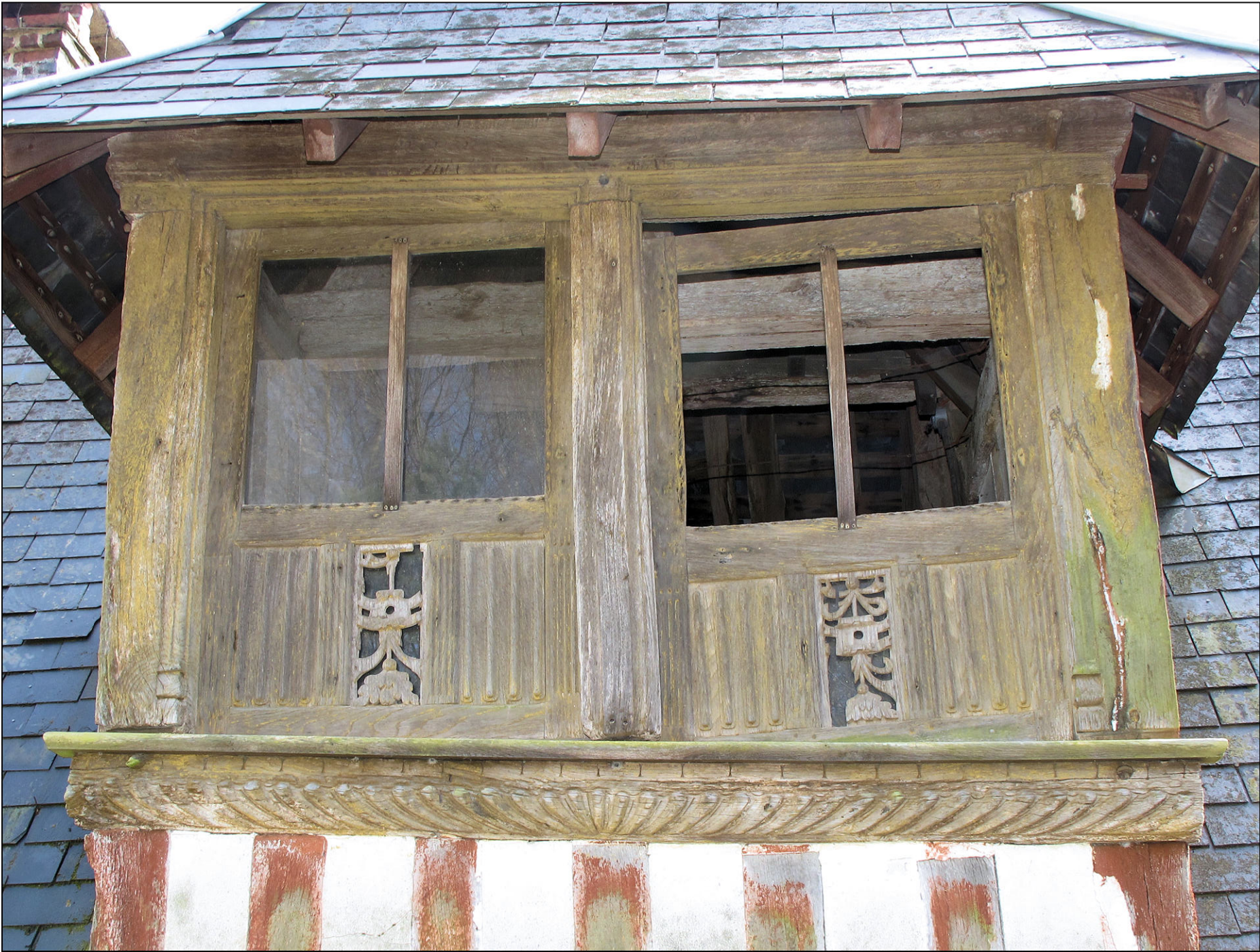
Fig. 1.1. Lucarne (façade nord-ouest)
