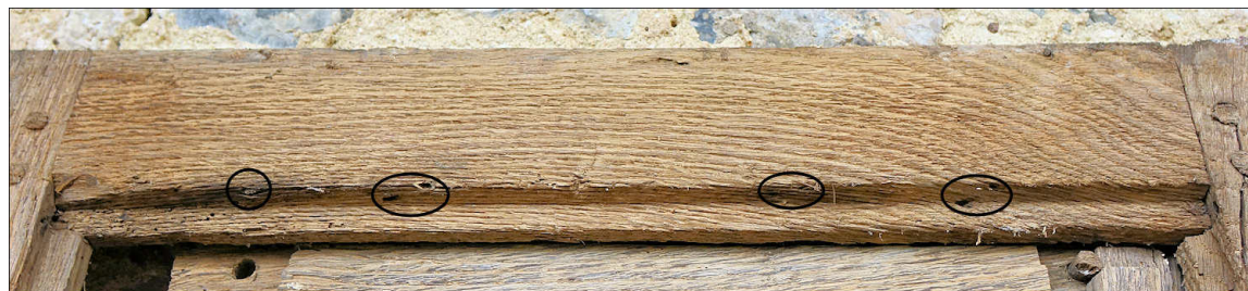
Fig. E.5. Le châssis A.1 Emplacements des clous de maintien de la vitrerie mise en plomb
