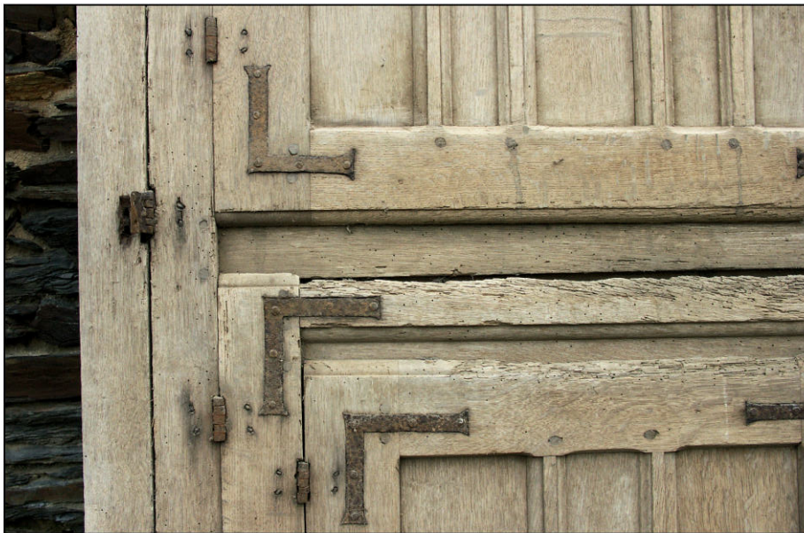
Fig. 3.3. Recouvrement des bâts
