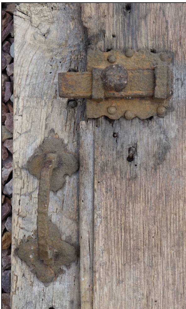
Fig. 5.3. Poignée verticale et targette
