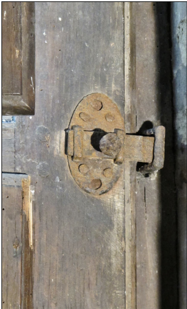
Fig. 2.5. Targette (vantail vitré)
