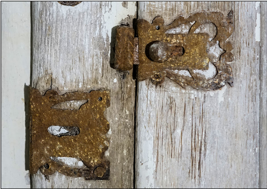
Fig. 3.1. Targettes encloisonnées (vantail et volet inférieur)
