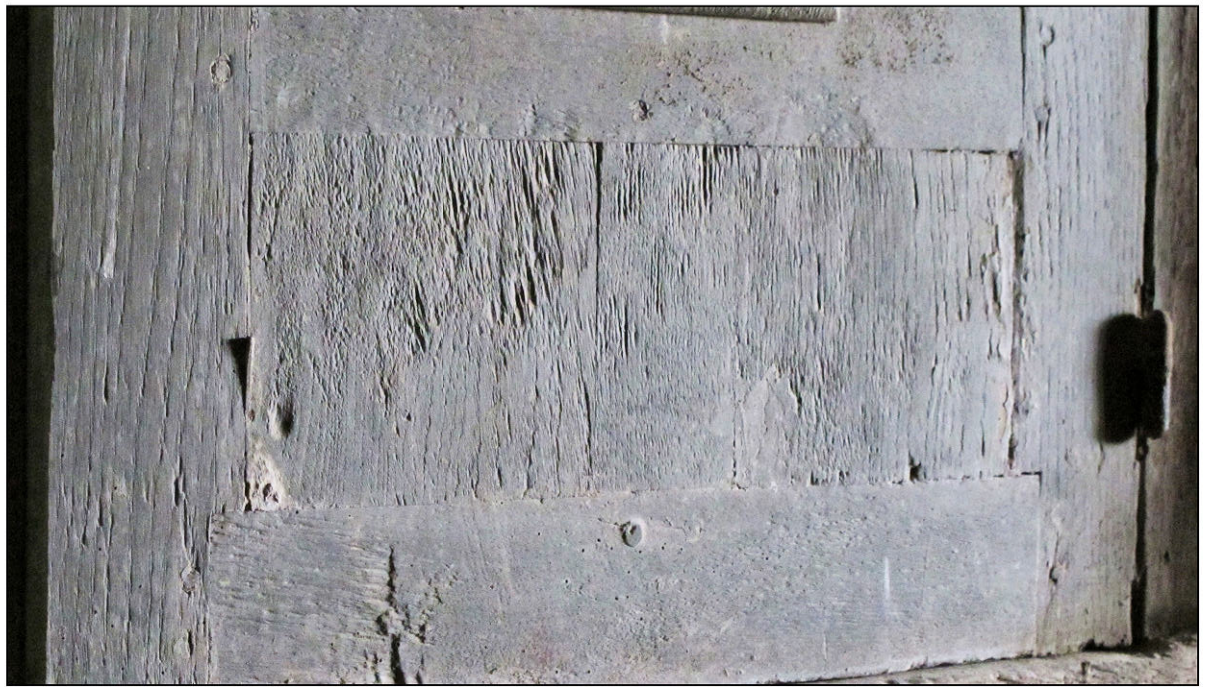
Fig. 7.2. Soubassement à panneaux (parties supérieure et inférieure)
