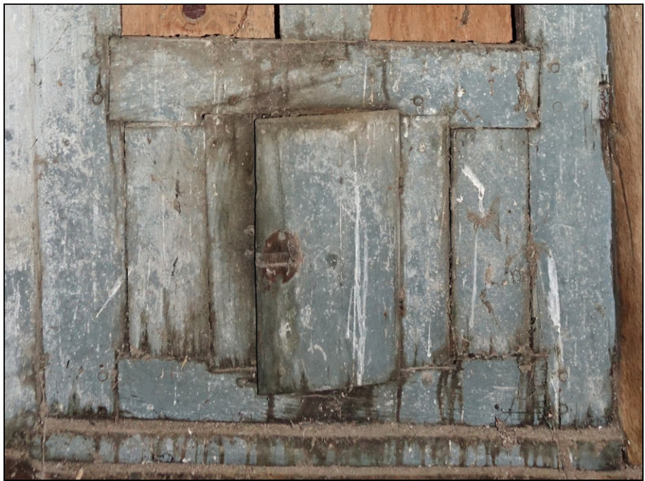
Fig. 5.3. Soubassement à panneaux et guichet (2013)
