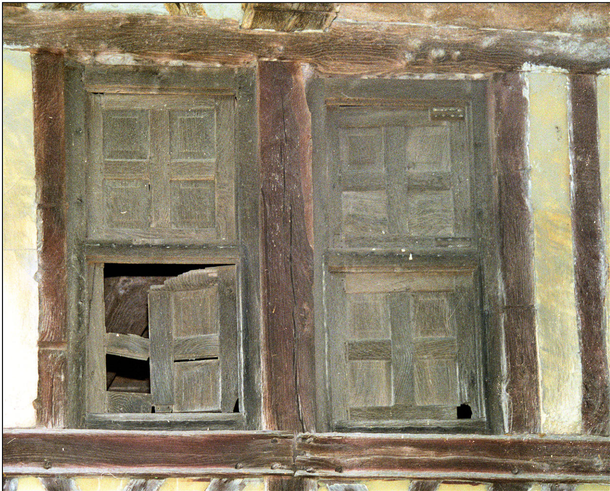
Fig. 9.3. Vantaux vitrés et volets (élévation extérieure)
