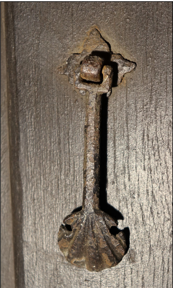
Fig. 4.5. Pendeloque (volet inférieur)
