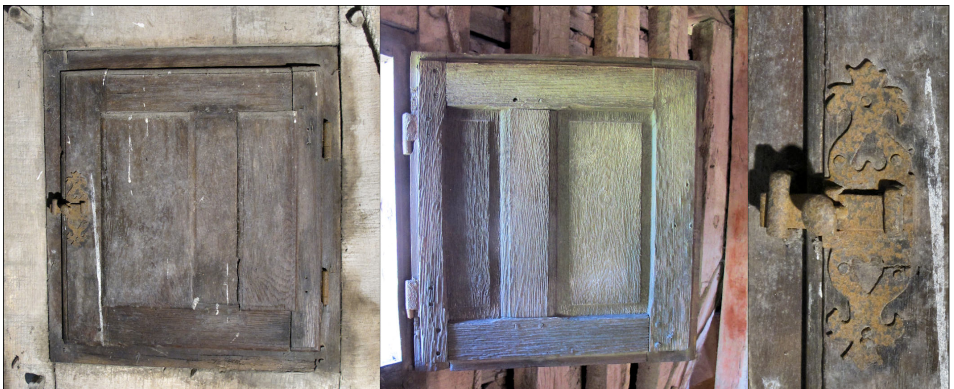
Fig. E.3. Volet en réemploi (targette et fiches à gond ajoutées)
