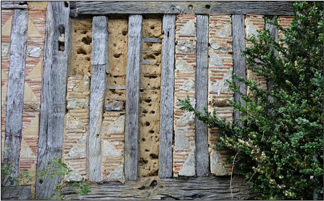
Fig. 1.4. Pan de bois et hourdis de pierres, tuileaux et silex (pignon sud)
