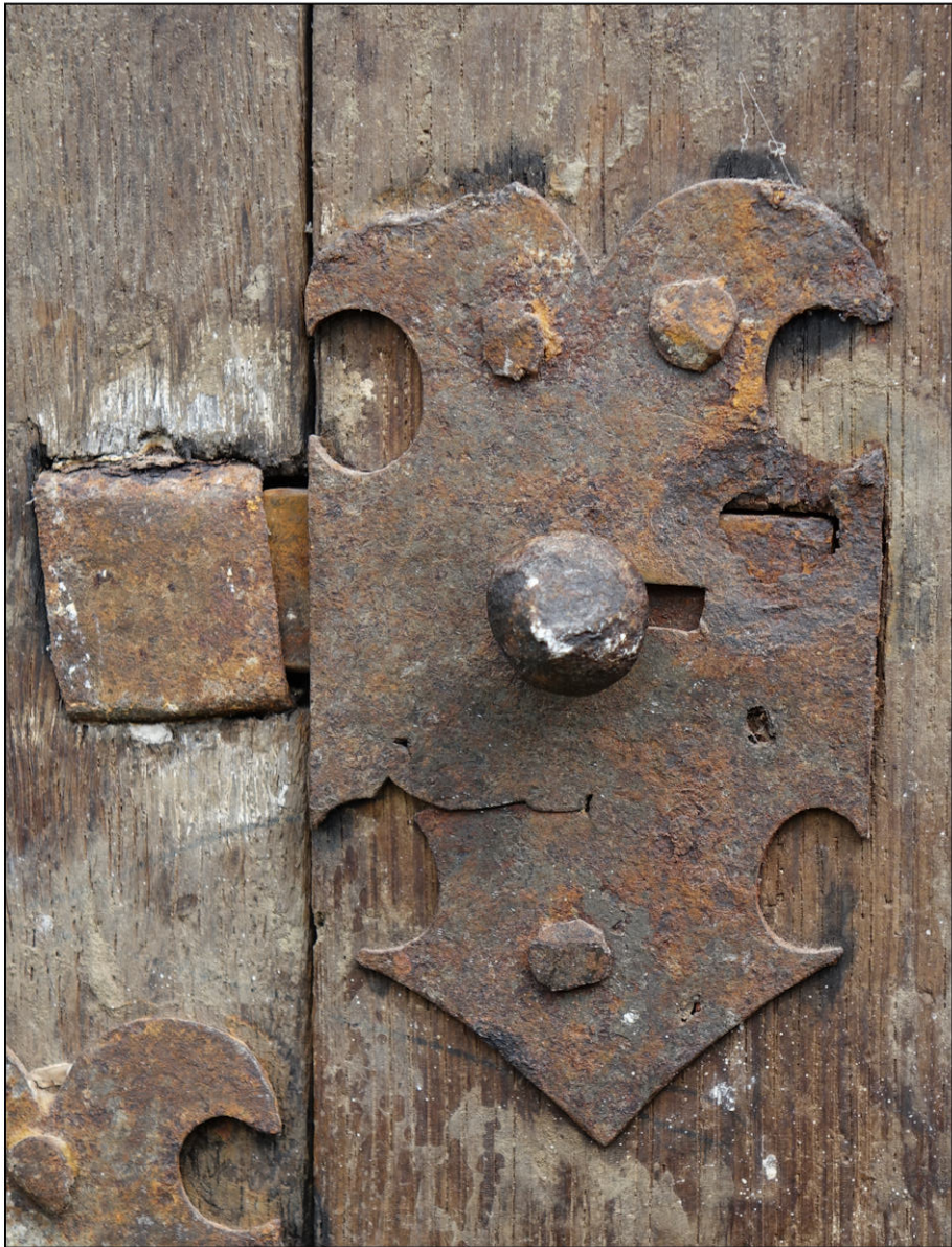
Fig. 4.1. Targette encloisonnée (volet)
