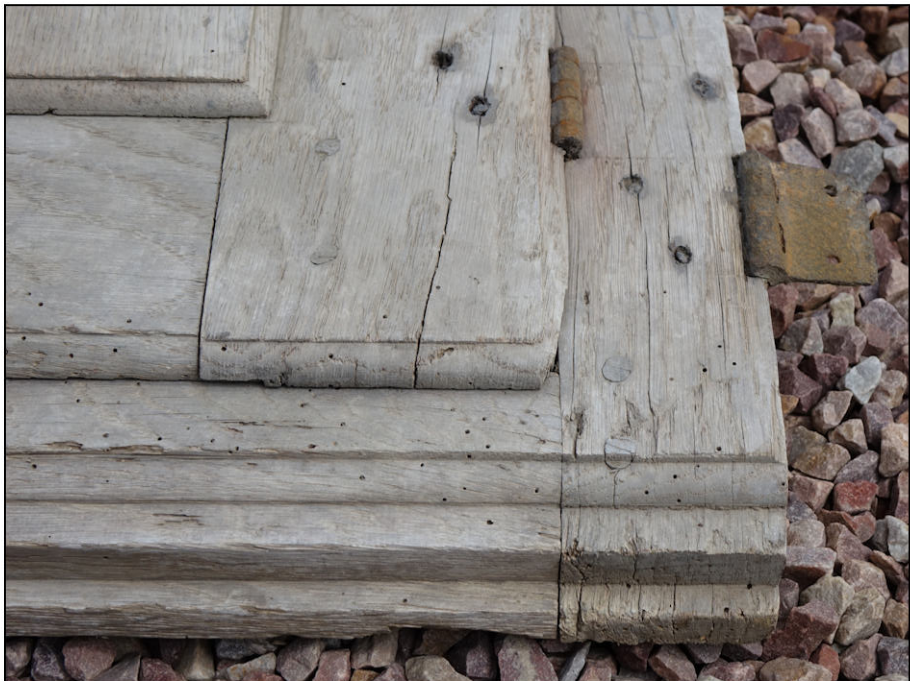
Fig. 9.6. Feuillures de recouvrement
