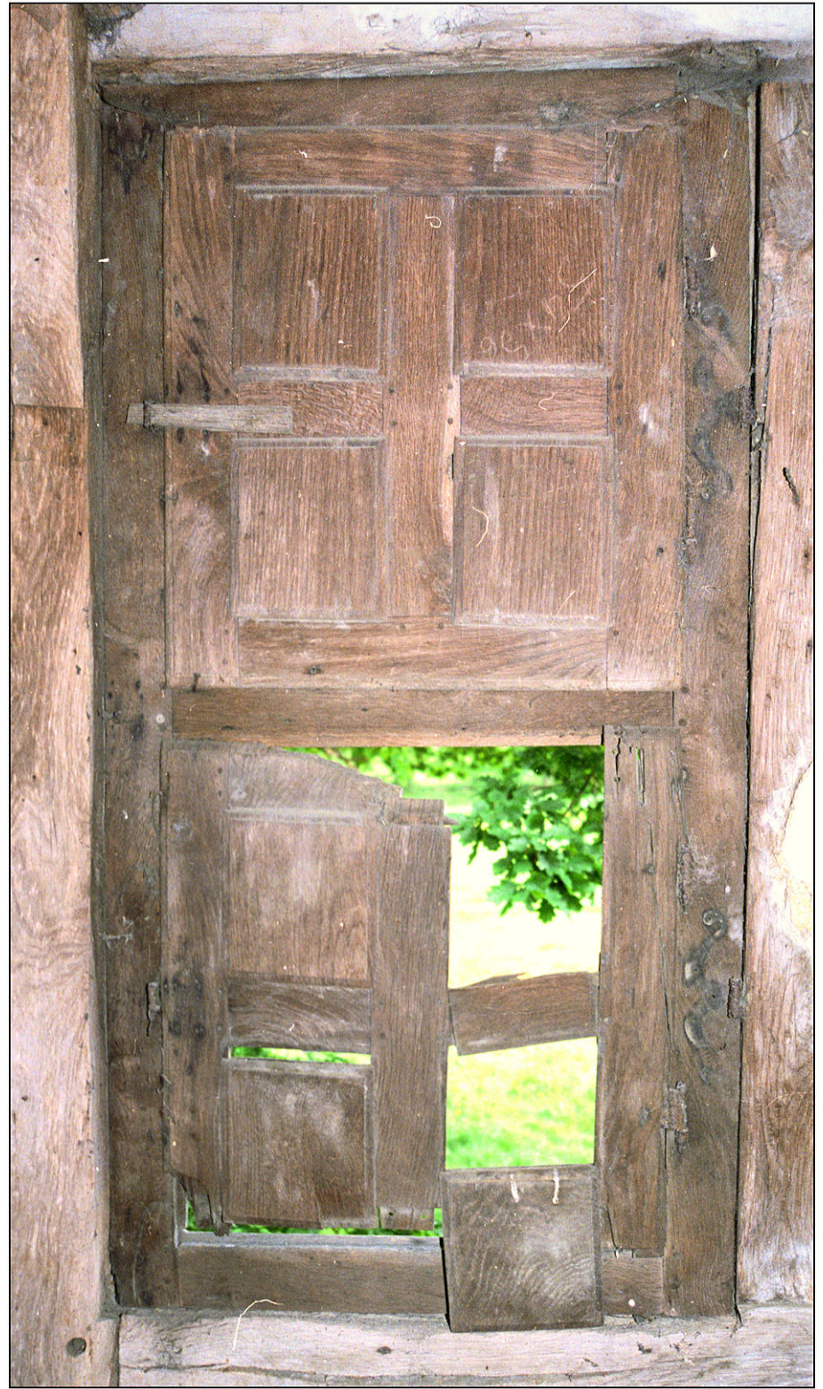
Fig. 10.2. Vantail vitré et volets droits
