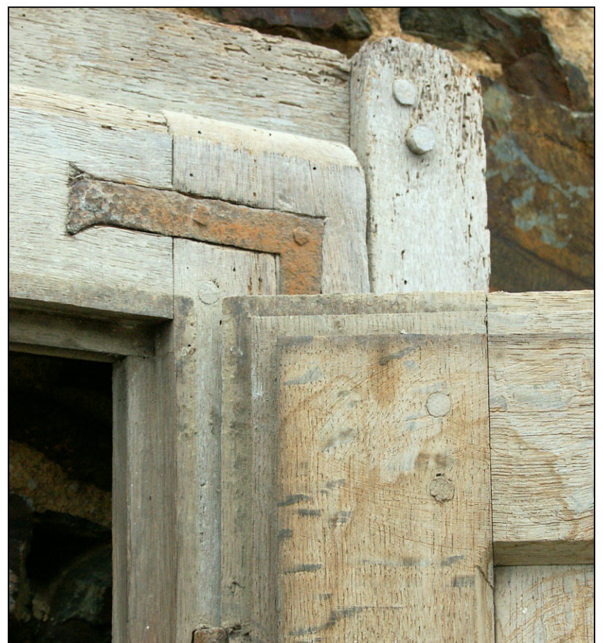
Fig. 4.4. Recouvrement des bâtis
