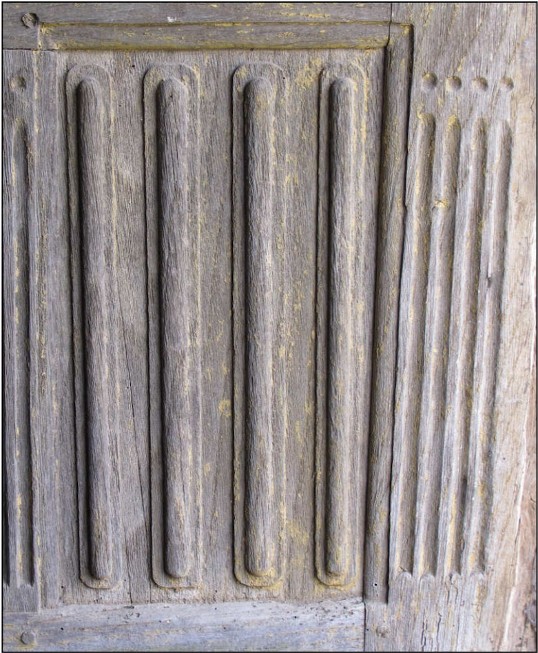
Fig. 2.4. Montants cannelés et panneau à baguettes
