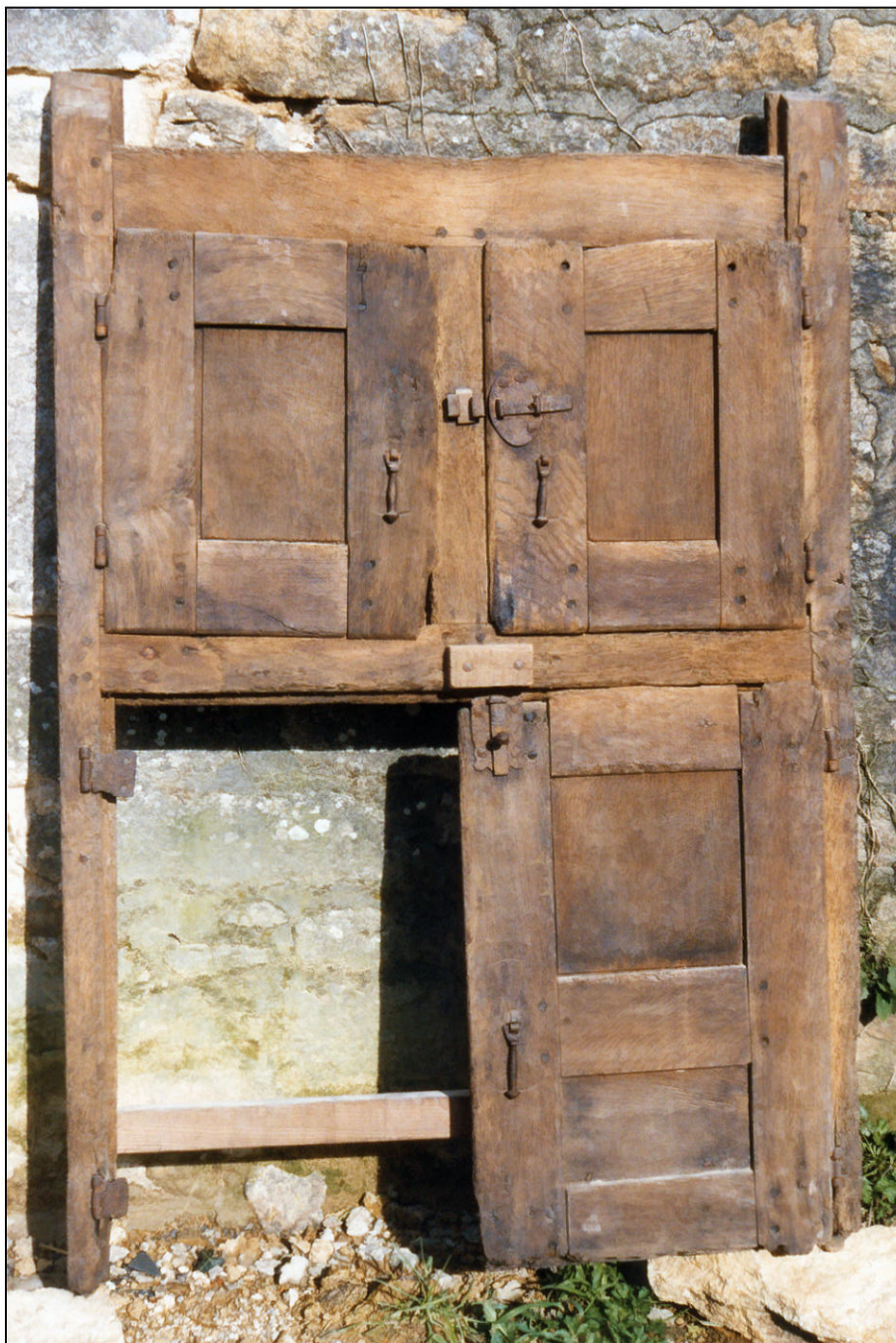
Fig. 1.1. Croisée (élévation intérieure)
