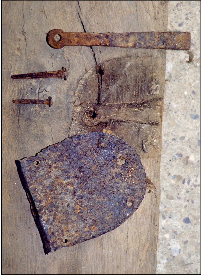
Fig. 3.3. Loquet (volet supérieur gauche)
