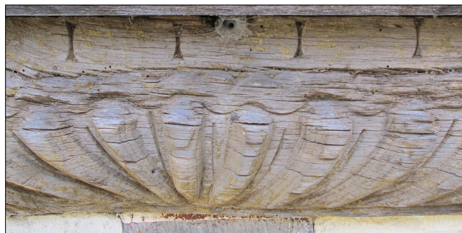
Fig. E.1. Détail des godrons de l'appui de fenêtre de la lucarne.
