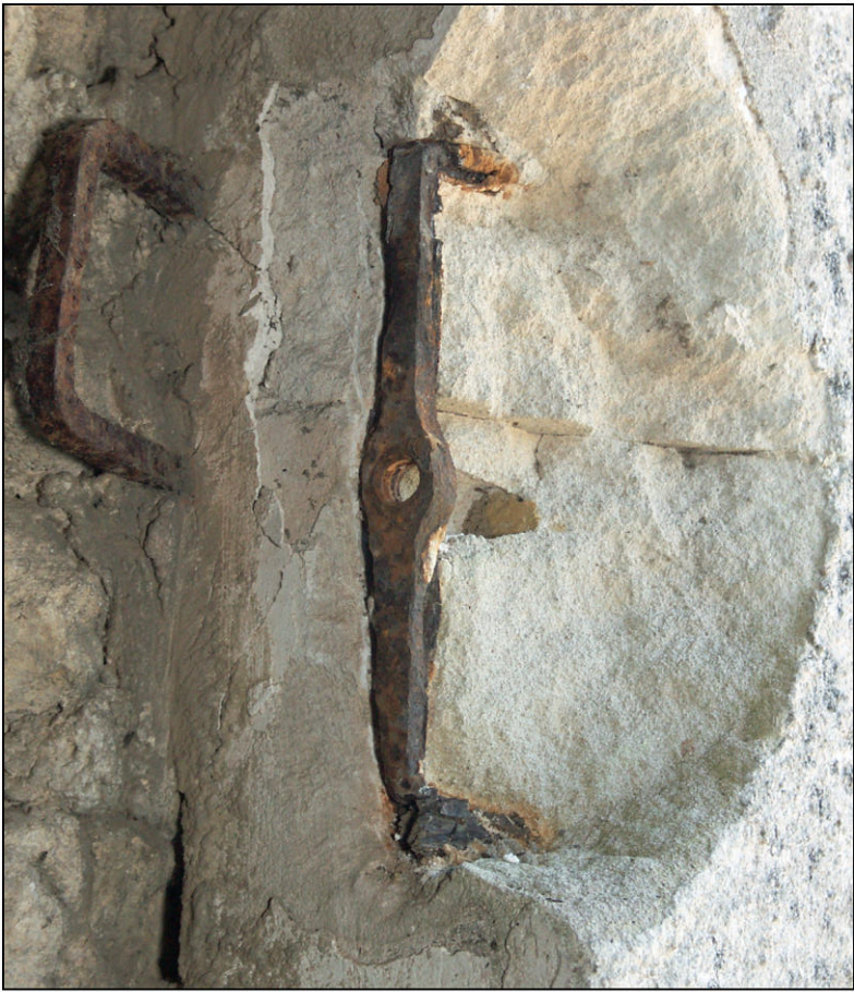
Fig. 3.4. Agrafe scellée dans le meneau
