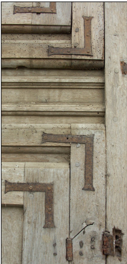
Fig. 1.4. Equerres et fiches
