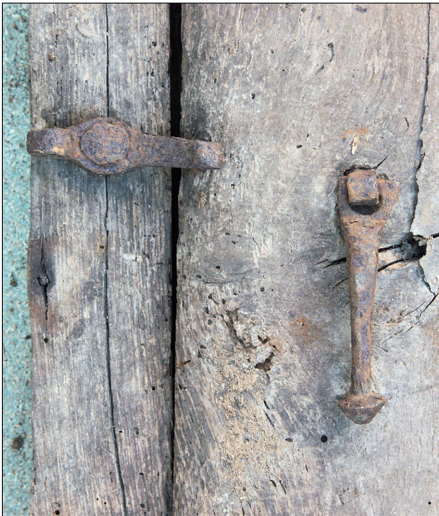
Fig. 6.3. Tourniquet et pendeloque
