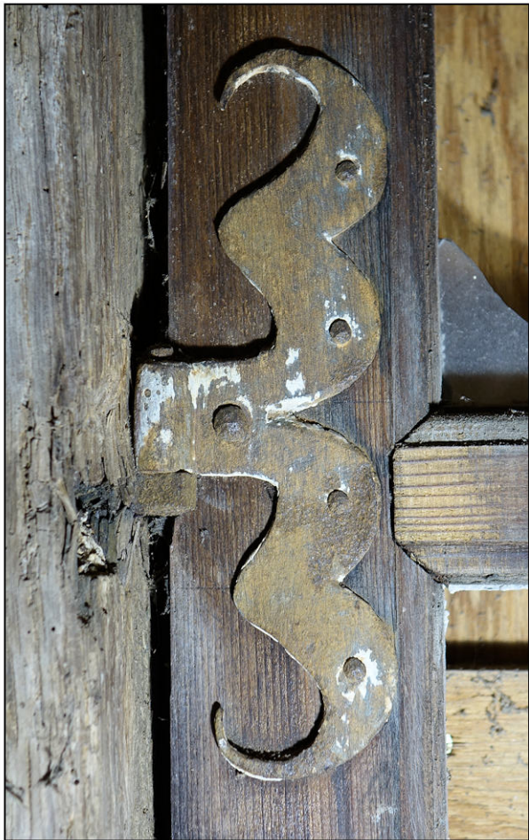
Fig. 11.7. Paumelle à moustaches (réemploi)
