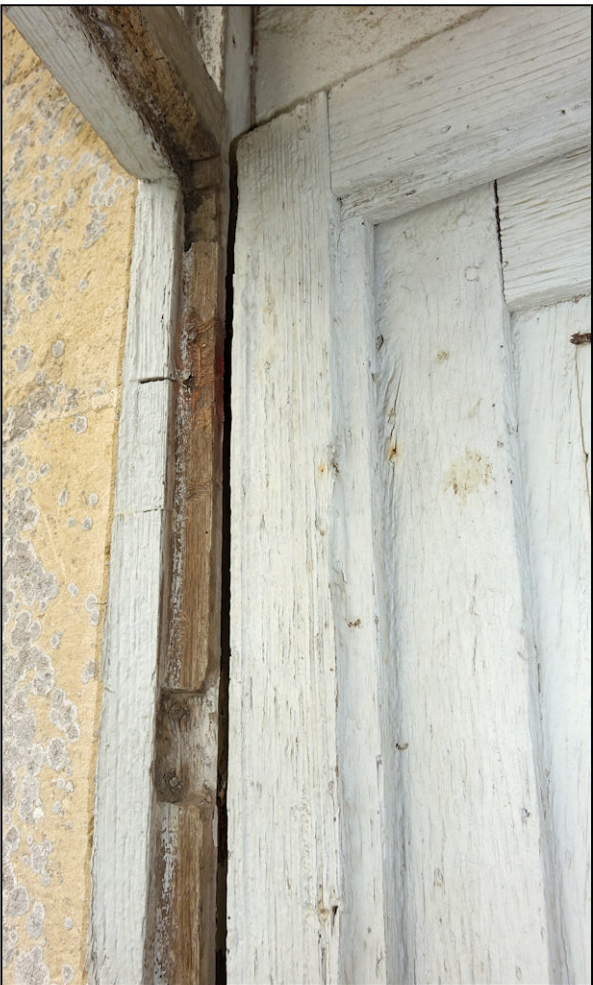
Fig. 3.6. Bâti dormant et vantail vitré
