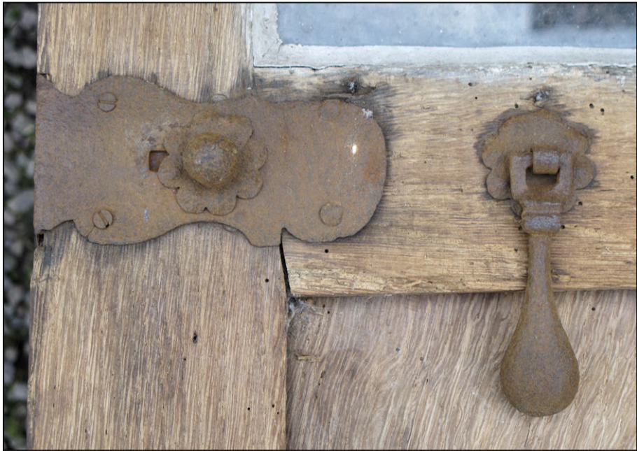
Fig. 4.2. Targette encloisonnée et pendeloque
