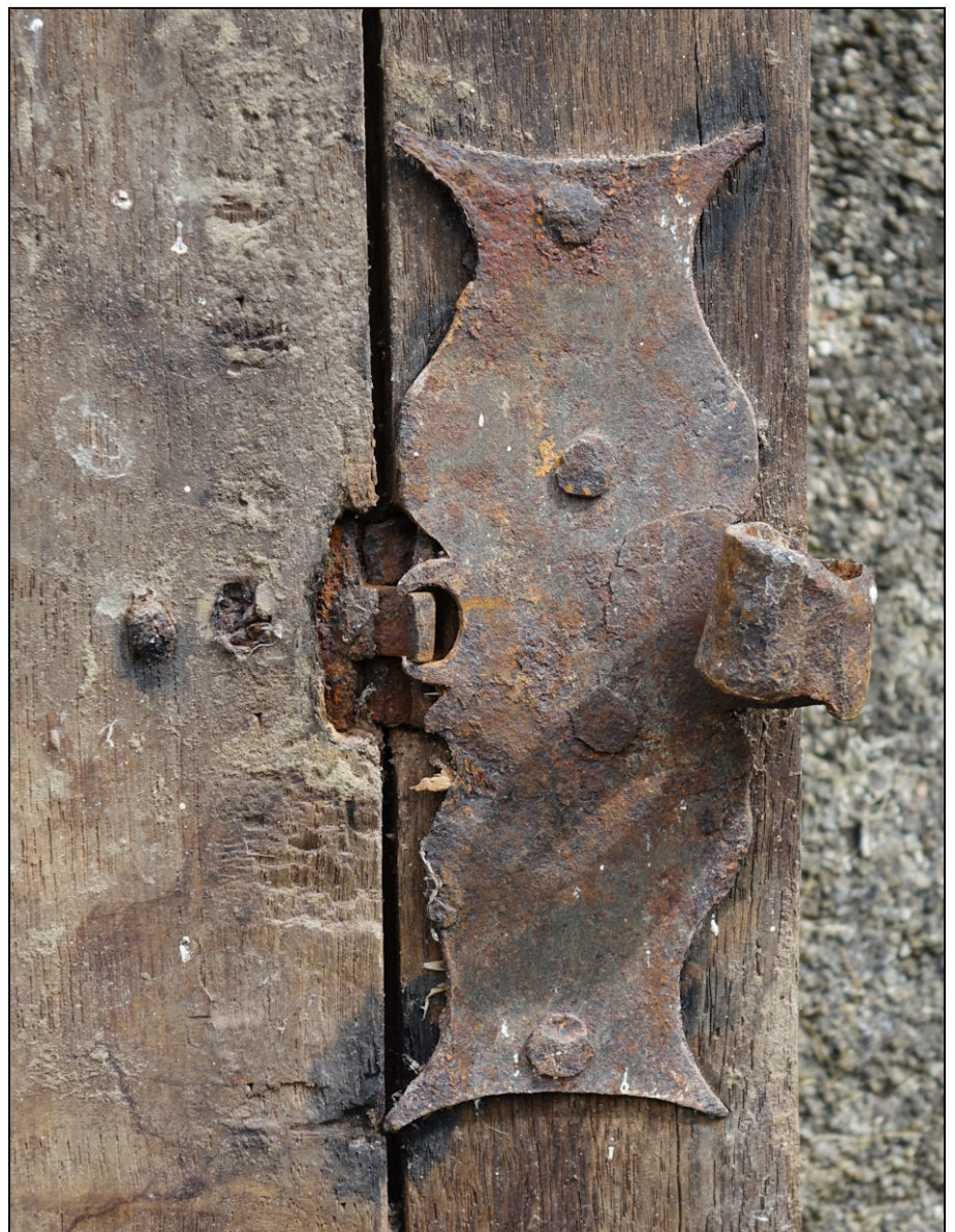
Fig. 4.4. Fiche et paumelle inférieures
