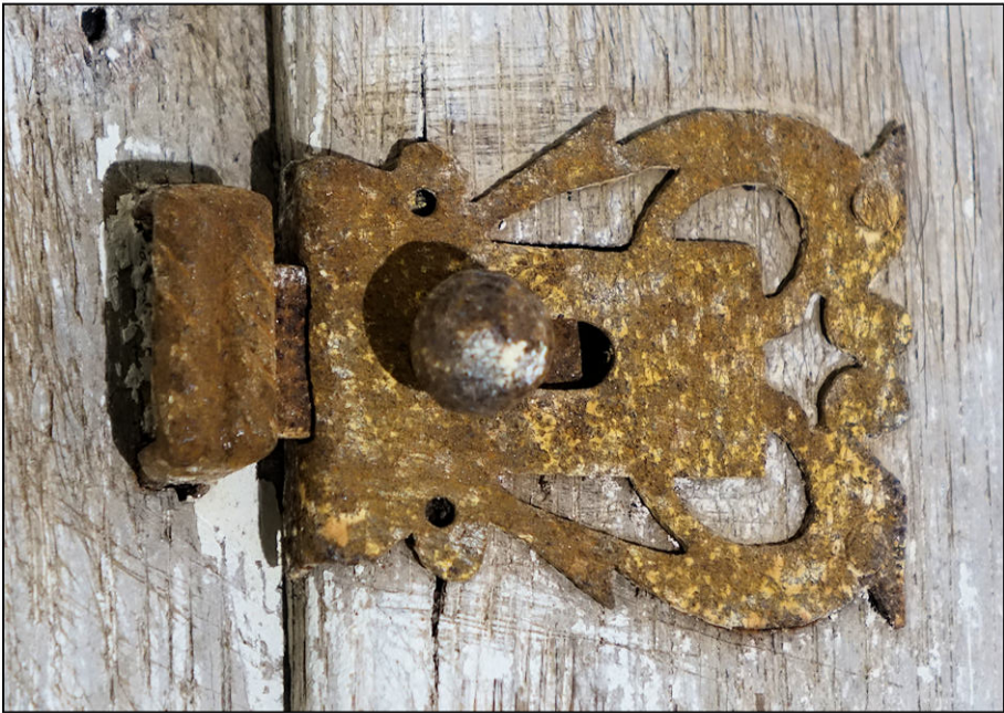
Fig. 3.2. Targette encloisonnée (volet supérieur)
