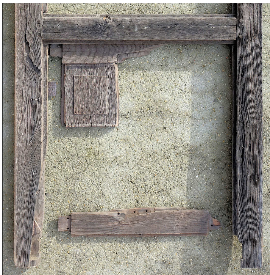
Fig. E.9. Le châssis C (face extérieure) Traverse haute du vantail et compartiment inférieur
