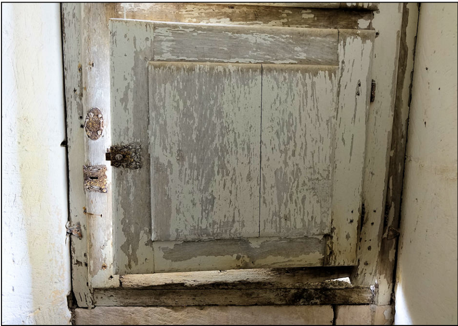
Fig. 3.4. Vantail vitré et volet inférieur (vue intérieure)
