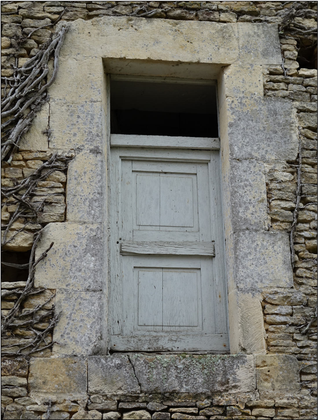
Fig. 2.1. Châssis (vue extérieure)
