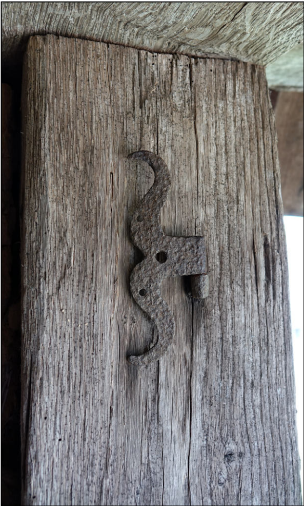
Fig. 11.2. Paumelle à moustaches
