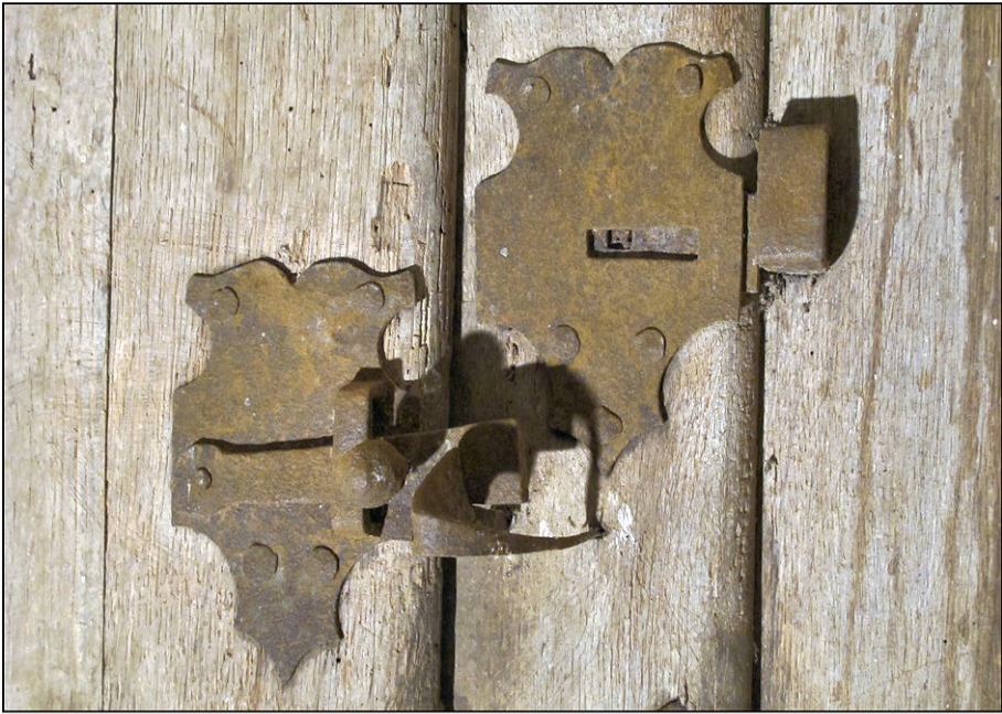
Fig. 3.6. Loquet et targette enclouonnée
