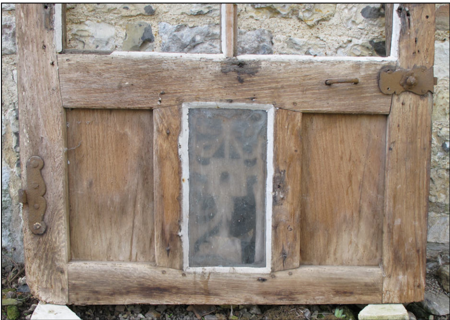
Fig. 2.6. Soubassement à panneaux
