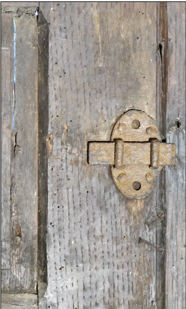
Fig. 2.4. Targette (volet inférieur)
