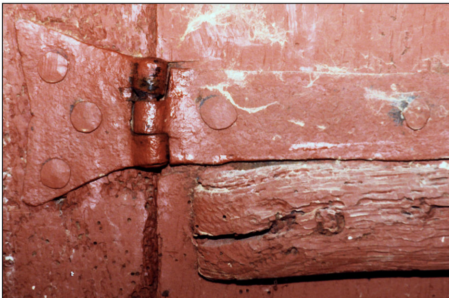
Fig. 3.5. Charnière inférieure (détail)
