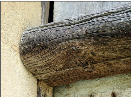
Fig. 7.7. Châssis D (traverse moulurée)
