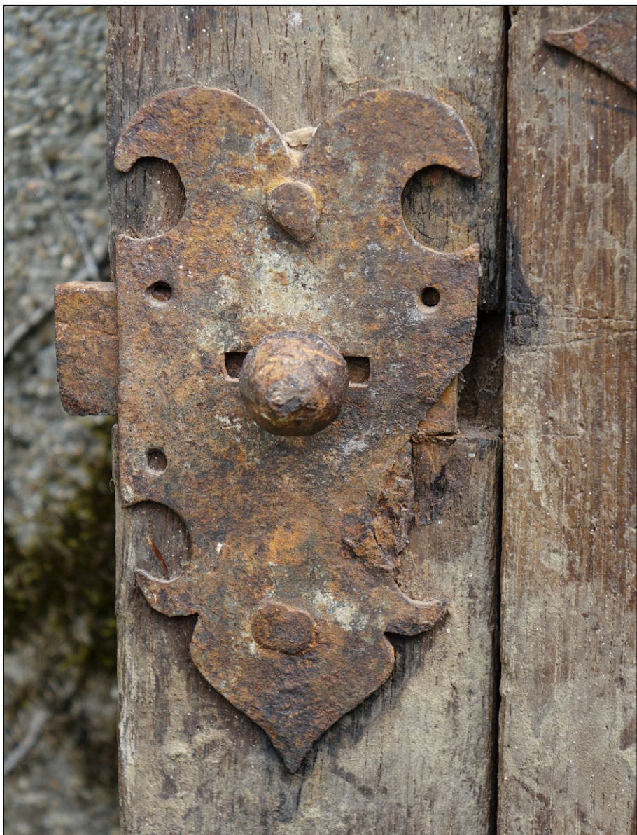
Fig. 4.3. Targette encloisonnée (vantail vitré)
