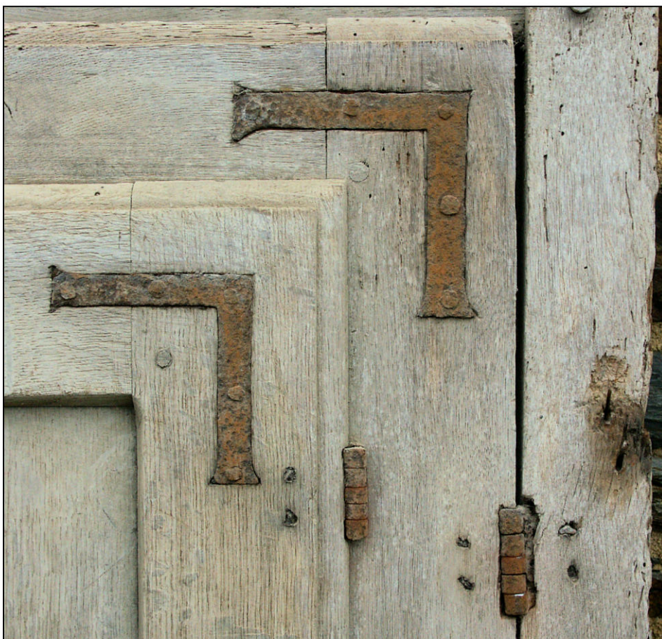
Fig. 4.3. Equerres et fiches
