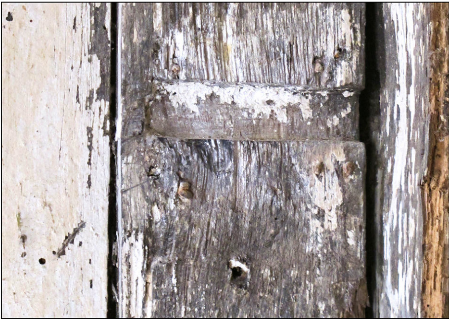
Fig. 2.3. Volet supérieur gauche / entaille du pêne de la targette
