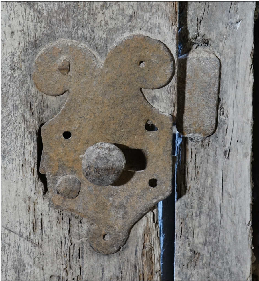
Fig. 2.4. Targette encloisonnée
