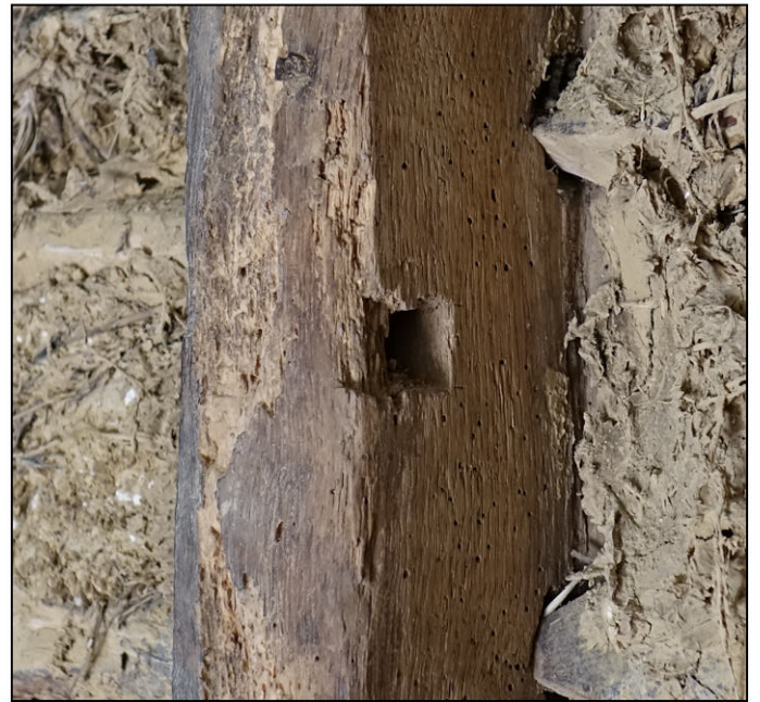
Fig. 2.3. Gâche supérieure du meneau
