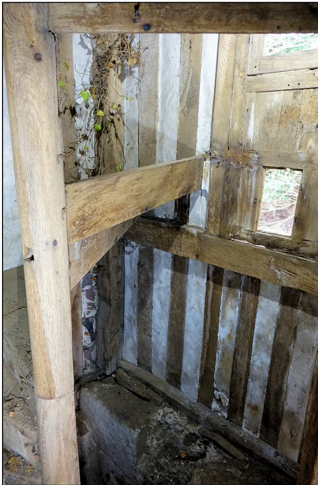
Fig. 4.3. Escalier (3 marches déposées)
