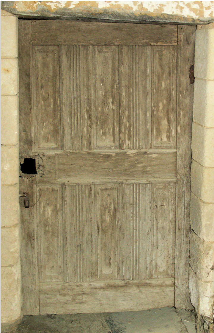
Fig. E.3. Vantail de porte avec élégis cannelés proches des panneaux de la croisée C
