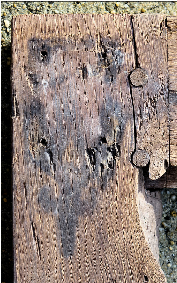
Fig. 11.5. Fantôme du verrou vertical
