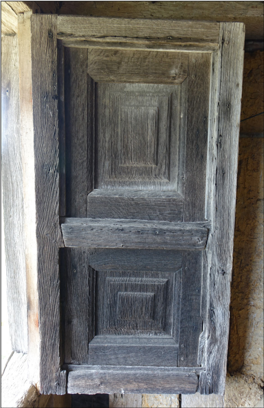
Fig. 8.2. Vantail et volets droits
