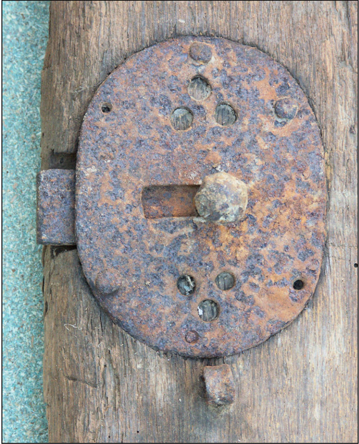
Fig. 3.2. Targette encoisonnée (volet intermédiaire droit)
