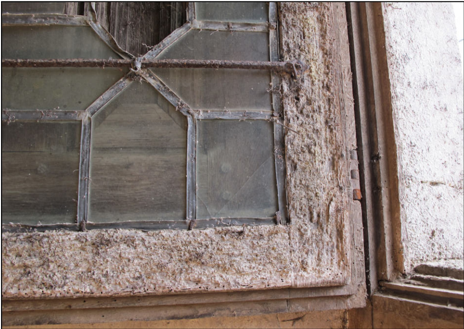
Fig. 2.5. Vitrerie à bornes en carré
