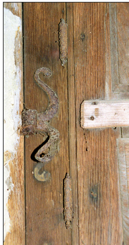
Fig. 10.4. Paumelle à moustaches
