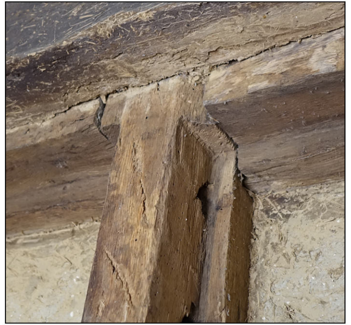
Fig. 2.2 Asemblage du meneau
