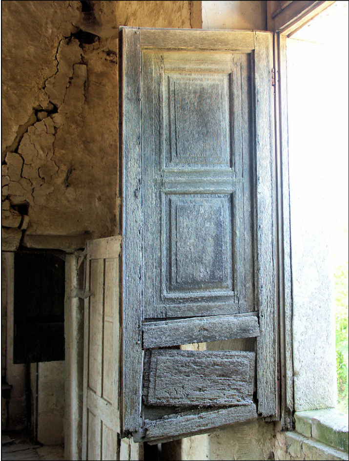
Fig. 2.1. Vantail vitré et volet
