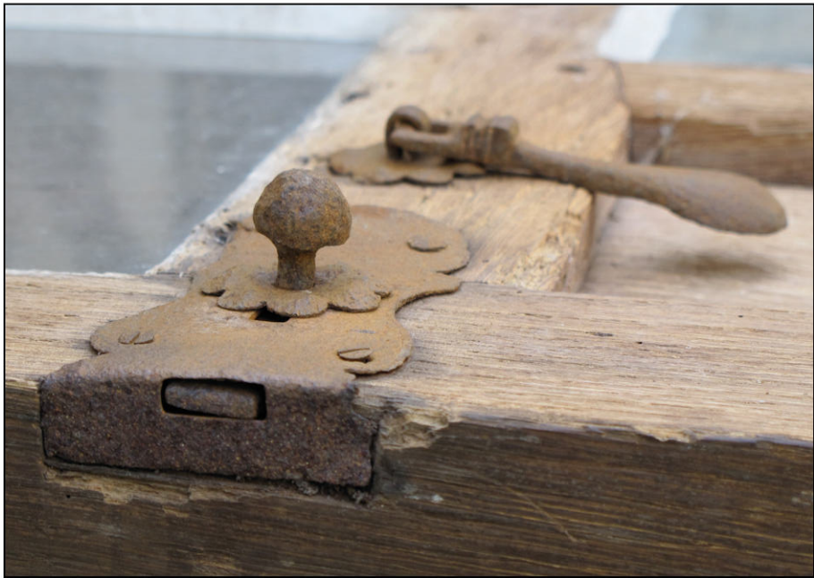
Fig. 4.4. Targette encloisonnée et pendeloque
