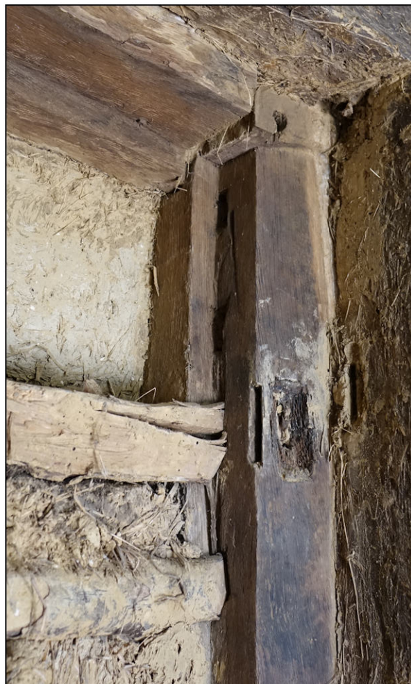
Fig. 2.5. Entaille de la fiche supérieure
