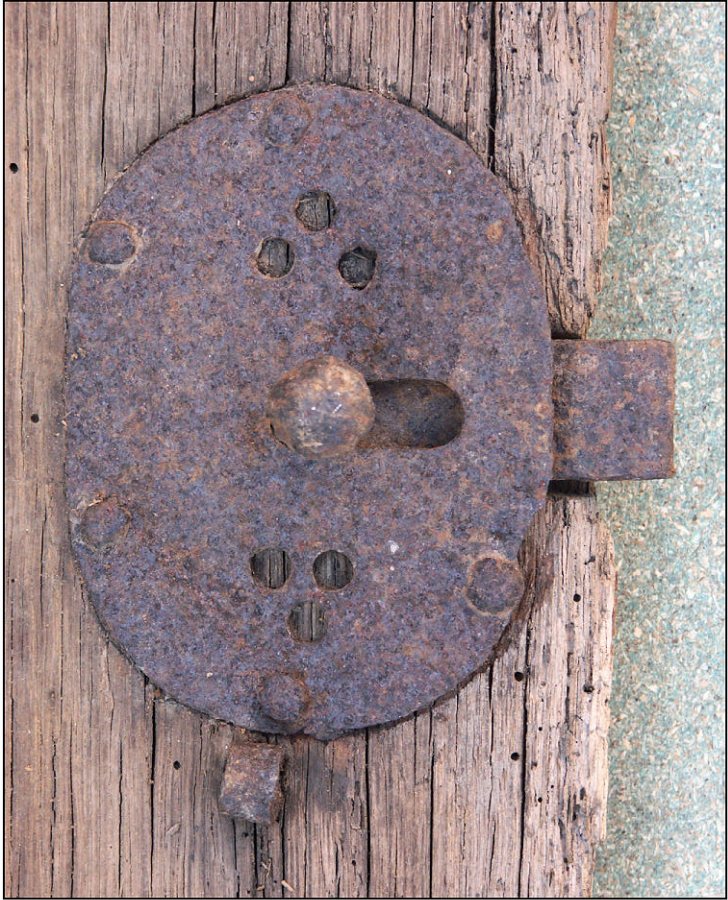
Fig. 3.4. Targette encoisonnée (volet inférieur gauche)
