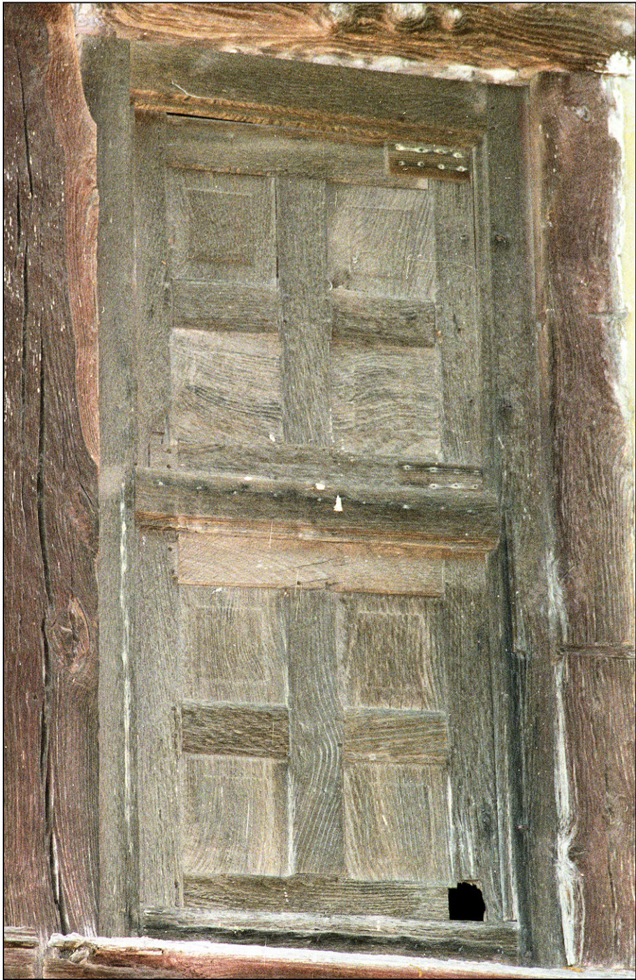
Fig. 9.2. Vantail vitré et volets gauches
