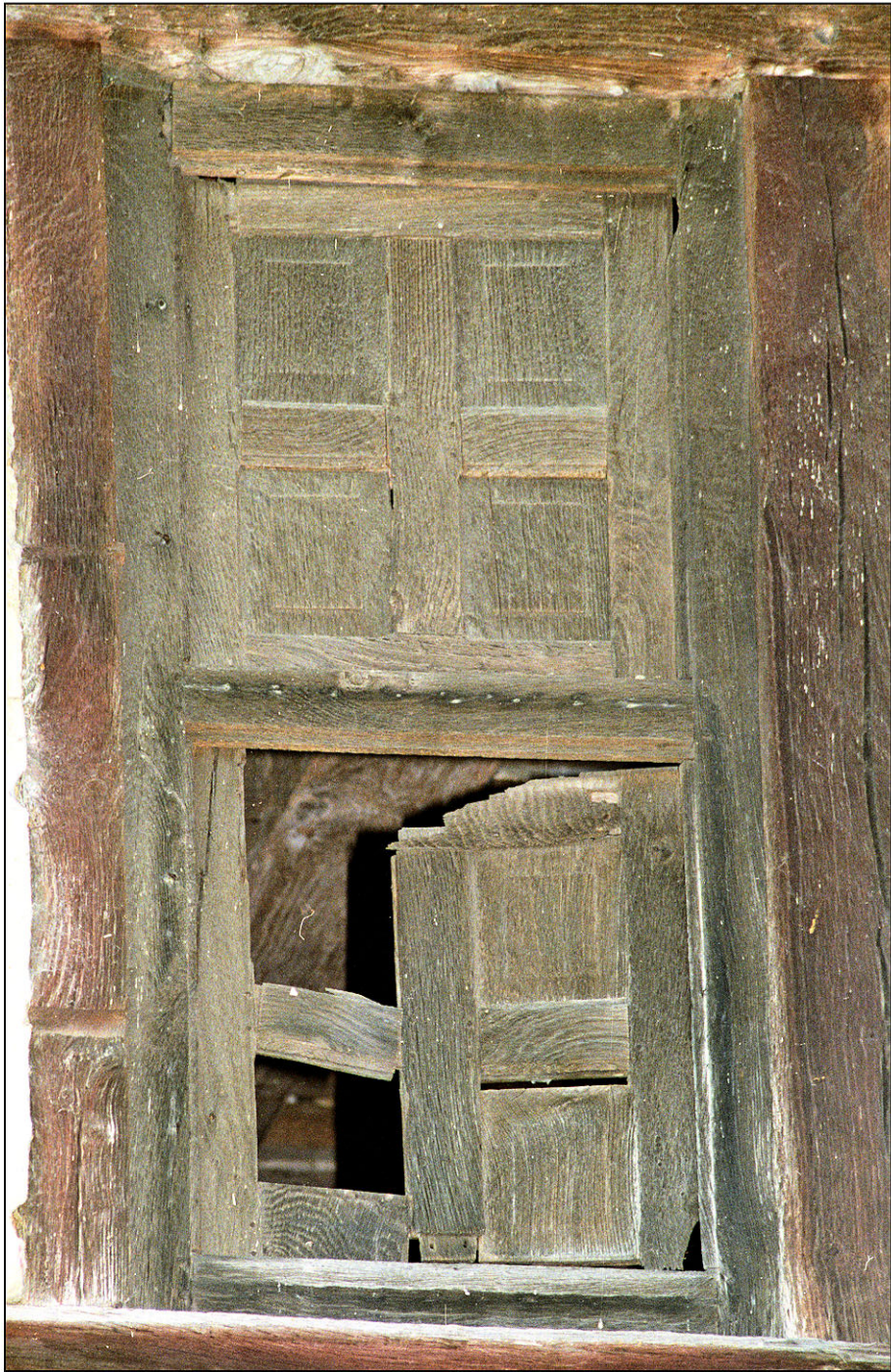
Fig. 9.1. Vantail vitré et volets droits
