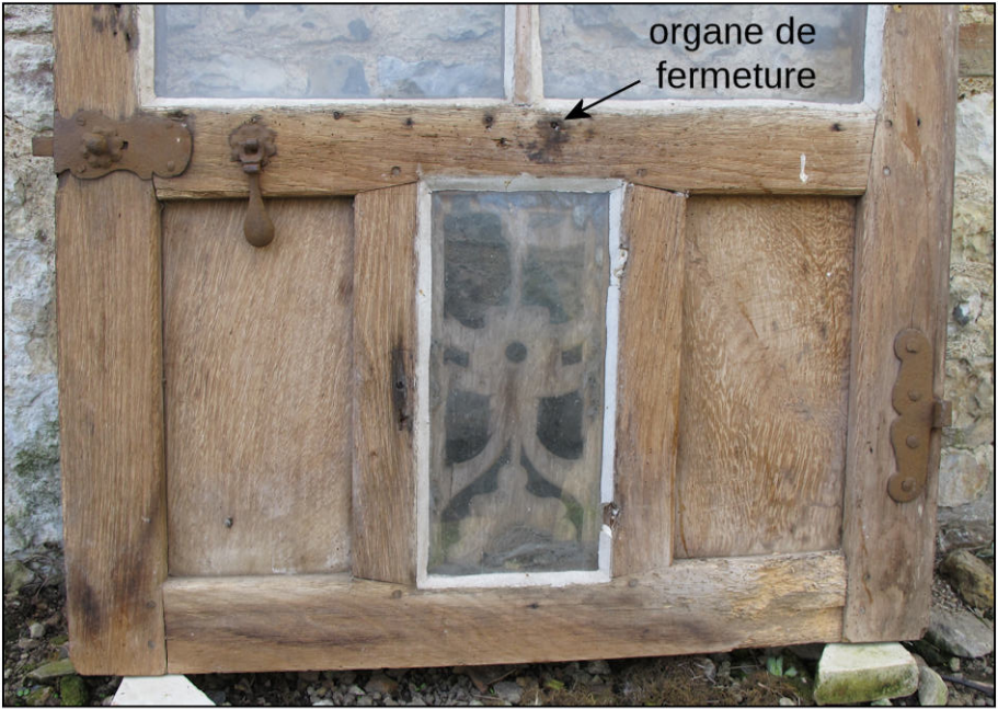
Fig. 3.6. Soubassement à panneaux
