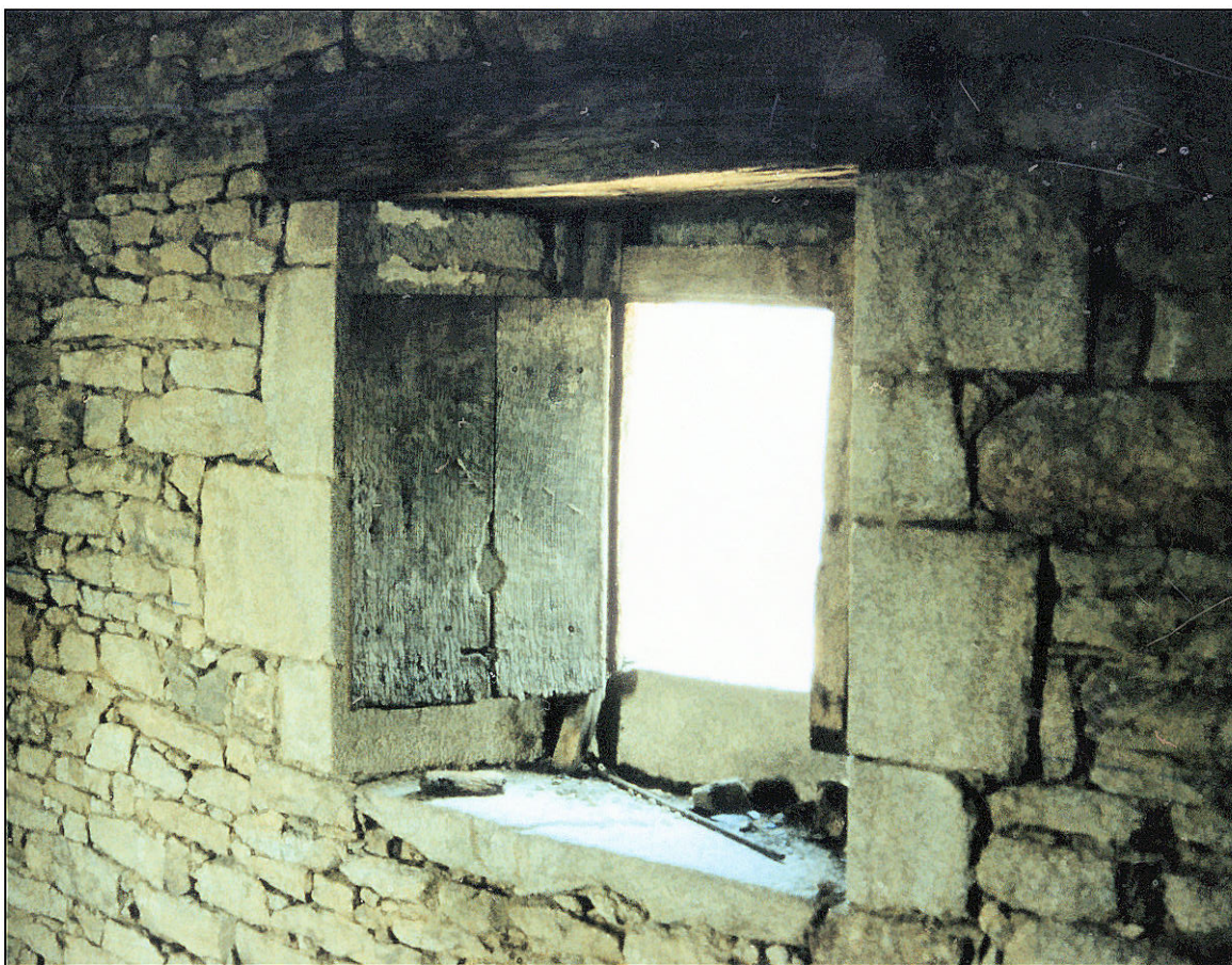
Fig. 3.3. Volet (élévation extérieure / avant restauration)
