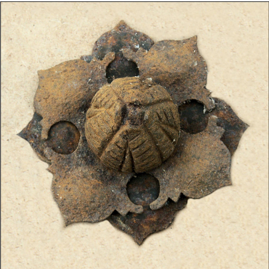
Fig. 3.4. Boulon et rosace (bâti dormant)
