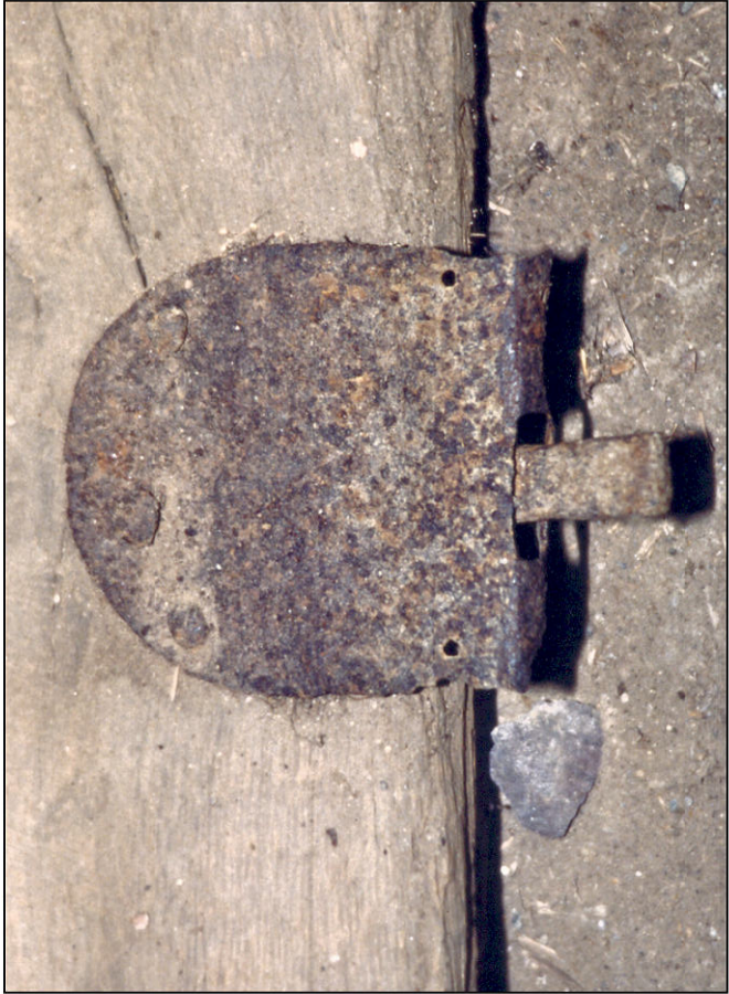
Fig. 3.1. Loquet (volet supérieur gauche)
