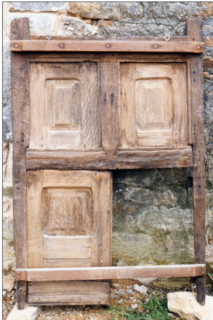
Fig. 1.2. Croisée (élévation extérieure)
