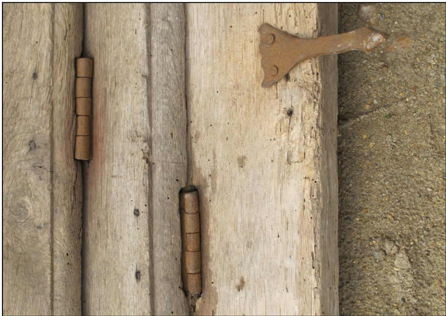
Fig. 5.5. Fiches et pattes à sceller
