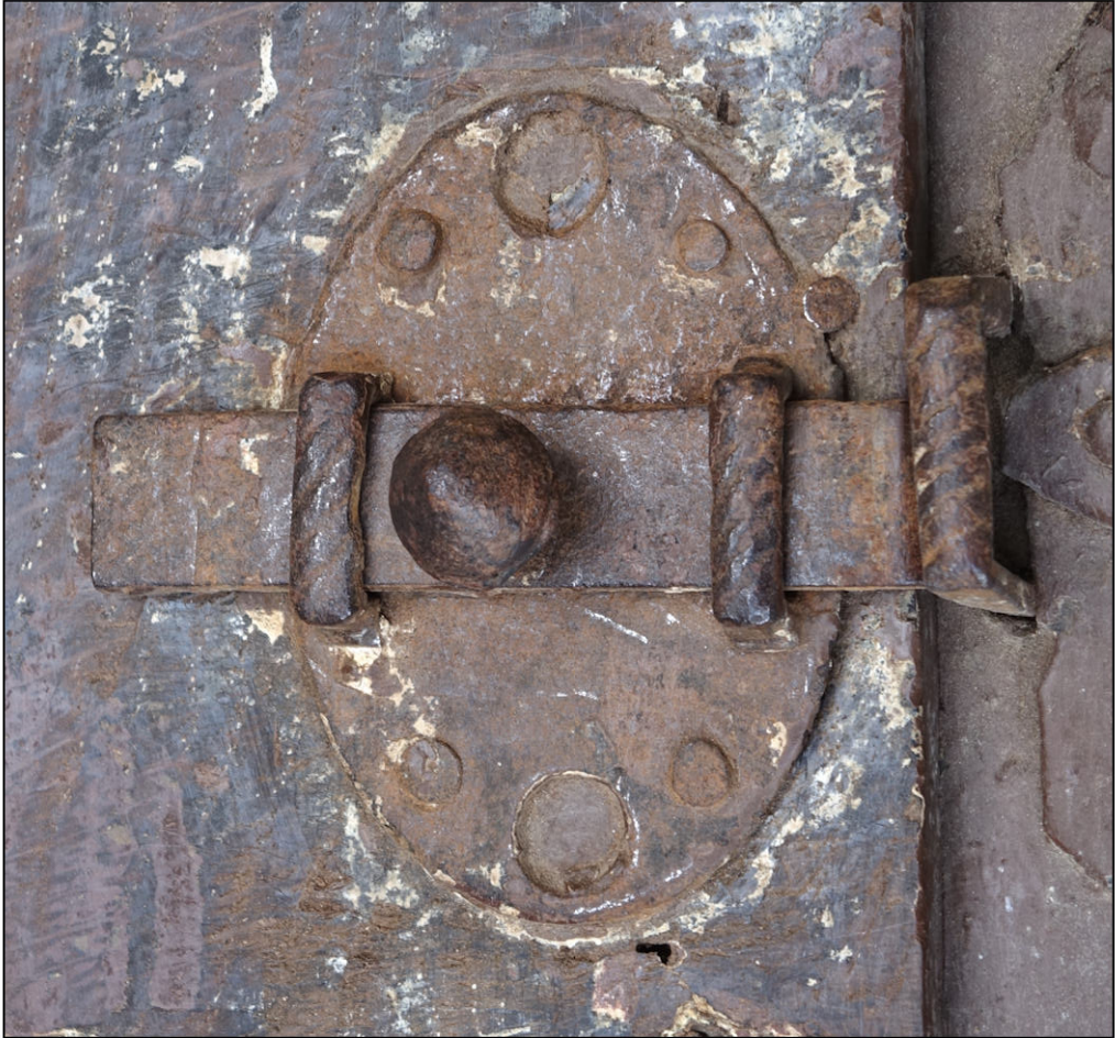
Fig. 4.2. Targette et gâche (volet 1)
