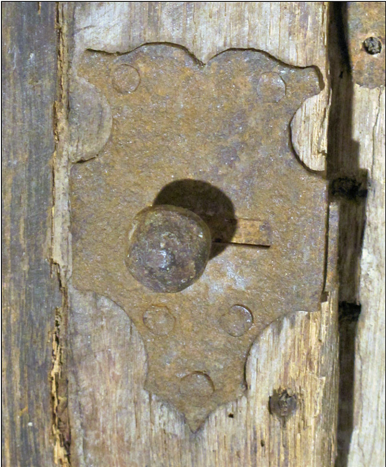
Fig. 2.3. Targette encoisonnée
