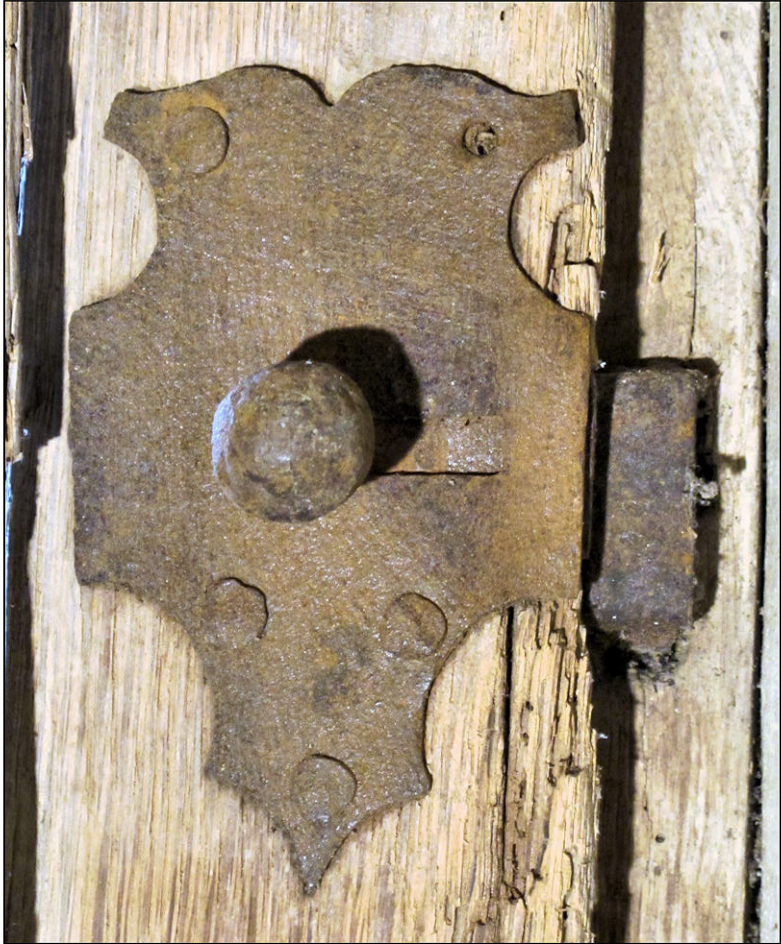
Fig. 2.2. Targette encoisonnée
