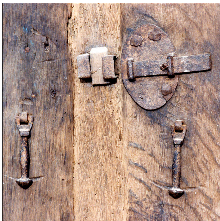
Fig. 1.4. Targette et pendeloques
