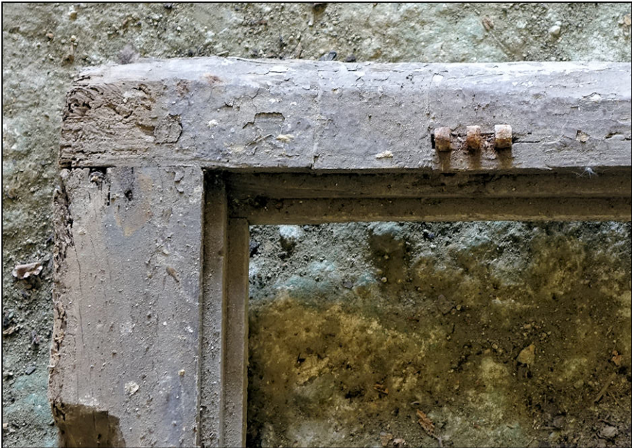
Fig. 4.6. Bâti dormant / fiche à broche rivée
