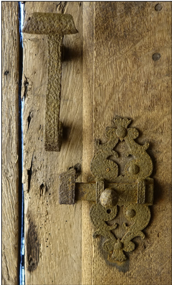
Fig. 7.4. Pendeloque et targette
