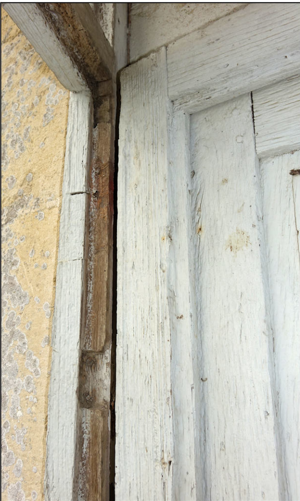
Fig. 3.6. Bâti dormant et vantail vitré
