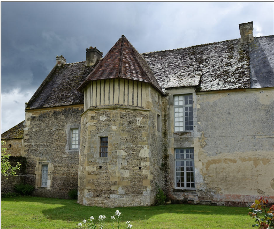
Fig. 1.4. Logis primitif (façade nord)
