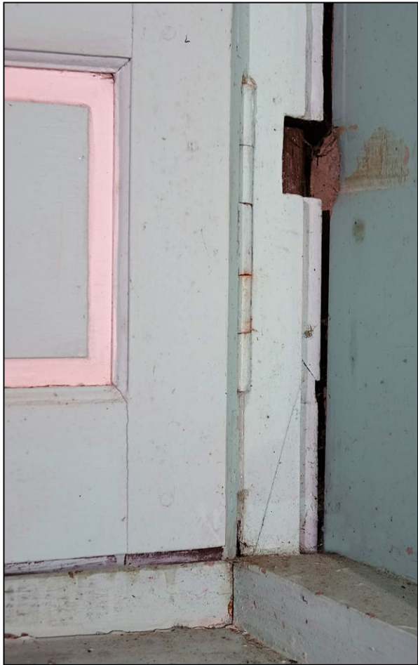
Fig. 12.3. Bâti dormant enturé
