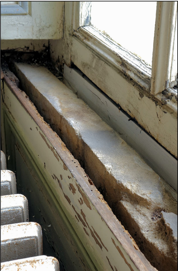
Fig. 6.4. Relevé de l'appui en pierre
