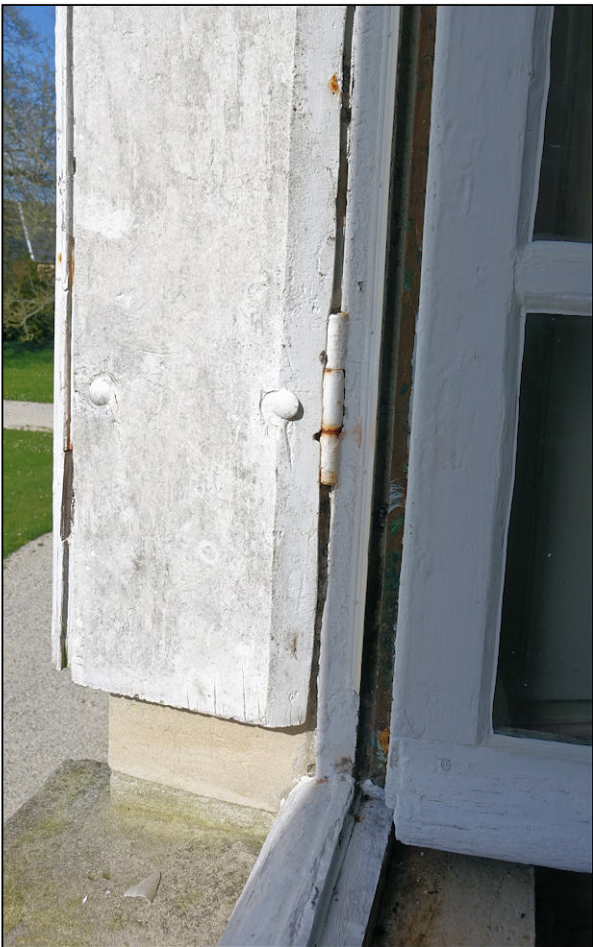
Fig. 9.5. Contrevent brisé / dormant (A.2.9)
