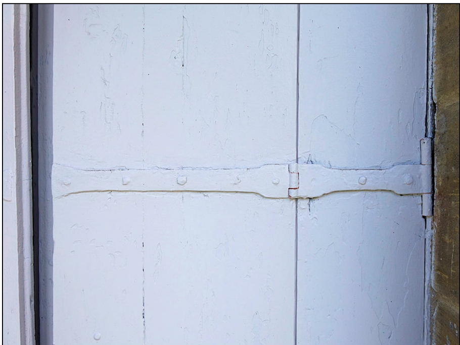
Fig. 9.7. Contrevent brisé / ferrure (A.2.9)
