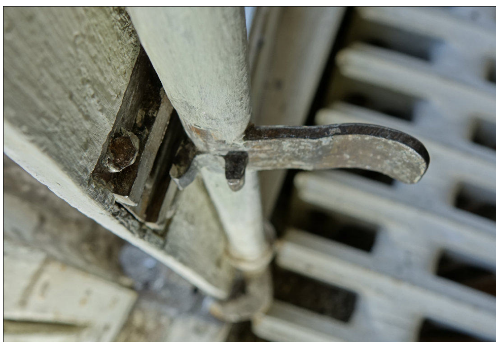
Fig. E.12. Panneton et les deux dents sur la tringle commandant le verrou (verrou déposé)
