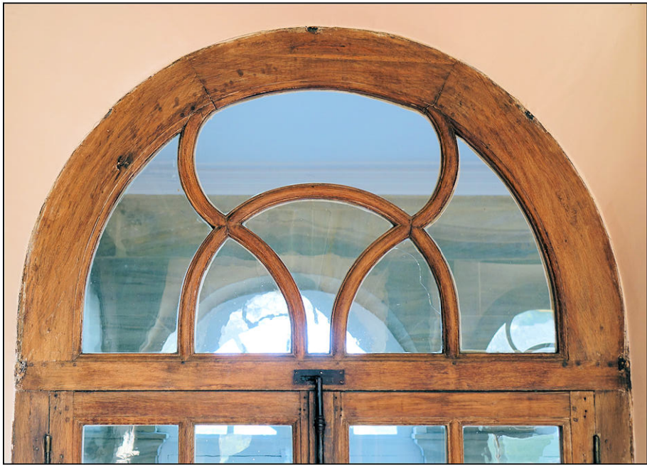
Fig. 3.3. Imposte (élévation intérieure)
