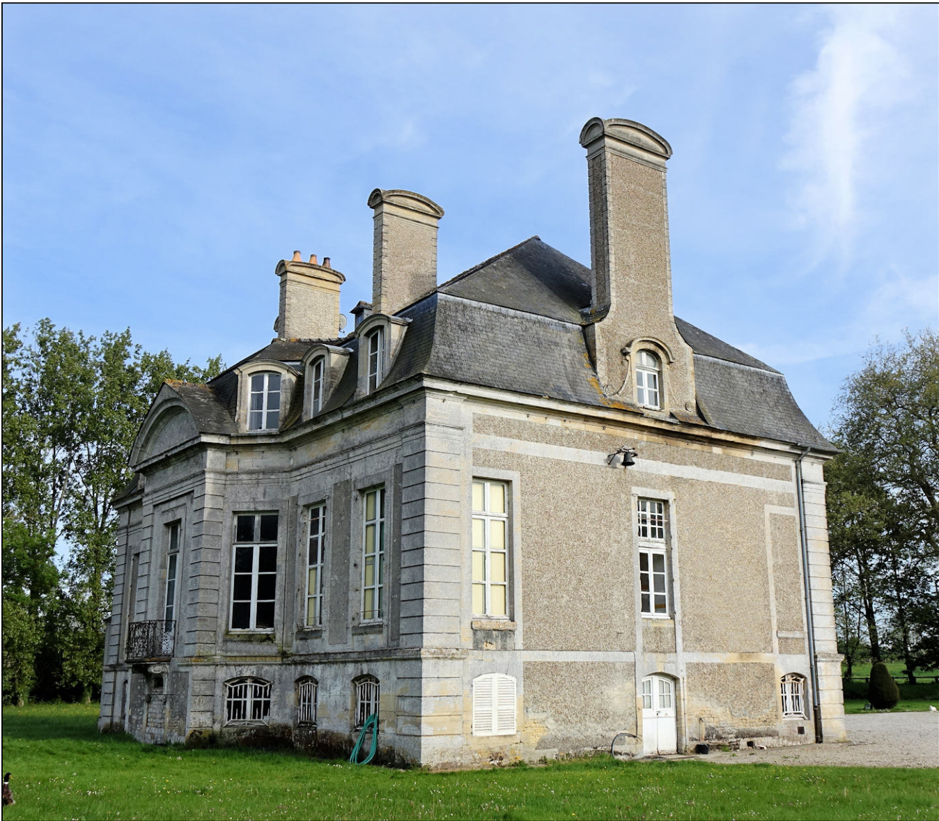
Fig. 1.2. Façades nord et ouest
