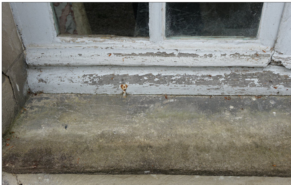
Fig. E.8. Pièce d'appui et appui en pierre d'une fenêtre du rez-de-chaussée.
