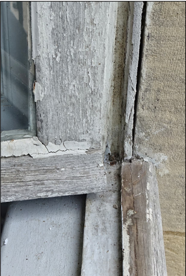
Fig. 2.4. Pièce d'appui et battant de rive
