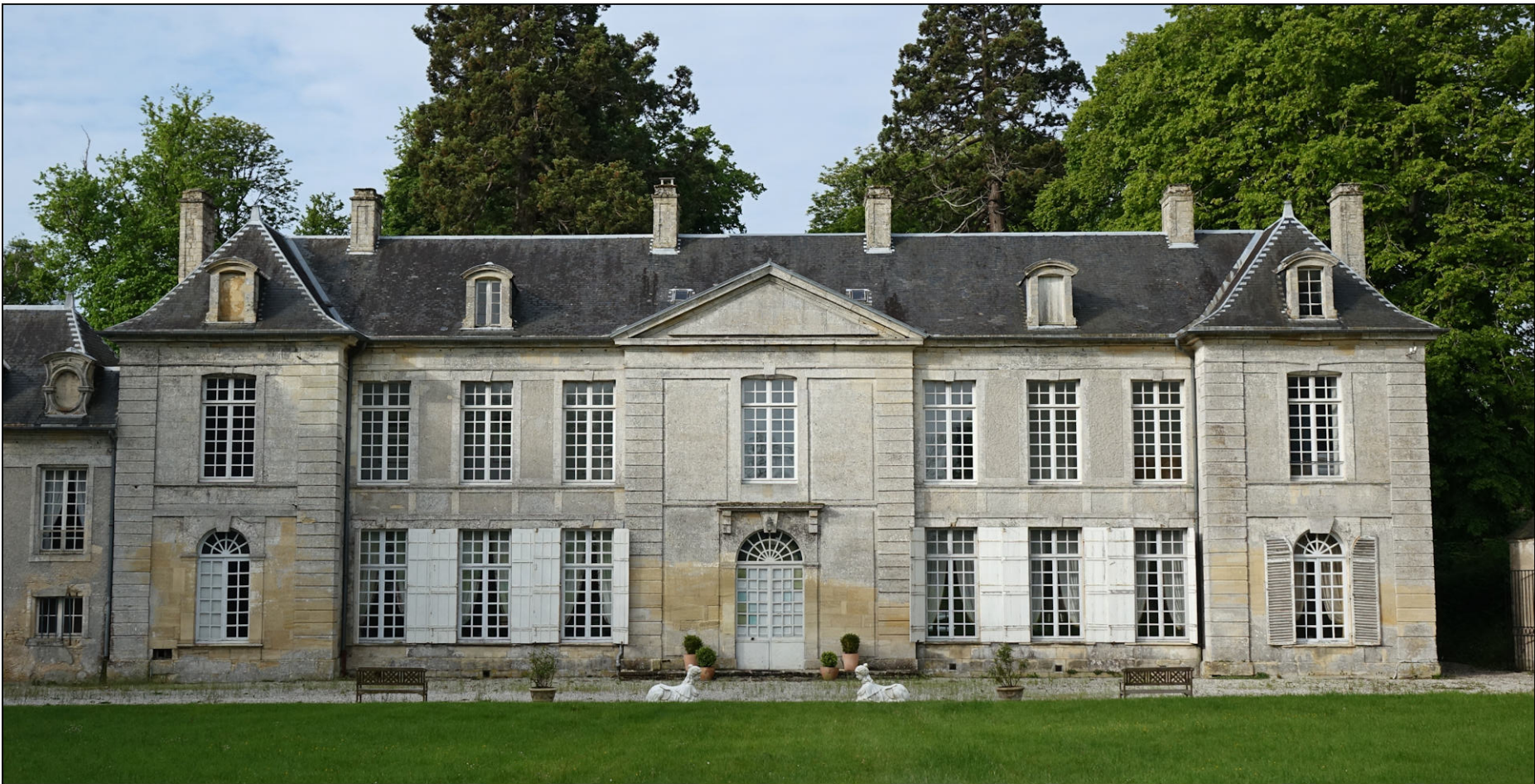
Fig. 1.2. Façade postérieure (nord-est)
