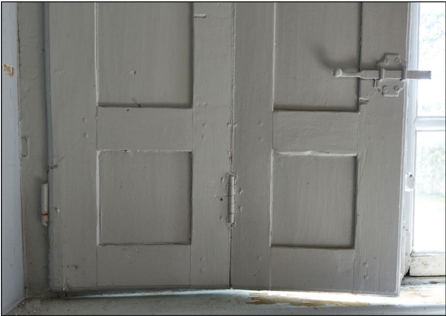
Fig. 3.2. Volet brisé (élévation intérieure)
