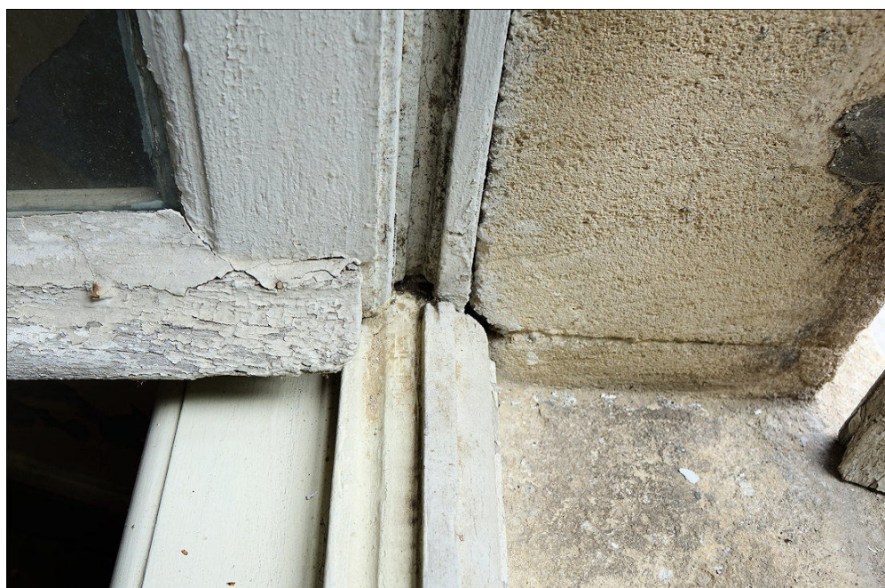
Fig. E.7. Pièce d'appui et appui en pierre d'une fenêtre de l'étage
