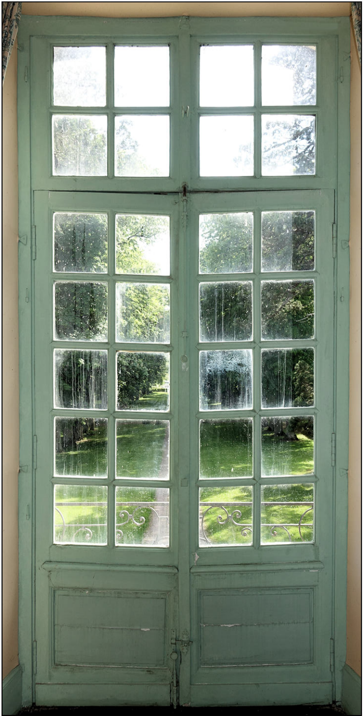
Fig. 5.2. Porte-croisée (élévation intérieure)
