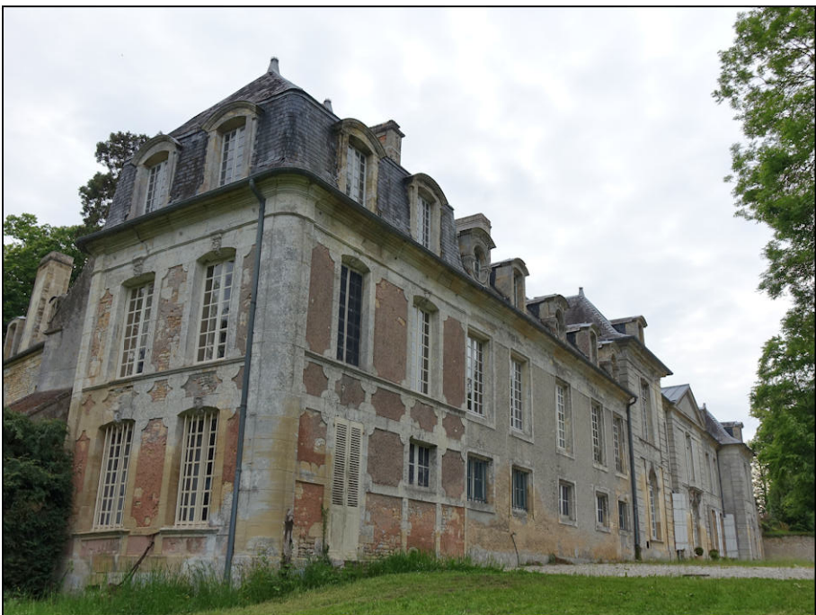
Fig. 1.3. Façade postérieure (depuis l'est)
