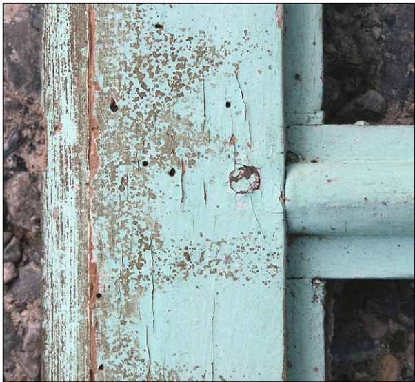
Fig. 1.8. Assemblage montant / petit-bois
