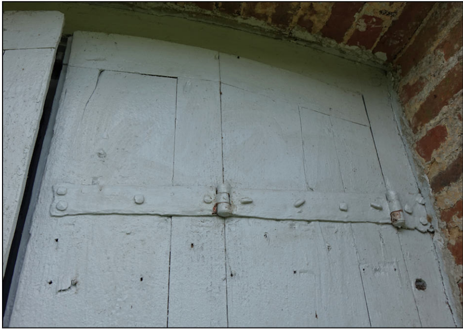
Fig. 4.6. Ferrure d'un contrevent
