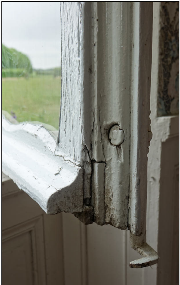
Fig. 7.5. Jet d'eau et battant du milieu
