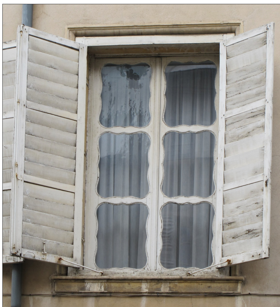
Fig. E.3. Nancy, immeuble, 30 rue des Tiercelins.
