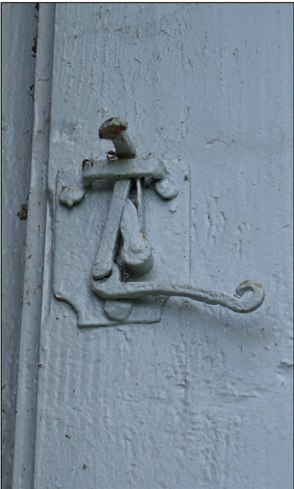
Fig. 5.5. Loquet à ressort (contrevent)
