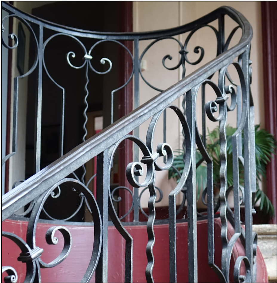
Fig. 2.1. Garde-corps de l'escalier
