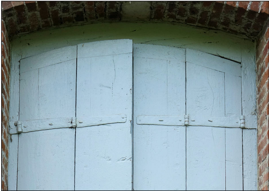
Fig. 5.2. Ferrures des contrevents
