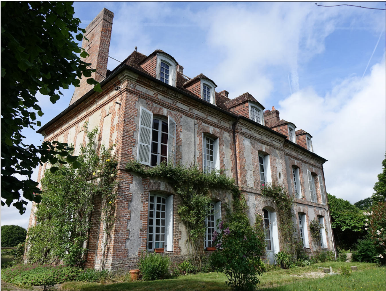
Fig. 1.2. Façade postérieure (nord-est)
