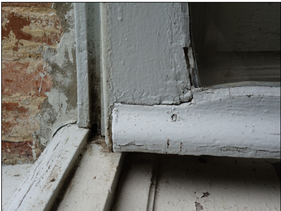
Fig. 7.6. Pièce d'appui et jet d'eau
