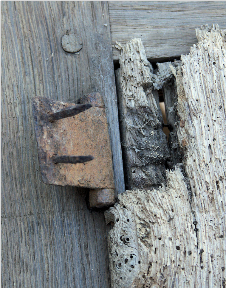
Fig. E.2. Fiche à broche rivée et mortaise
