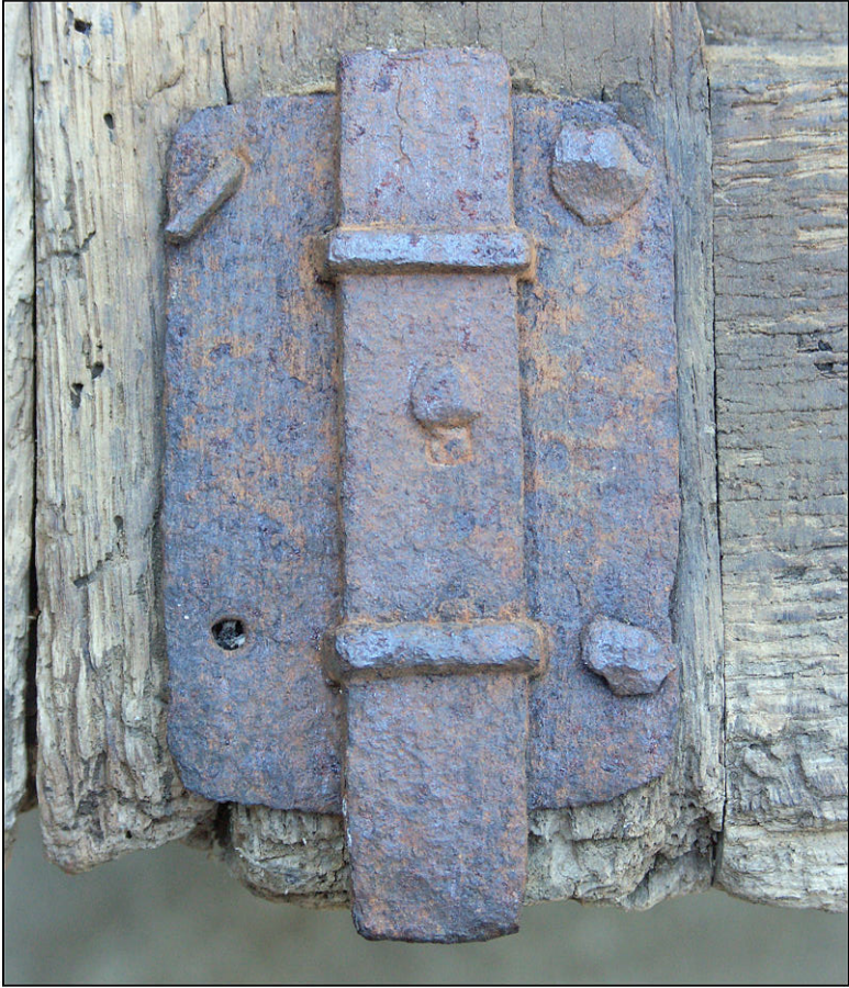
Fig. 2.1. Verrou inférieur (volet inférieur droit)
