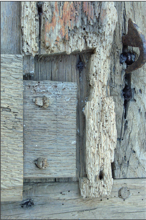
Fig. 1.4. Assemblage à tenon et mortaise
