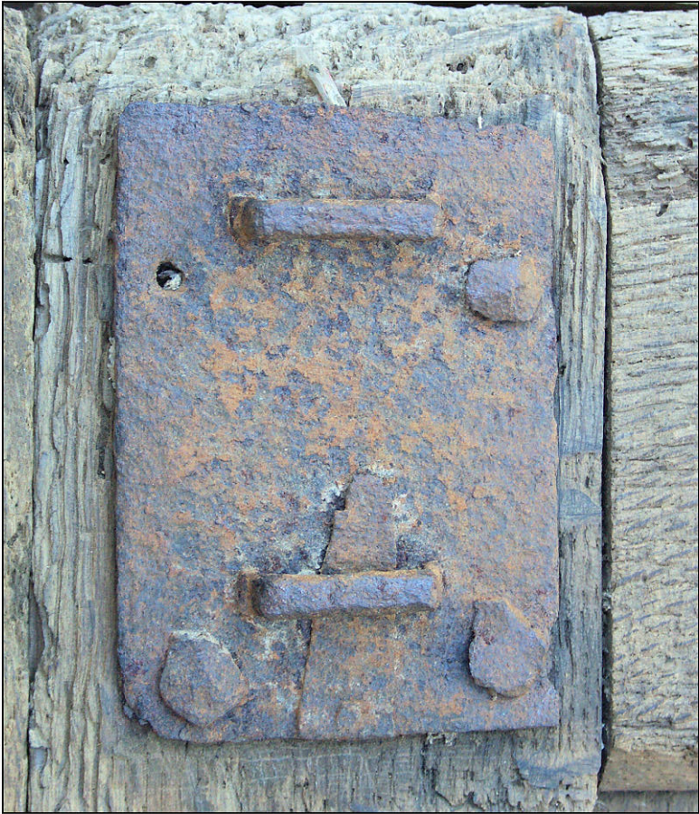
Fig. 2.3. Verrou supérieur (volet inférieur droit)
