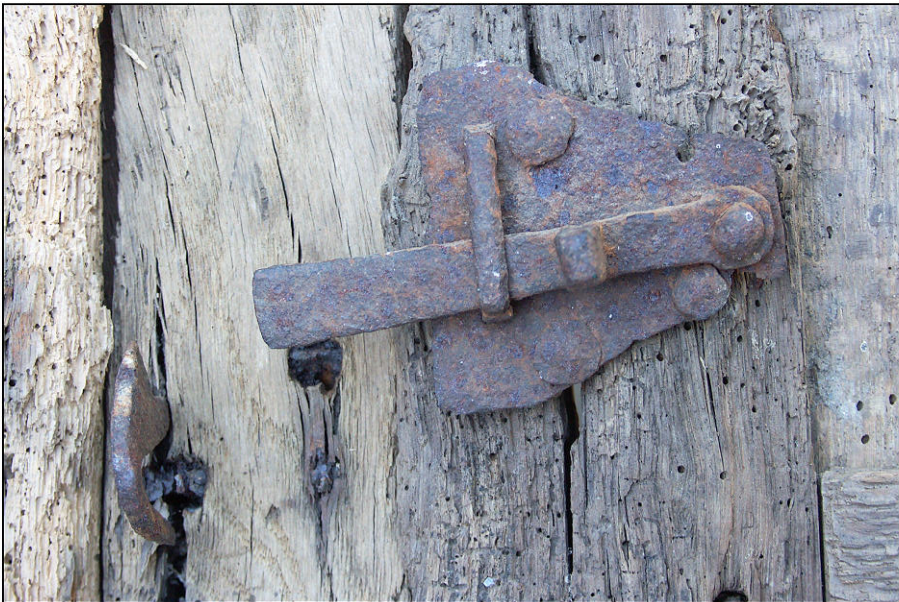
Fig. 2.5. Loquet (volet supérieur droit)
