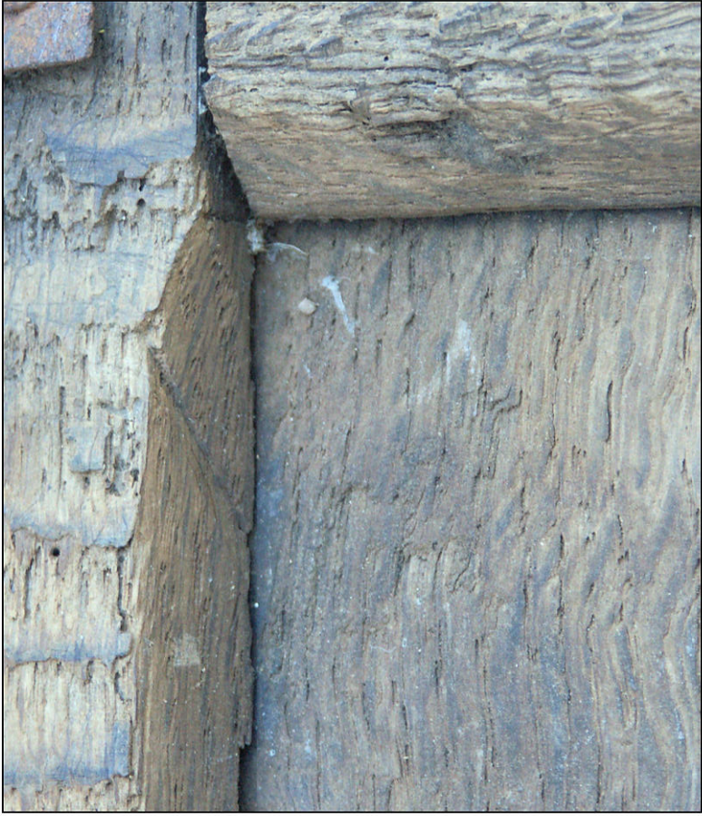
Fig. 2.2. assemblage carré (chanfrein arrêté)
