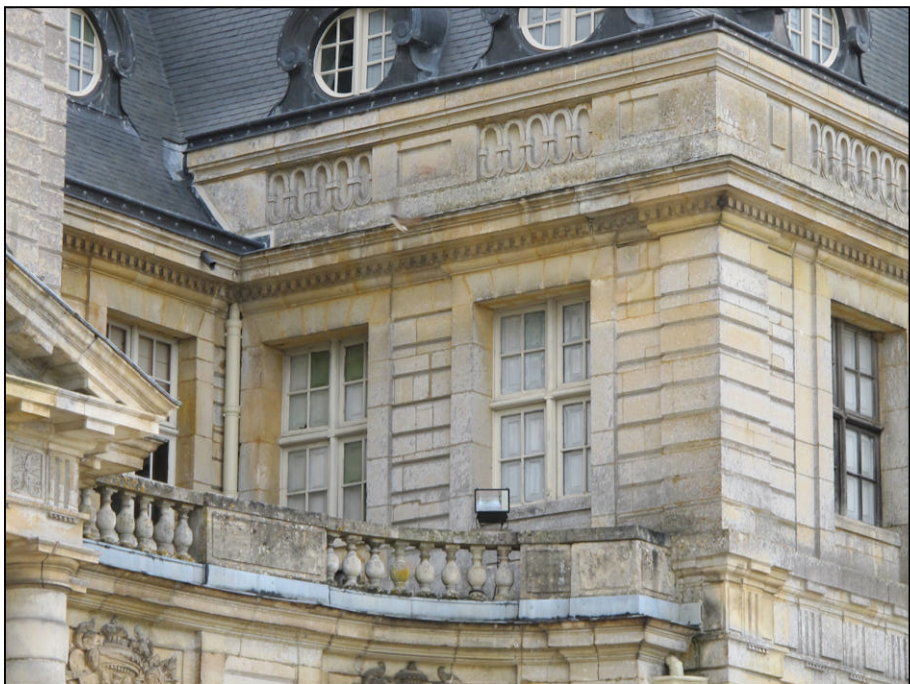
Fig. 13.7. Avant-corps nord-ouest / façade est (croisée E 32)
