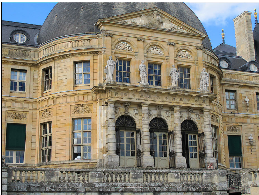
Fig. 1.5. Façade sud / rotonde
