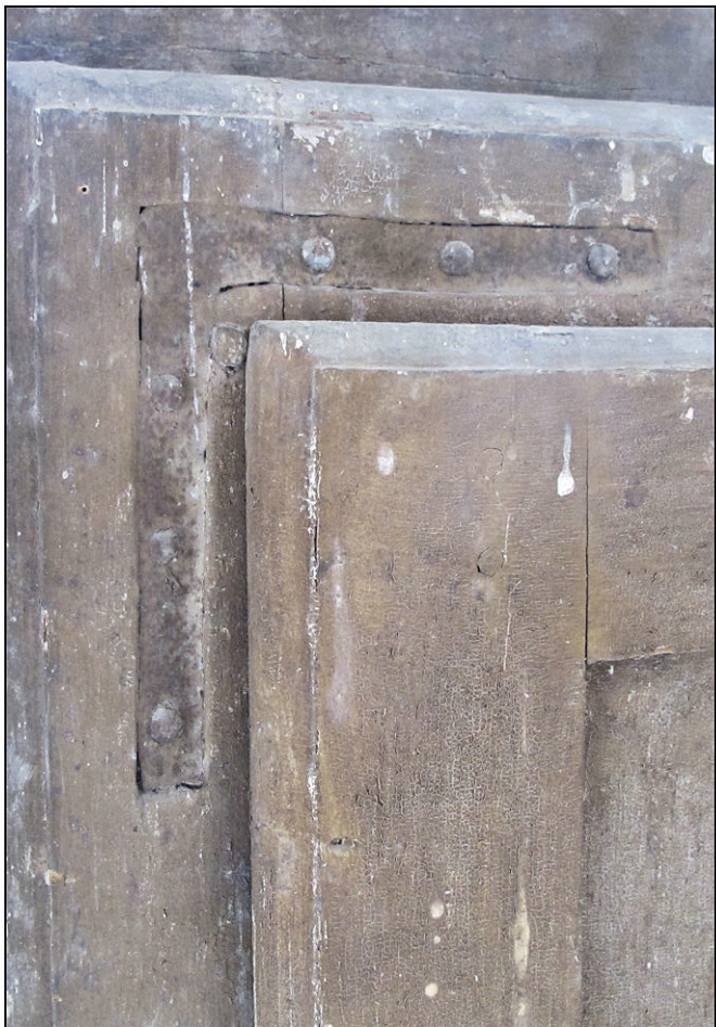
Fig. 5.4. SS 34 / équerre (vantail vitré)
