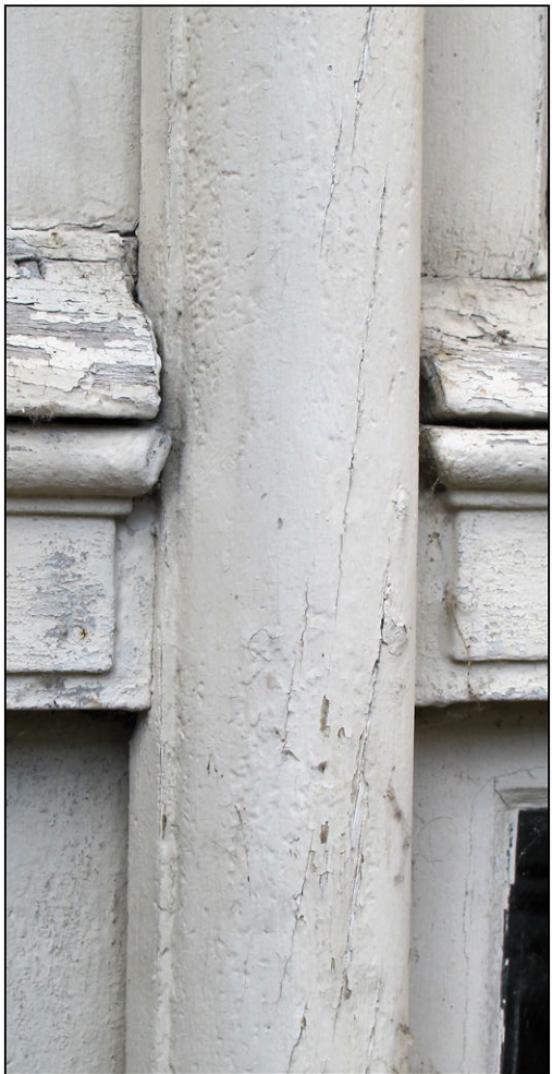
Fig. 4.4. Assemblage meneau / croisillon
