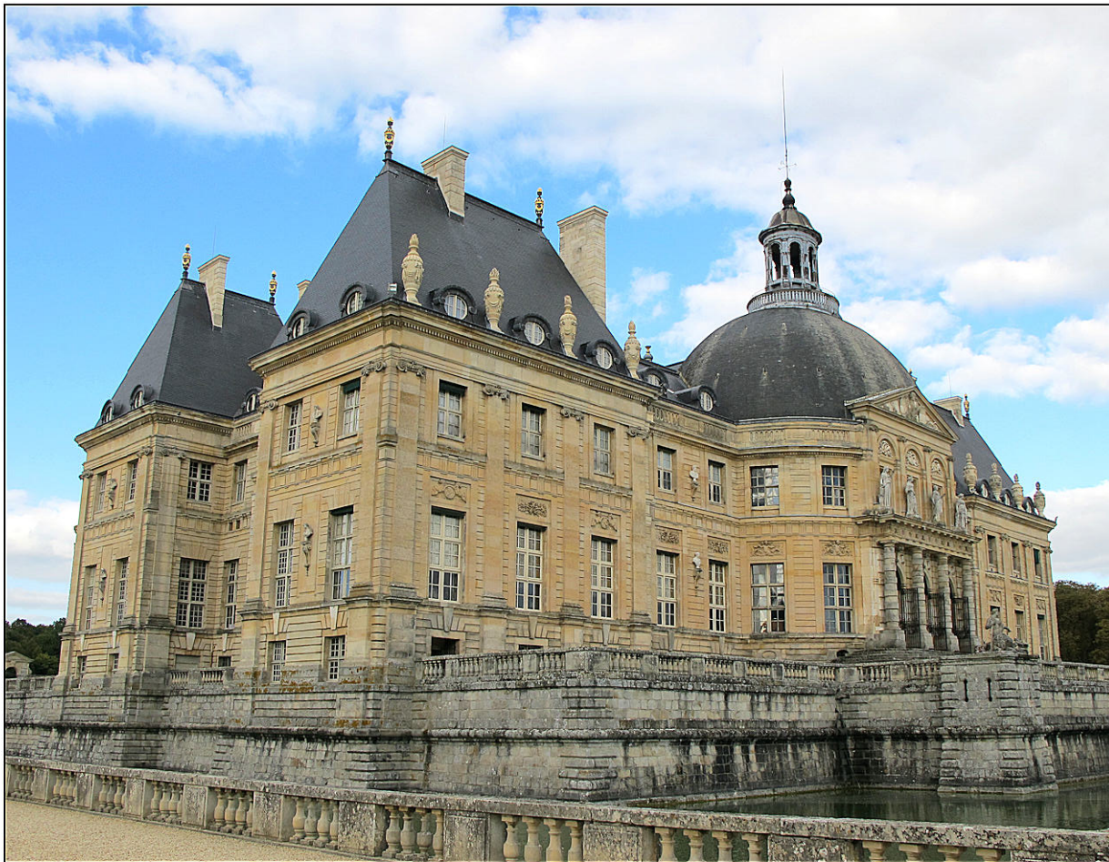
Fig. 1.3. Façades ouest et sud
