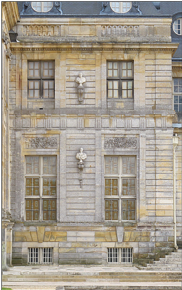
Fig. 1.4. Avant-corps nord-est / façade nord
