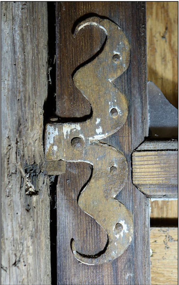
Fig. 11.7. Paumelle à moustaches (réemploi)
