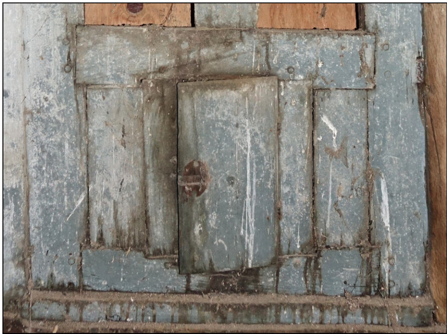
Fig. 5.3. Soubassement à panneaux et guichet (2013)
