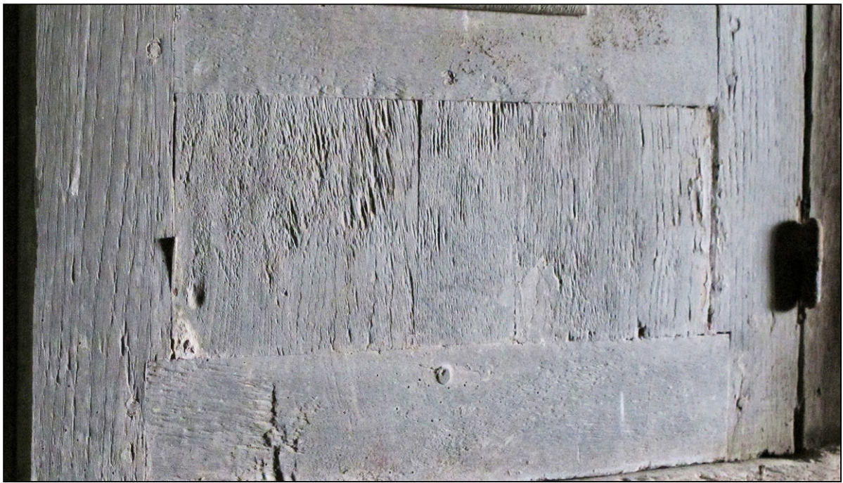
Fig. 7.2. Soubassement à panneaux (parties supérieure et inférieure)
