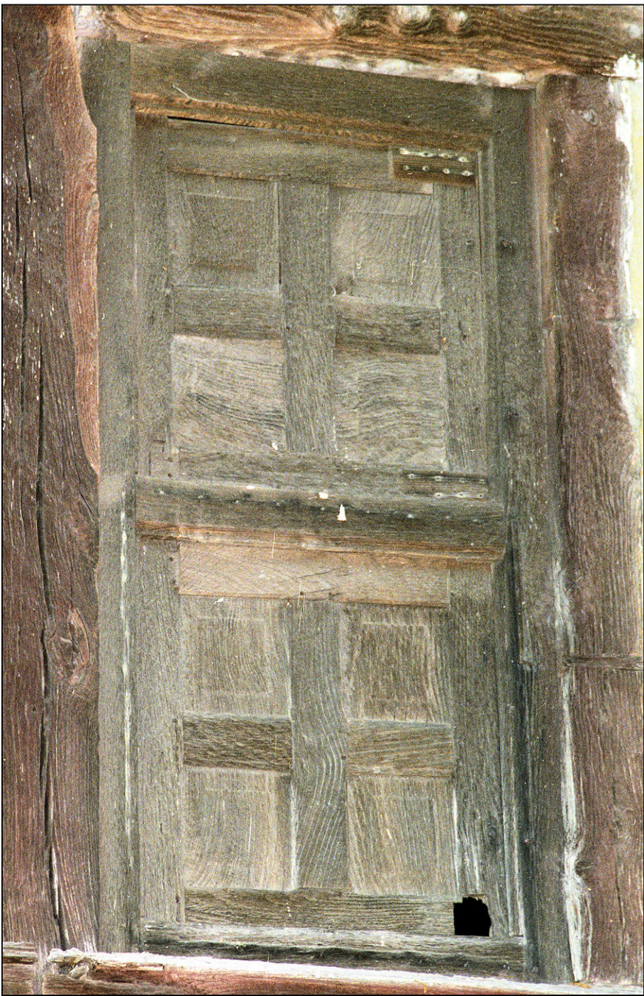
Fig. 9.2. Vantail vitré et volets gauches
