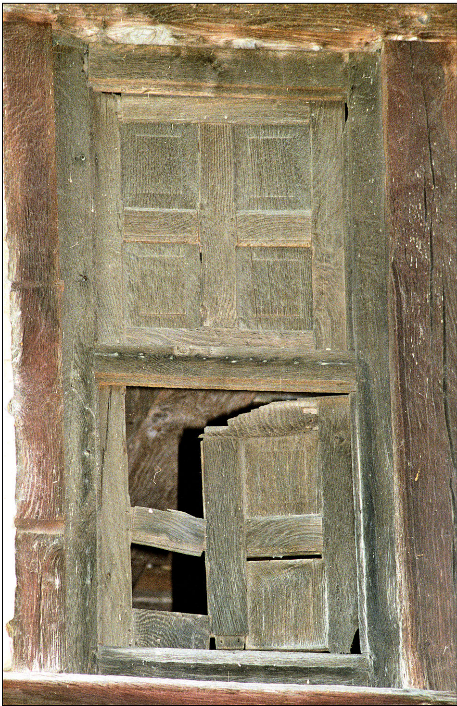
Fig. 9.1. Vantail vitré et volets droits
