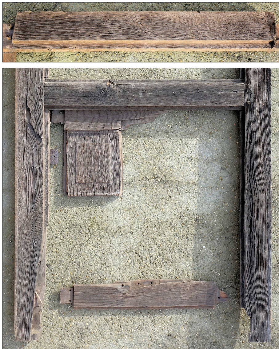
Fig. E.9. Le châssis C (face extérieure) Traverse haute du vantail et compartiment inférieur
