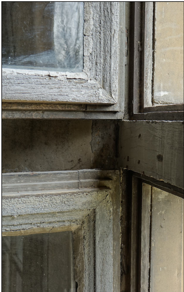
Fig. 6.5. Assemblages (vantaux vitrés gauches)
