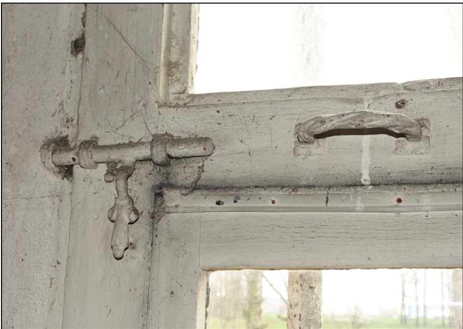
Fig. 7.3. Verrou et poignée (châssis 1)
