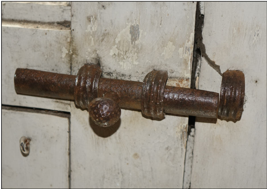
Fig. 10.3. Verrou (croisée 4, vantail vitré inférieur)
