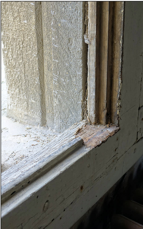
Fig. 6.4. Bâti dormant (modification de l'appui)
