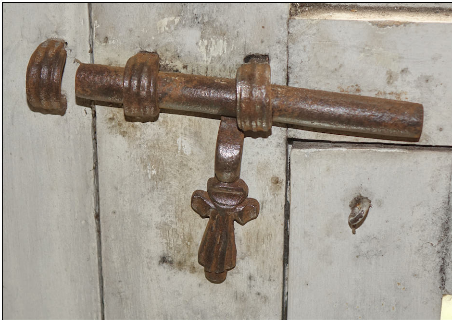
Fig. 10.5. Verrou (croisée 4, vantail vitré inférieur)
