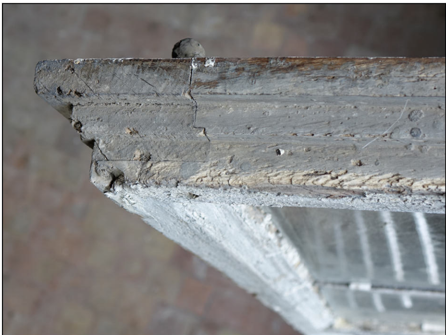
Fig. 6.6. Assemblage avec moulure flottée (vantail vitré inf.)
