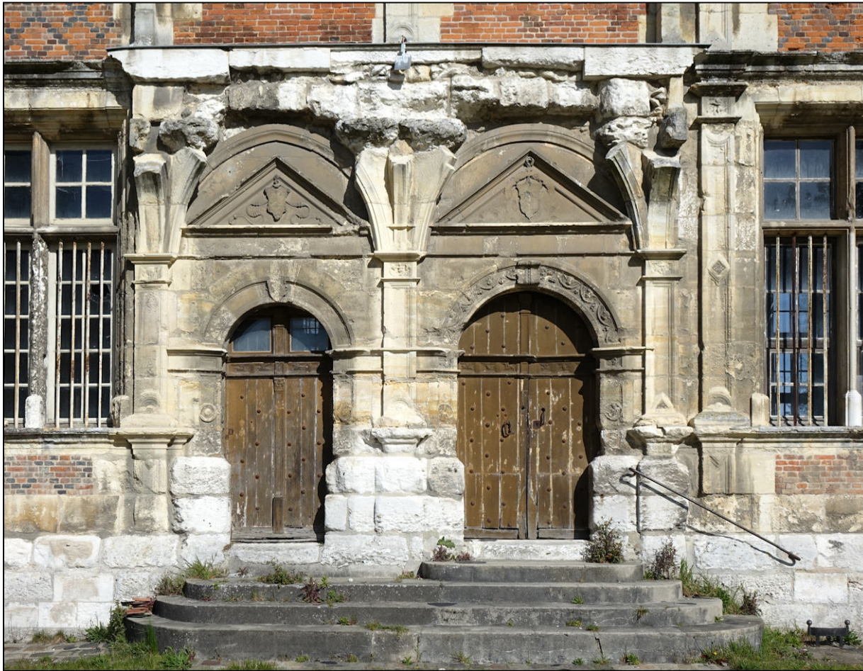
Fig. 12.1. Porte ouest et est (façade sud)
