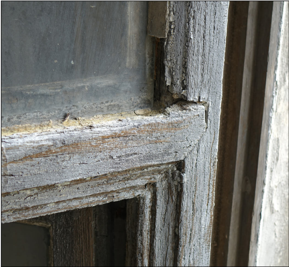
Fig. 5.3. Assemblage (traverse intermédiaire)
