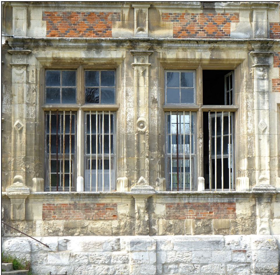
Fig. 2.3. Croisées 1 et 2 (façade sud)
