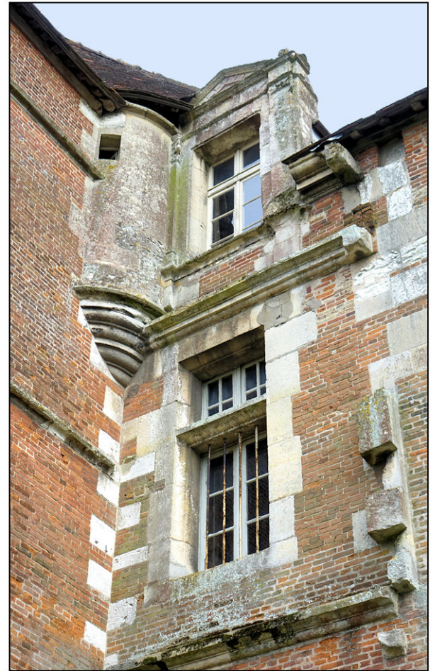
Fig. 2.2. Escalier (façade nord)
