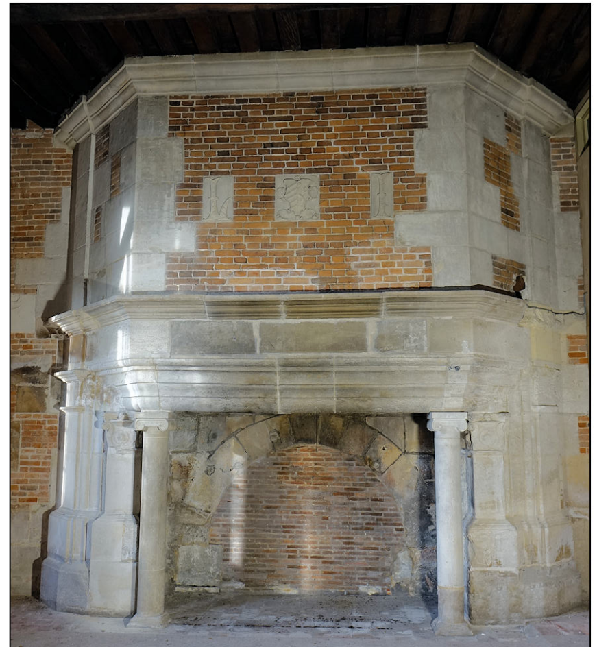
Fig. 2.4. Cheminée de la cuisine
