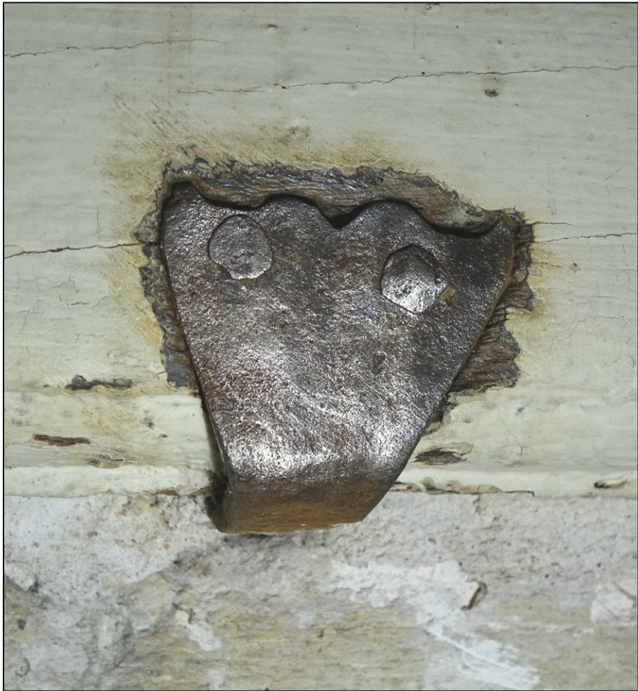
Fig. 10.1. Patte (croisée 2, pièce d'appui)
