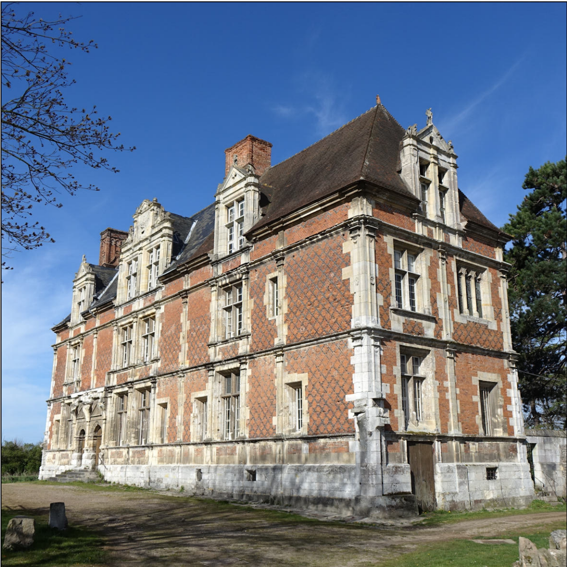
Fig. 1.3. Façades sud et est
