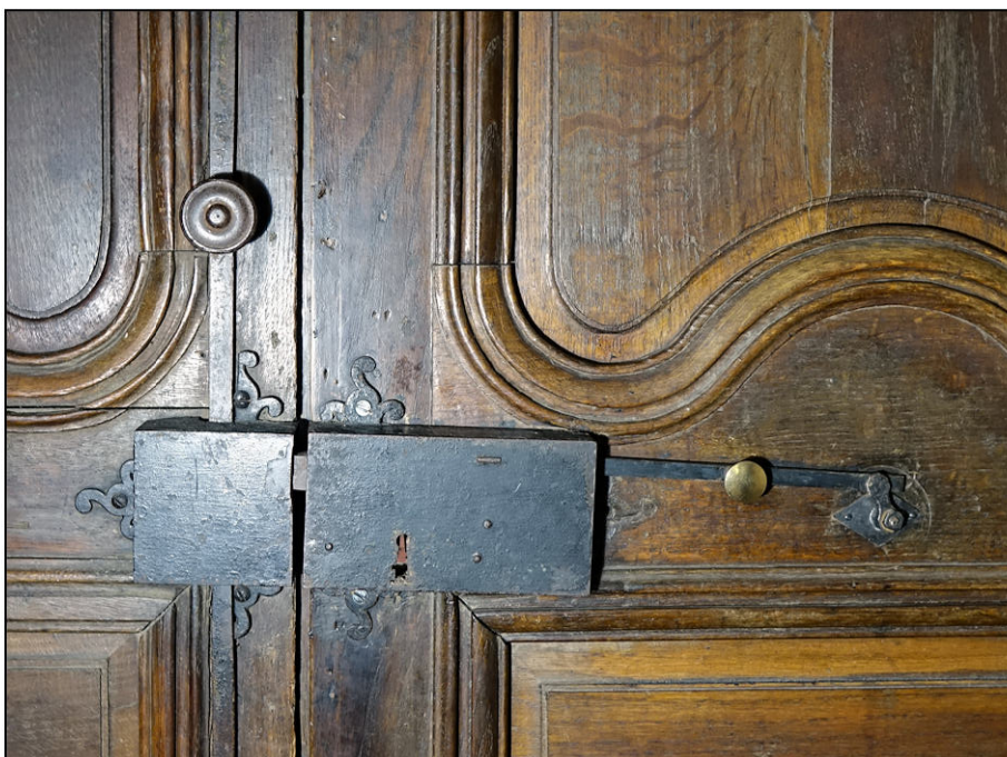
Fig. 9.7. Bascule et serrure (chambre ouest)
