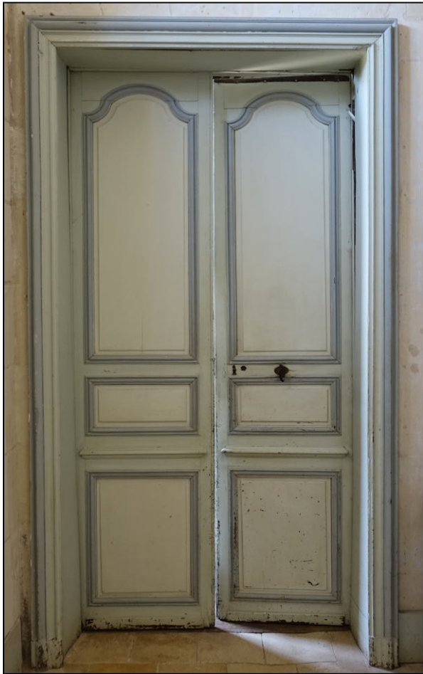
Fig. 9.1. Vestibule / salle à manger
