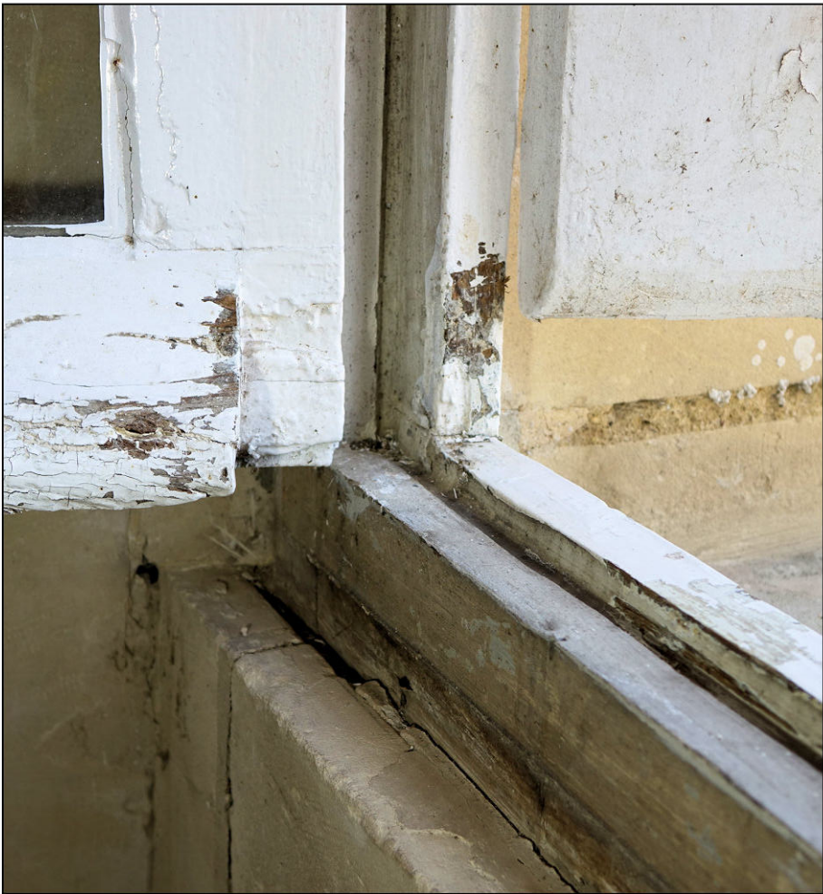
Fig. 6.3. Pièce d'appui
