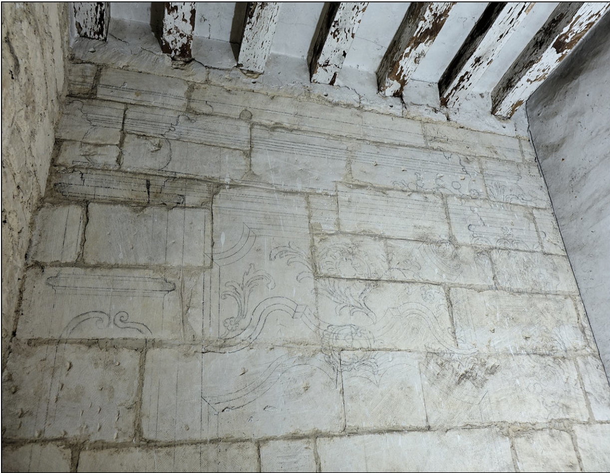
Fig. 4.1. Tracé d'un lambris (chambre ouest)
