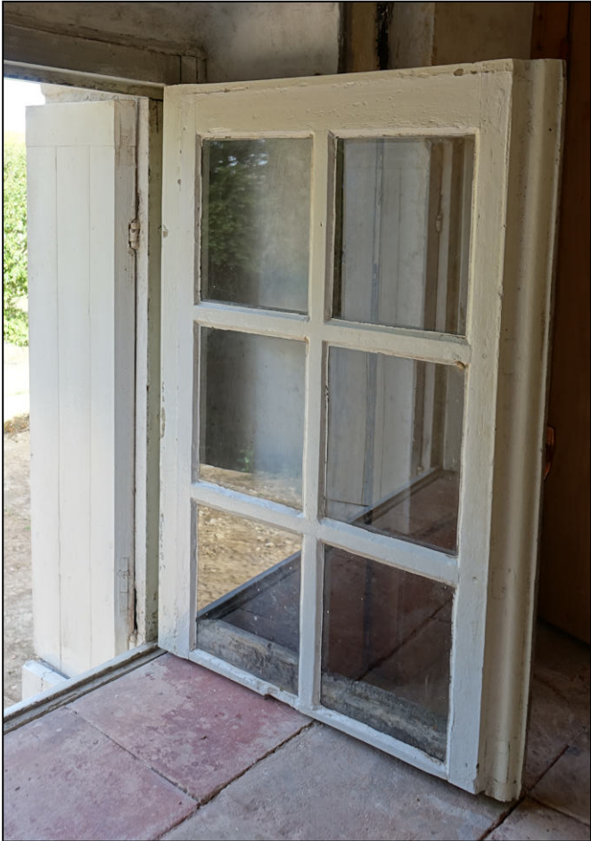
Fig. 7.6. Vantail vitré supérieur droit
