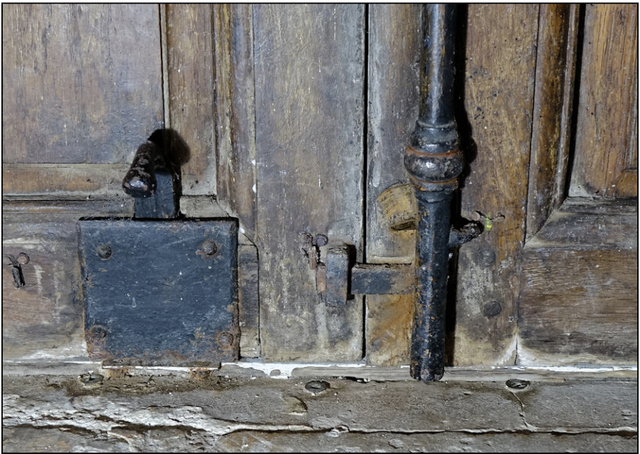
Fig. 8.3. Verrou et loquet fermé d'espagnolette
