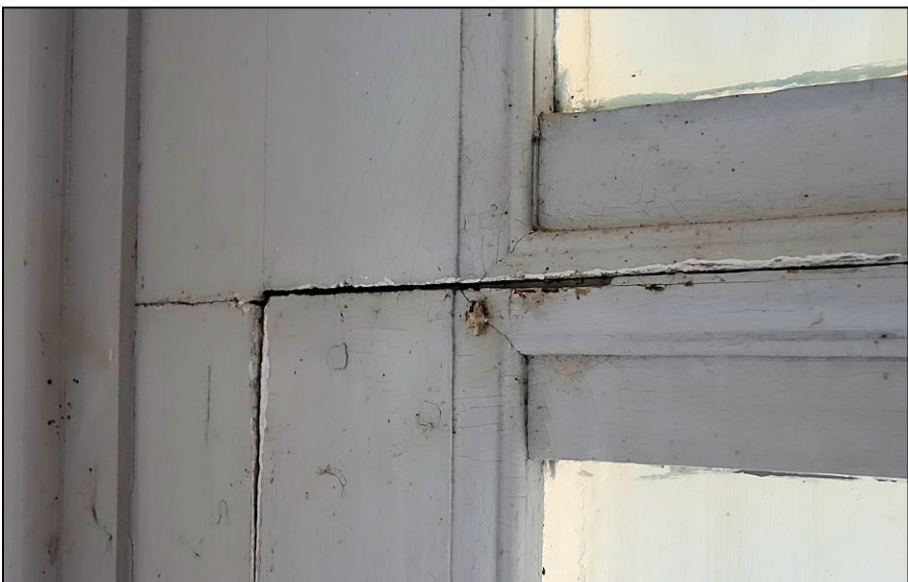
Fig. 3.4. Traverses d'imposte et du vantail
