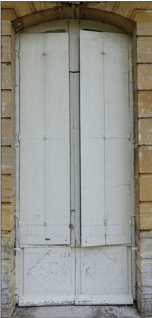
Fig. 2.3. Vue extérieure (contrevents fermés)
