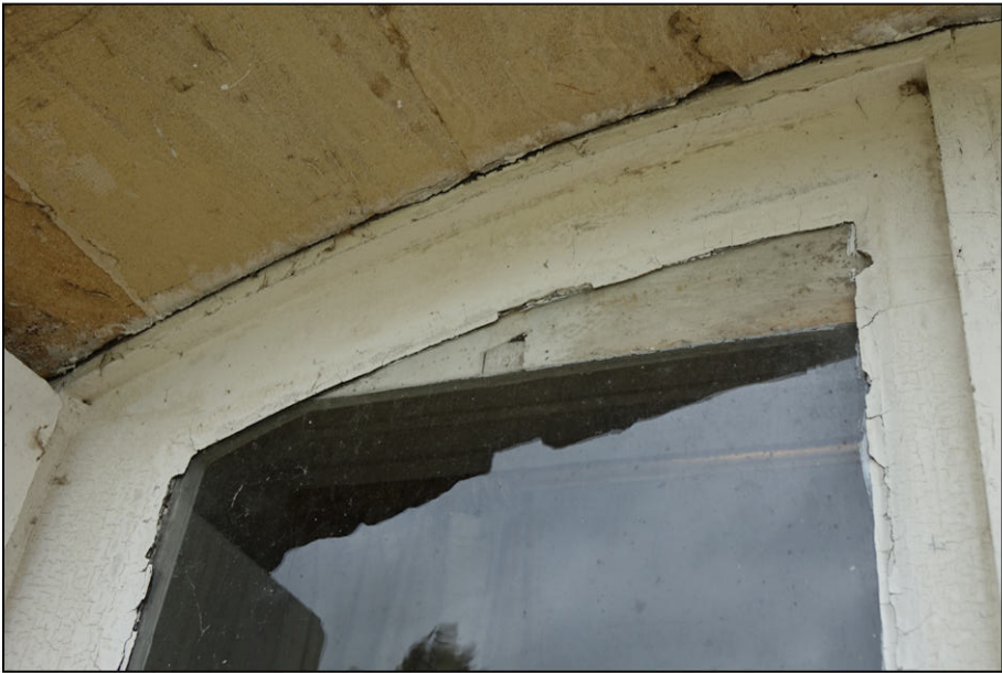
Fig. 3.1. Imposte (traverse haute)
