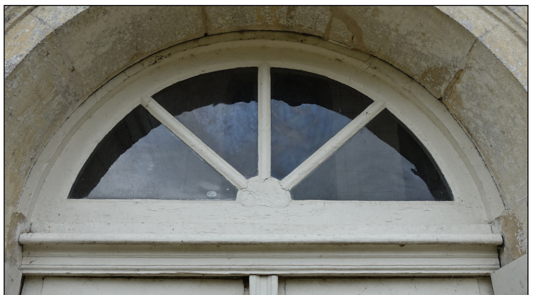
Fig. 6.4. Imposte en demi-lune (façade antérieure)
