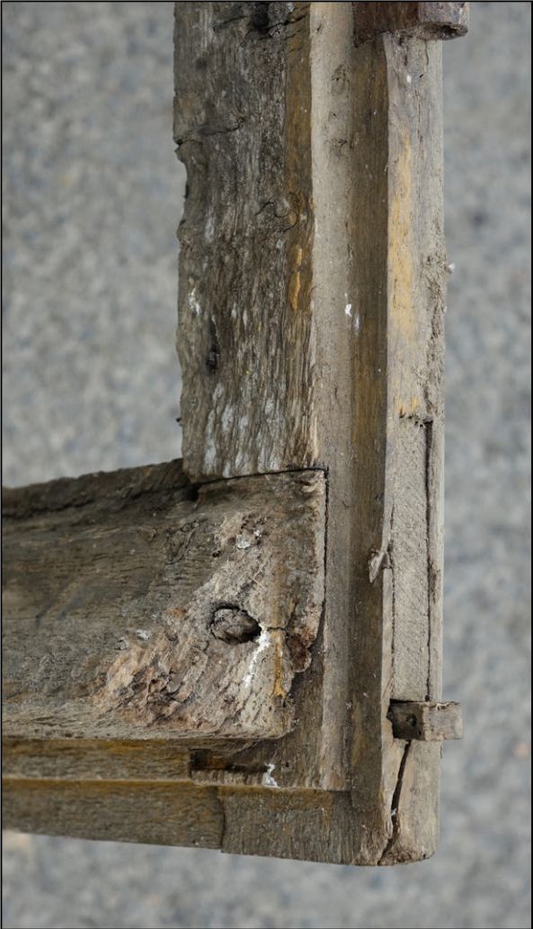
Fig. 4.5. Assemblage du jet d'eau
