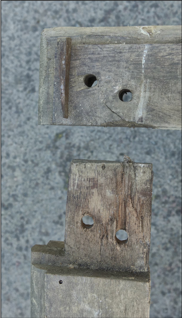
Fig. 4.6. Assemblage d'un battant de rive*
