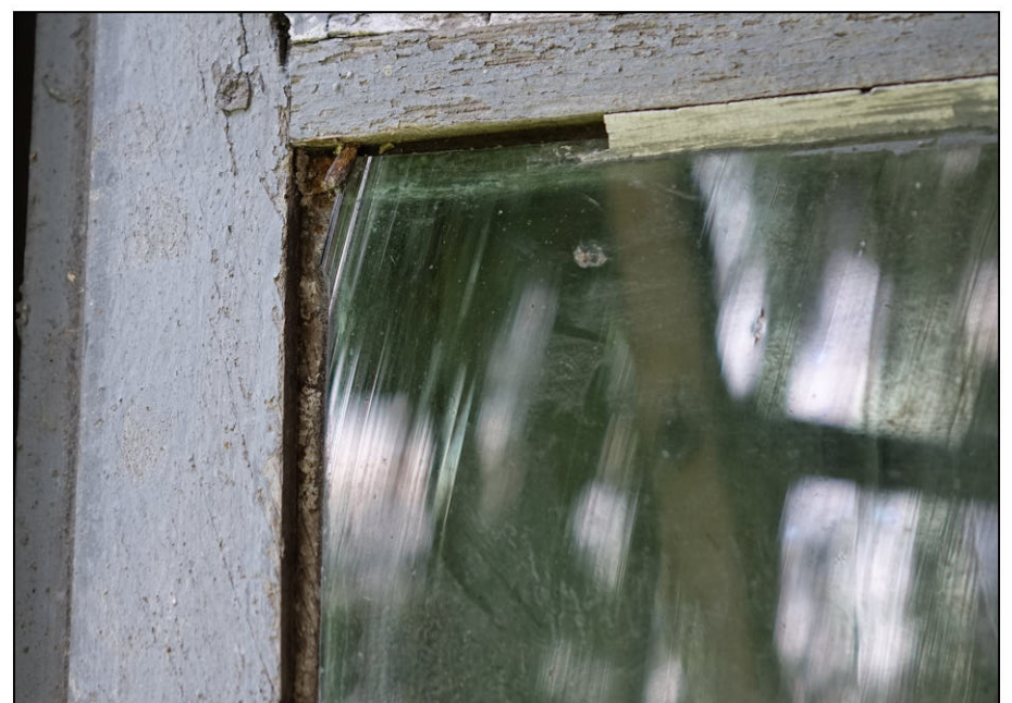
Fig. 3.8. Carreau avec bourrelet dans l'angle
