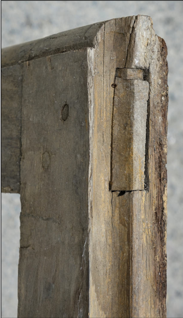
Fig. 4.4. Assemblage du battant du milieu
