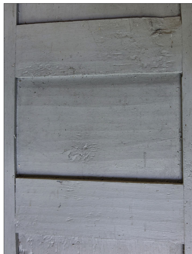
Fig. E.2 – Détail de la face intérieure d'un volet et du façonnage de son parement.
