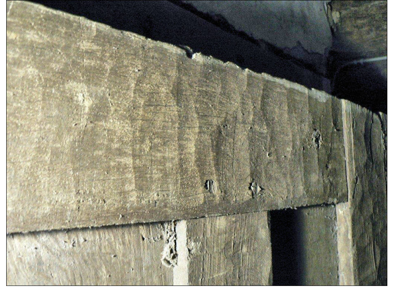
Fig. E.4 (a, b et c) – Vantail de porte du premier niveau, en réemploi. A noter le traitement de son revers en c avec un outil de type hache ou herminette. Photo c, Bernard Leprêtre
