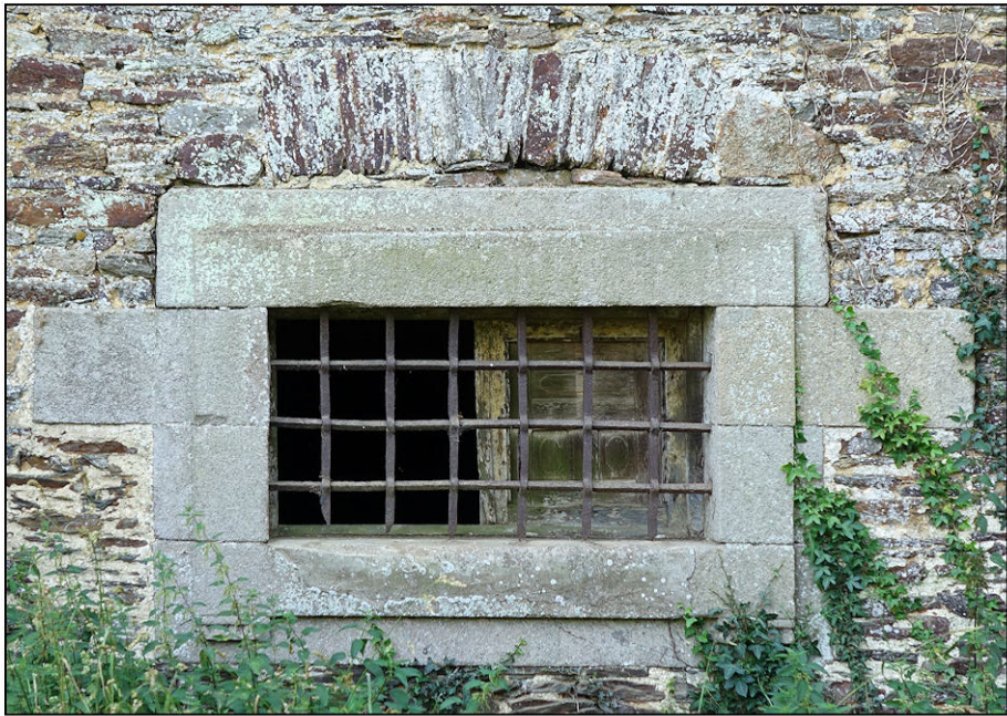
Fig. 1.4. Fenêtre du niveau 1 (façade est / 4e travée)
