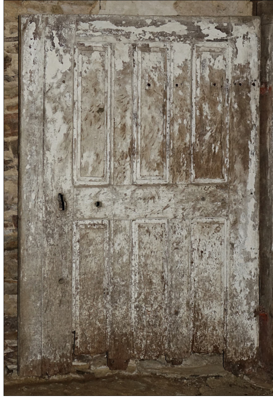
Fig. E.4 (a, b et c) – Vantail de porte du premier niveau, en réemploi. A noter le traitement de son revers en c avec un outil de type hache ou herminette. Photo c, Bernard Leprêtre
