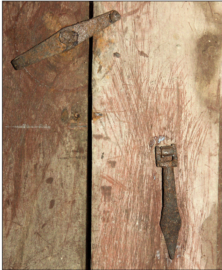
Fig. 4.2. Tourniquet et pendeloque
