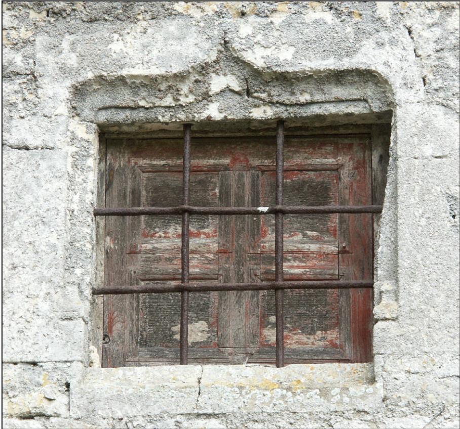
Fig. 5.1. Châssis du rez-de-chaussée
