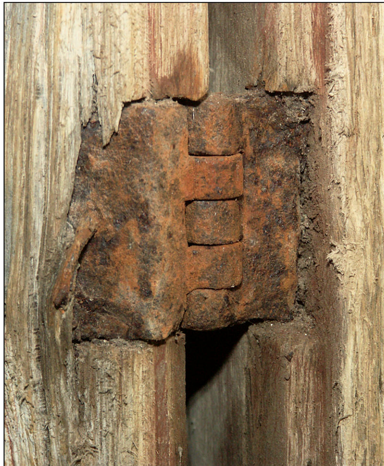
Fig. 4.4. Fiche (volet inférieur)
