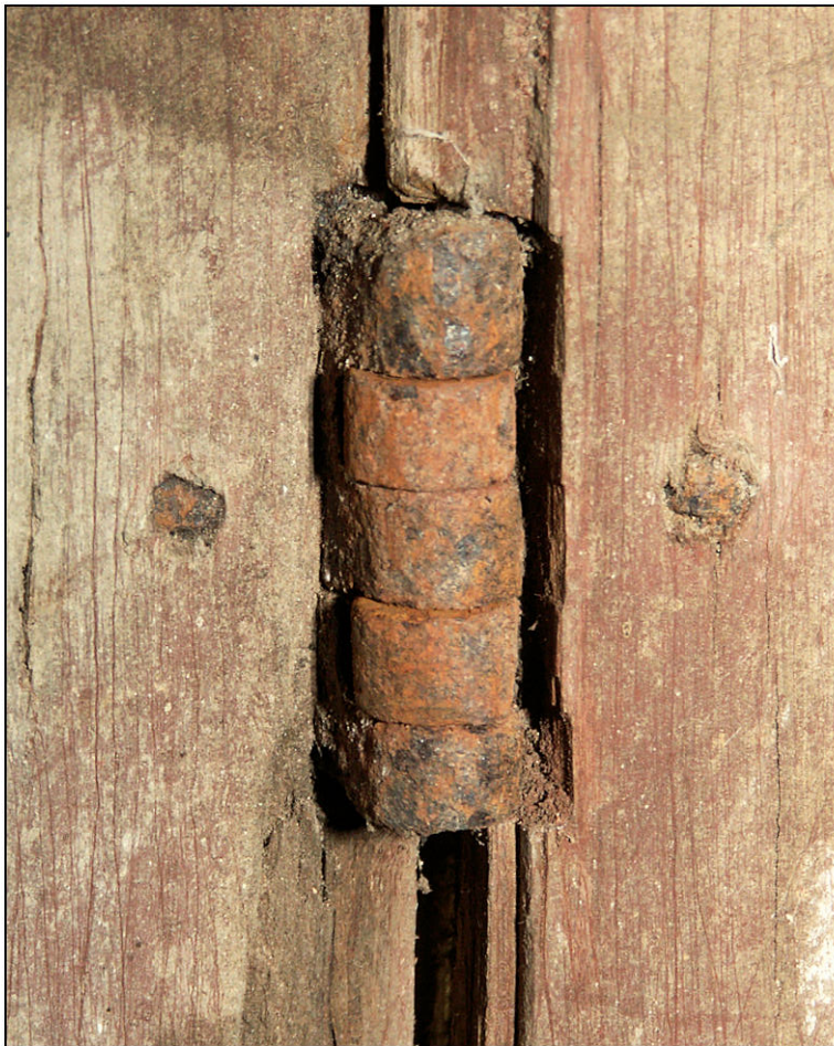
Fig. 4.3. Fiche (volet inférieur)
