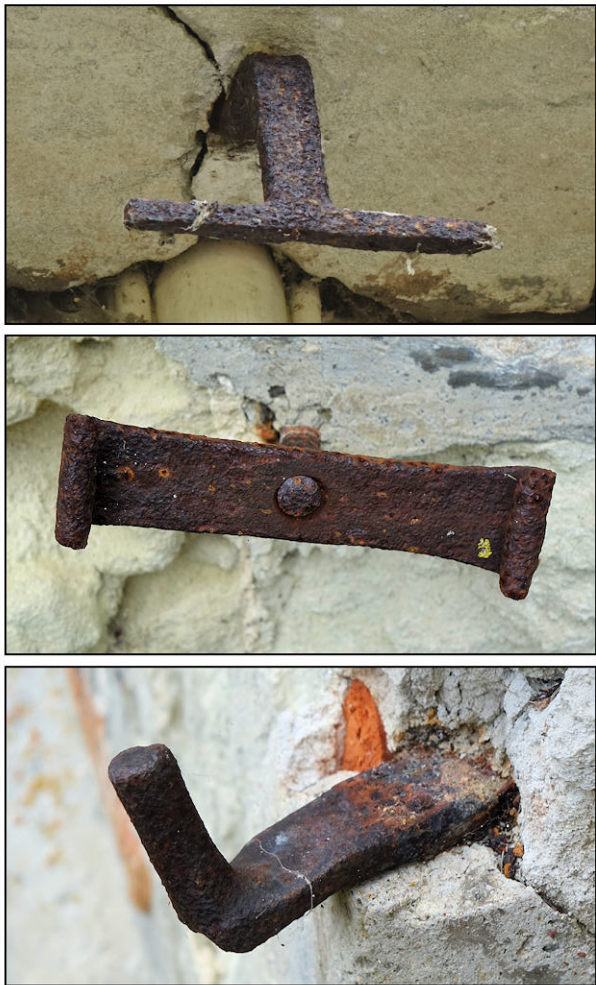
Fig. 4.5. Ferrures des contrevents
