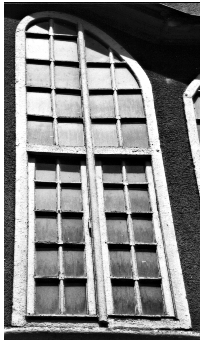
Fig. E.10. Rennes, 16 rue le Bastard, cour intérieure, escalier, croisée à coulisses selon Roubo. (© A. Tiercelin, 1998)
