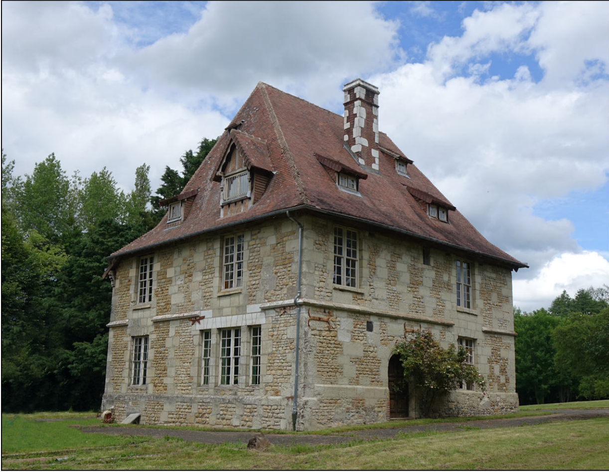
Fig. 1.1. Façades ouest et sud
