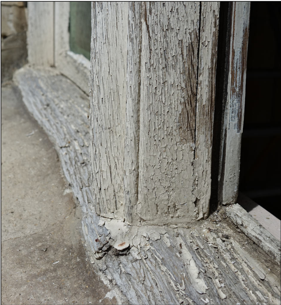
Fig. 3.6. Meneau et pièce d'appui
