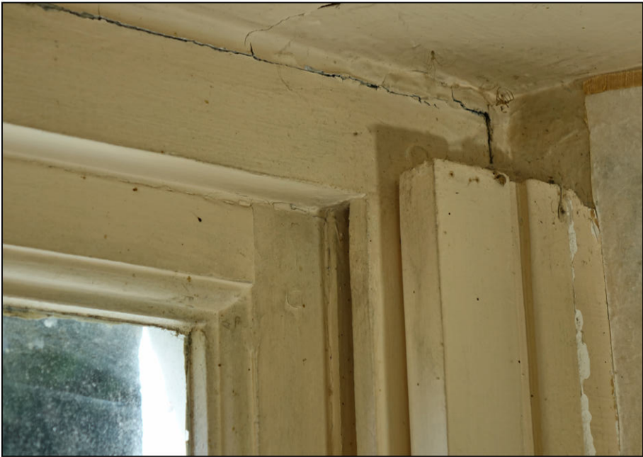
Fig. 3.2. Traverse en chapeau du bâti dormant
