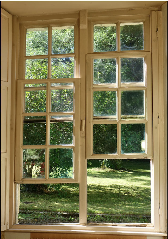
Fig. 2.3. Elévation intérieure (vantaux ouverts)
