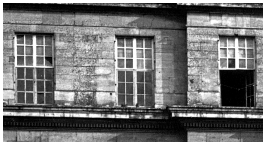
Fig. E.8. et E.9. Croisées de l'attique (état du XVIIIe s.) (détails des figures 10.1 et 10.2)
