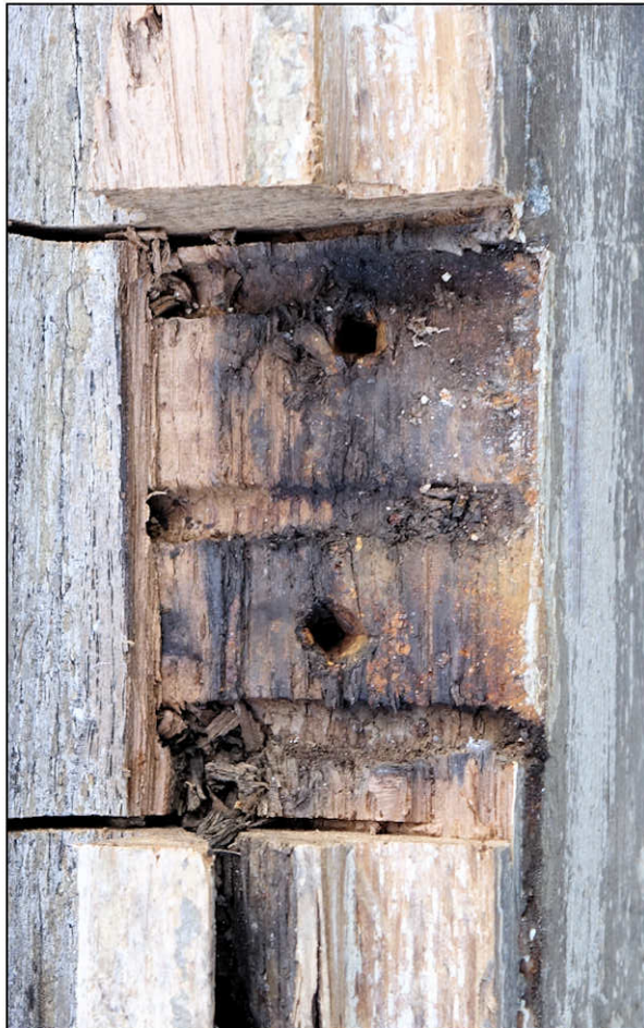
Fig. 12.2. Mortaise de fiche à vases
