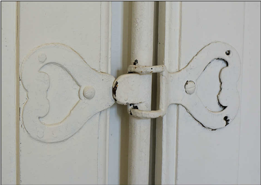
Fig. 5.6. Contre-panneton et agrafe
