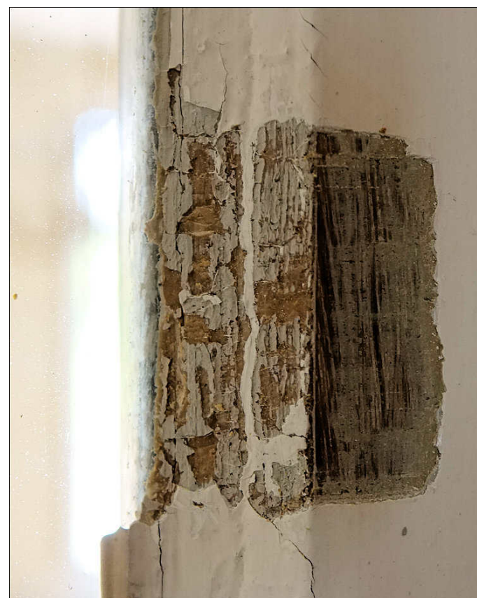
Fig. E.15. Croisée du vestibule (sondage sur les solins de mastic du 3 e carreau, à droite, depuis le bas)
