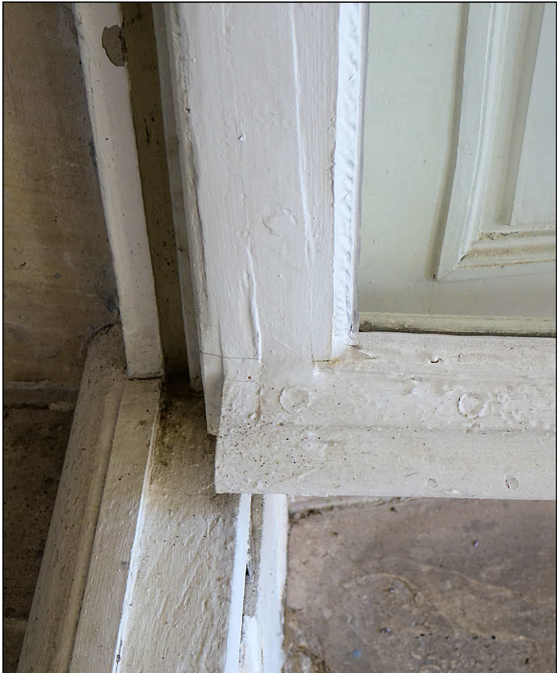
Fig. 5.4. pièce d'appui et jet d'eau
