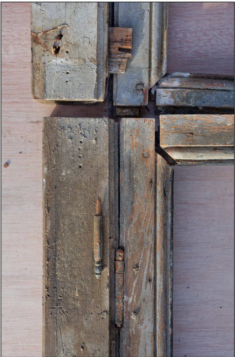
Fig. 10.4. Assemblages au niveau de l'imposte
