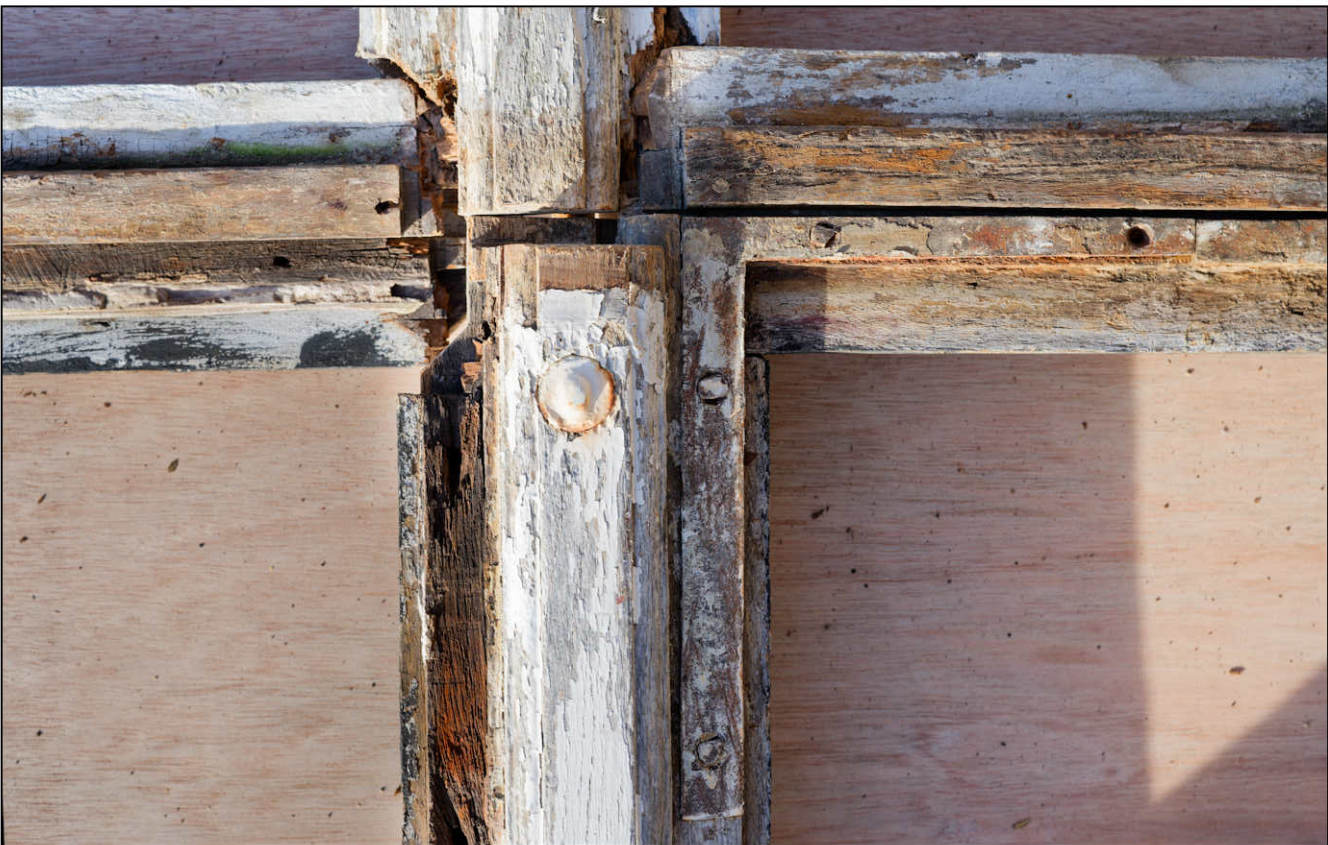
Fig. 11.4. Traverse "d'imposte" (détail des feuillures à verre extérieures)
