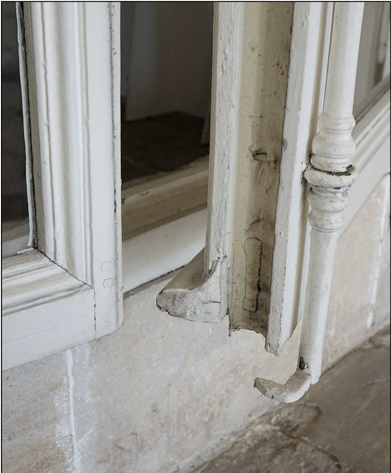
Fig. 5.3. Battants du milieu à mouton et gueule de loup
