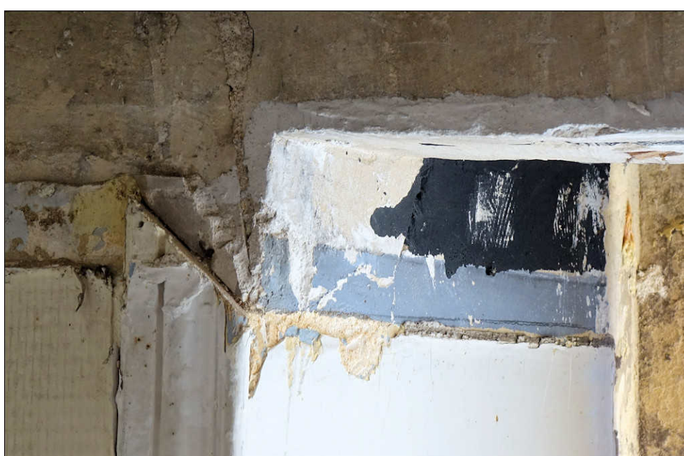
Fig. E.13. Un lambris d'ébrasement posé après entaillage de la pierre (le plafond de l'embrasure en lambris est déposé).
