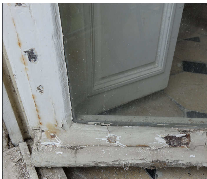
Fig. E.4. Assemblage non traversé de la traverse moulurée (1 er étage)
