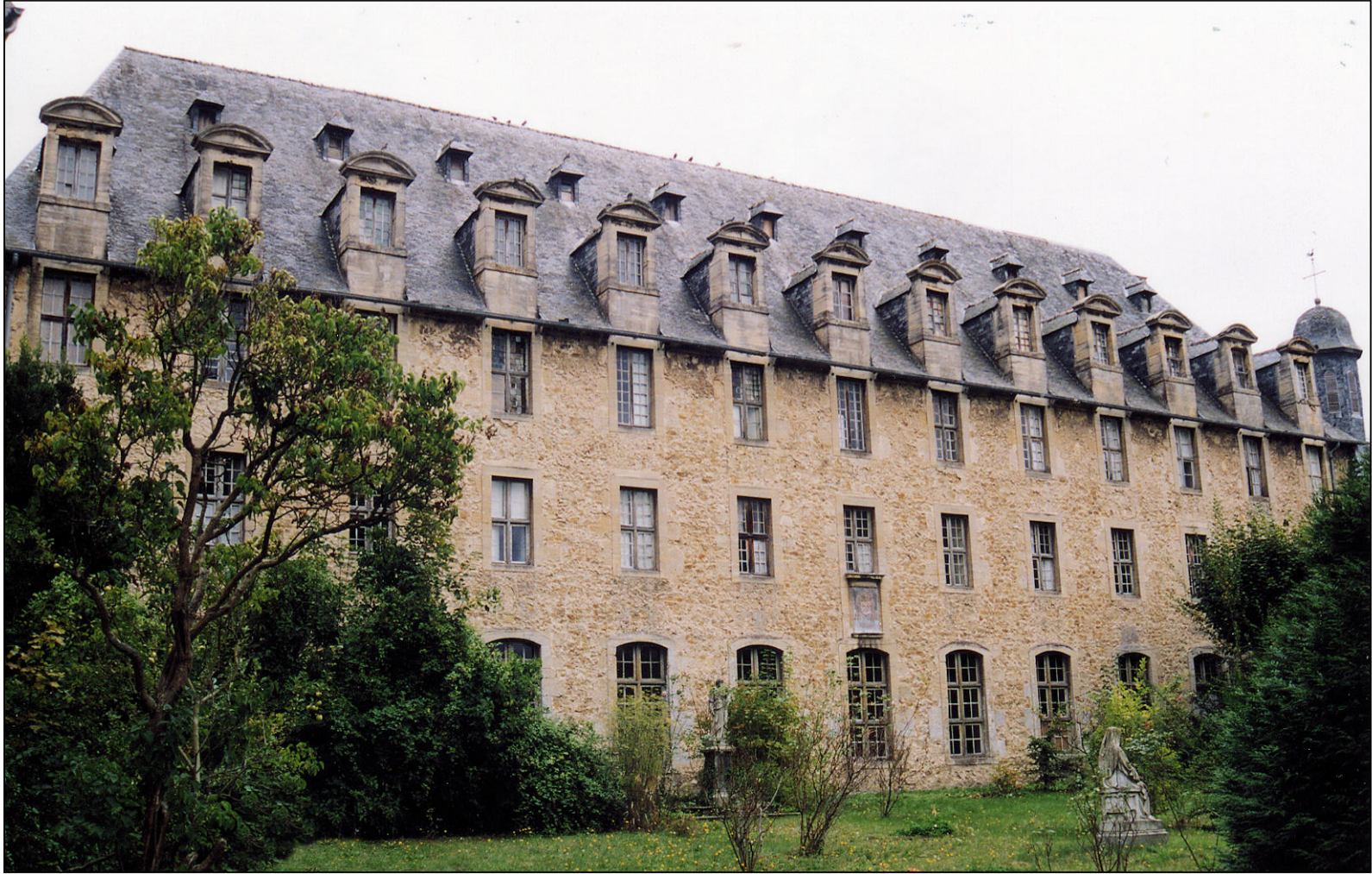
Fig. 1.1. Logis (façade ouest)
