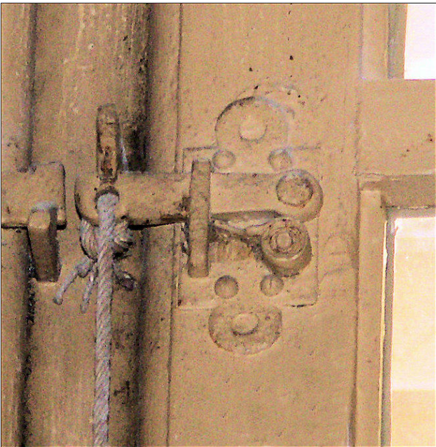
Fig. E.3. Loquet des croisées du rez-de-chaussée
