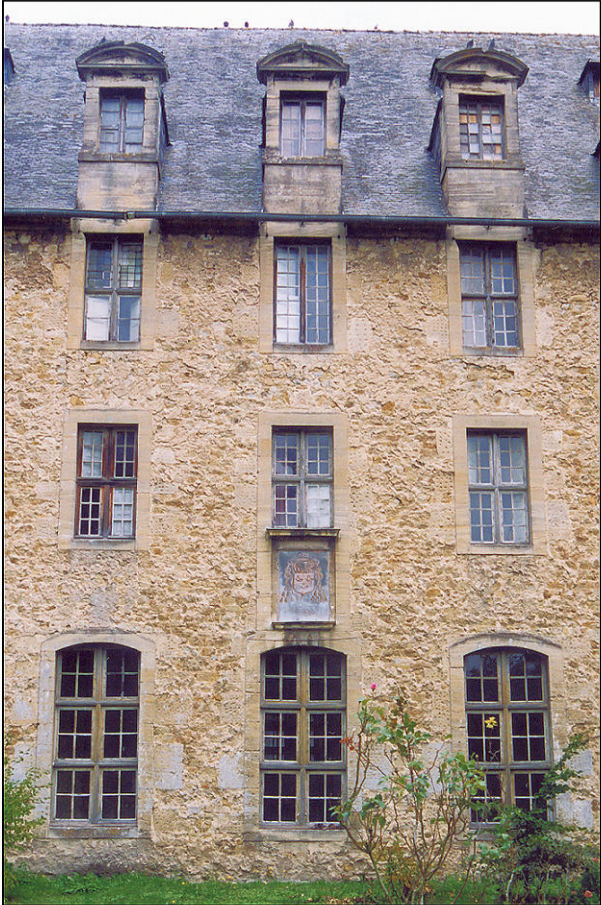
Fig. 5.1. Logis (façade ouest)
