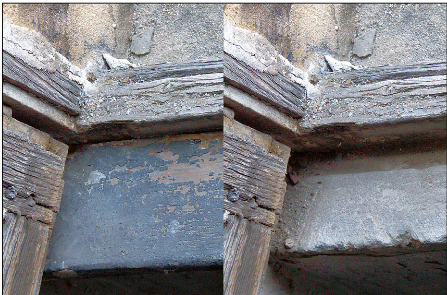
Fig. 3.6. Appui de la fenêtre 1. avec tablette 2. sans tablette
