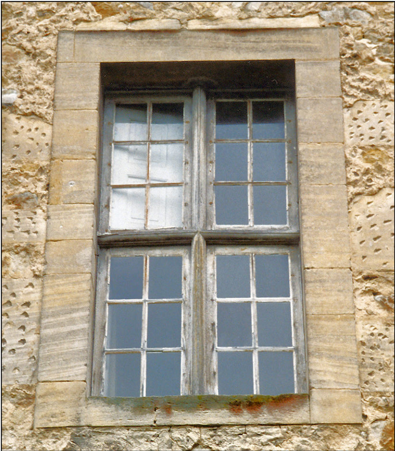
Fig. 5.4. Croisée du 1er étage (logis)
