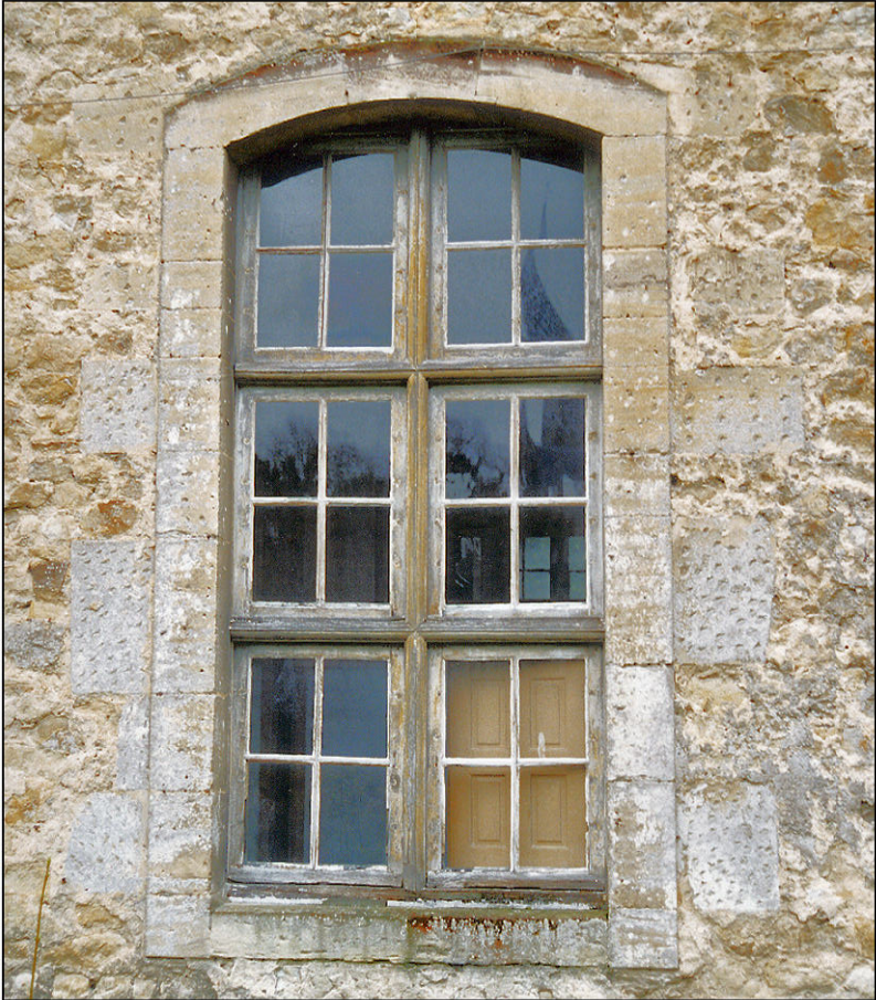
Fig. 5.2. Croisée du rez-de-chaussée (logis)
