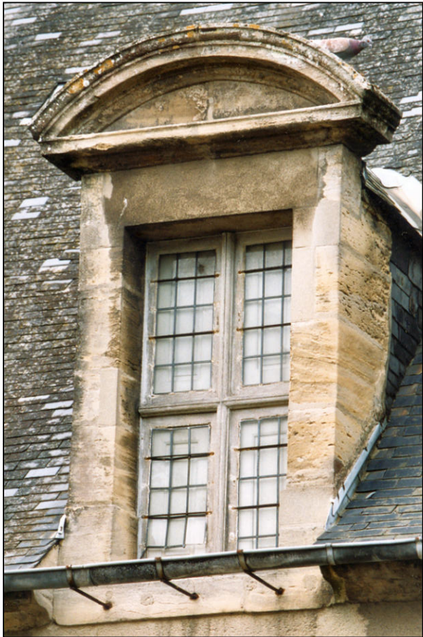
Fig. 4.1. Lucarne (façade est)
