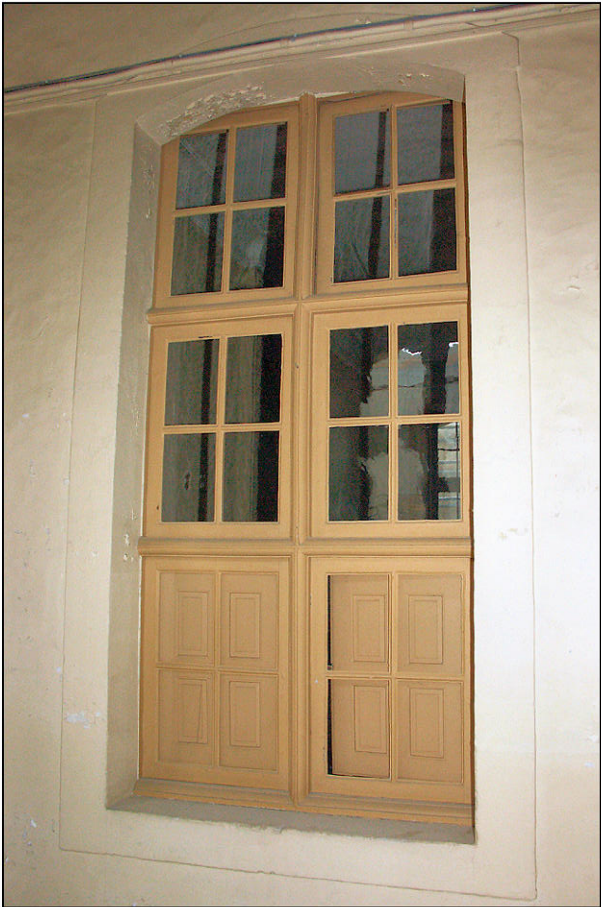
Fig. 5.3. Croisée du rez-de-chaussée (logis)
