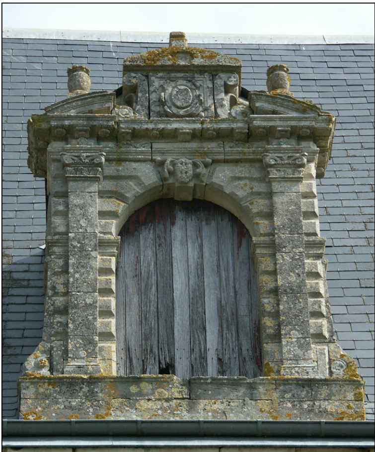
Fig. 1.6. Lucarne (façade sur cour)
