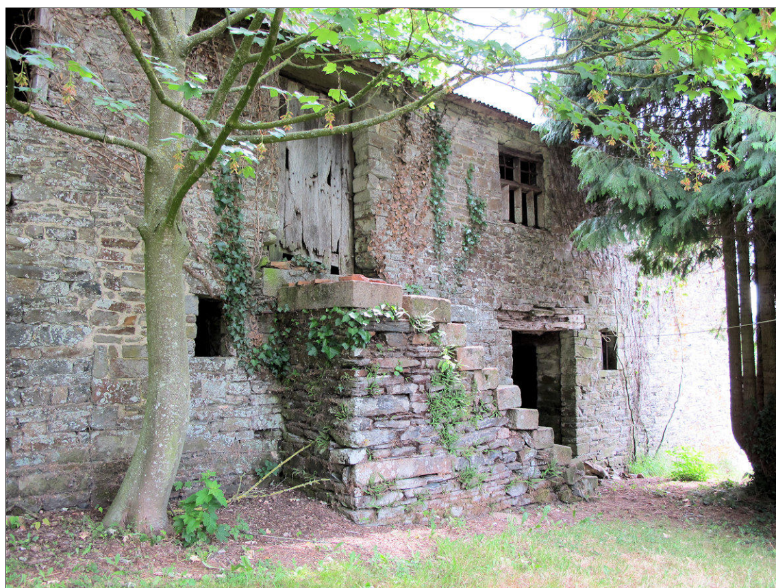
Fig. E.1. La façade antérieure (ouest)
