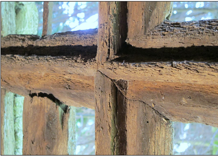
Fig. 2.3. Assemblage du meneau et du croisillon
