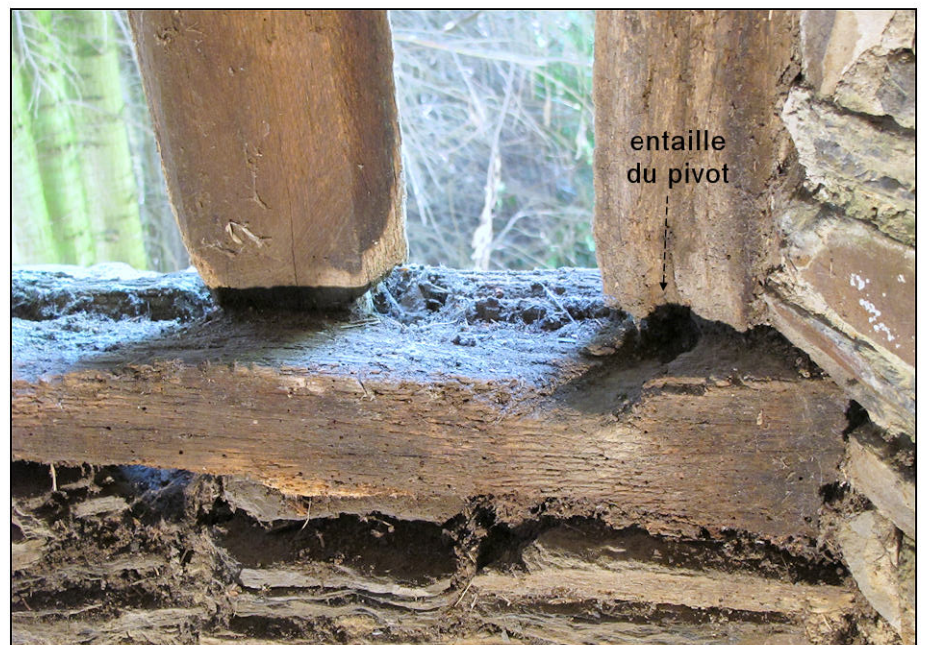
Fig. 2.6. Appui (angle droit)
