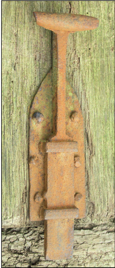
Fig. 2.3. Verrou inférieur
