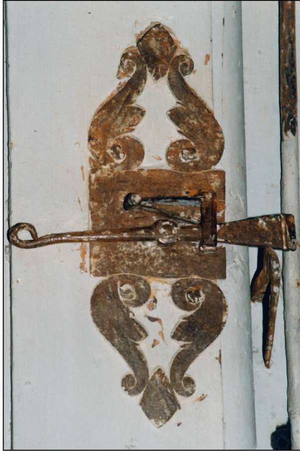
Fig. 3.2. Volet inférieur / loquet
