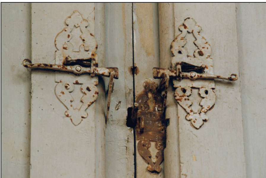
Fig. 3.7. Vantaux vitrés et volets supérieurs / loquets
