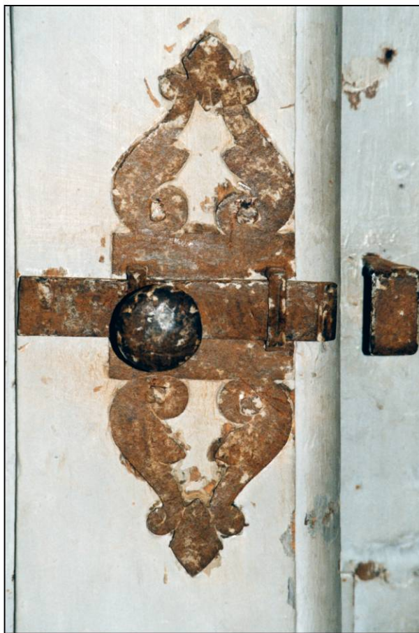
Fig. 3.5. Volet inférieur / targette
