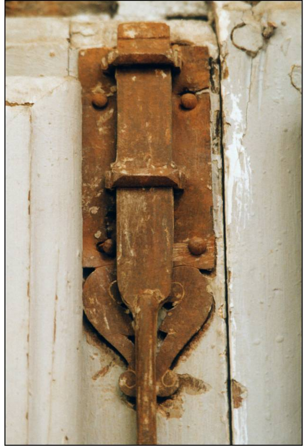
Fig. 3.3. Vantail vitré inférieur / verrou
