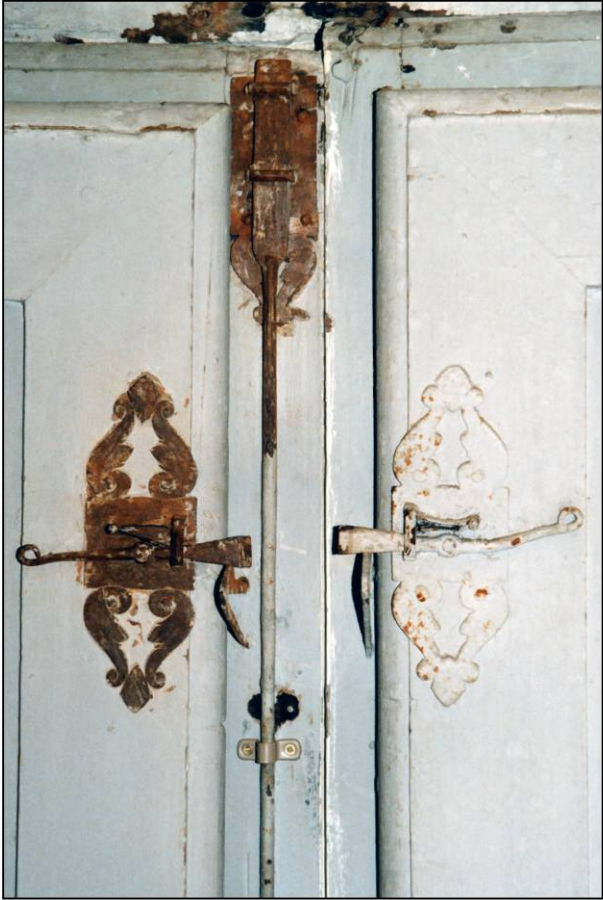
Fig. 3.1. Vantaux et volets inf. / verrou et loquets
