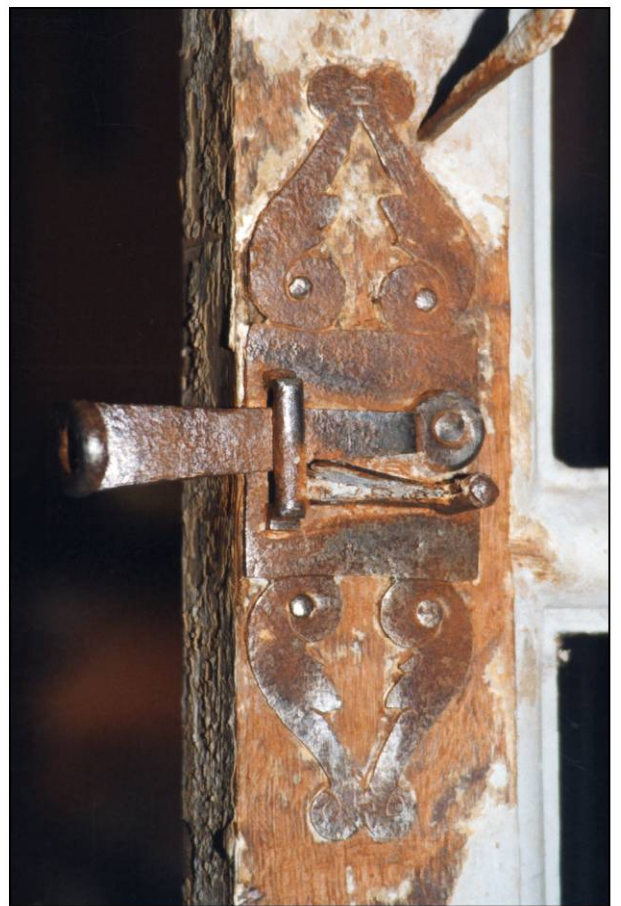
Fig. 3.6. Vantail vitré supérieur / loquet
