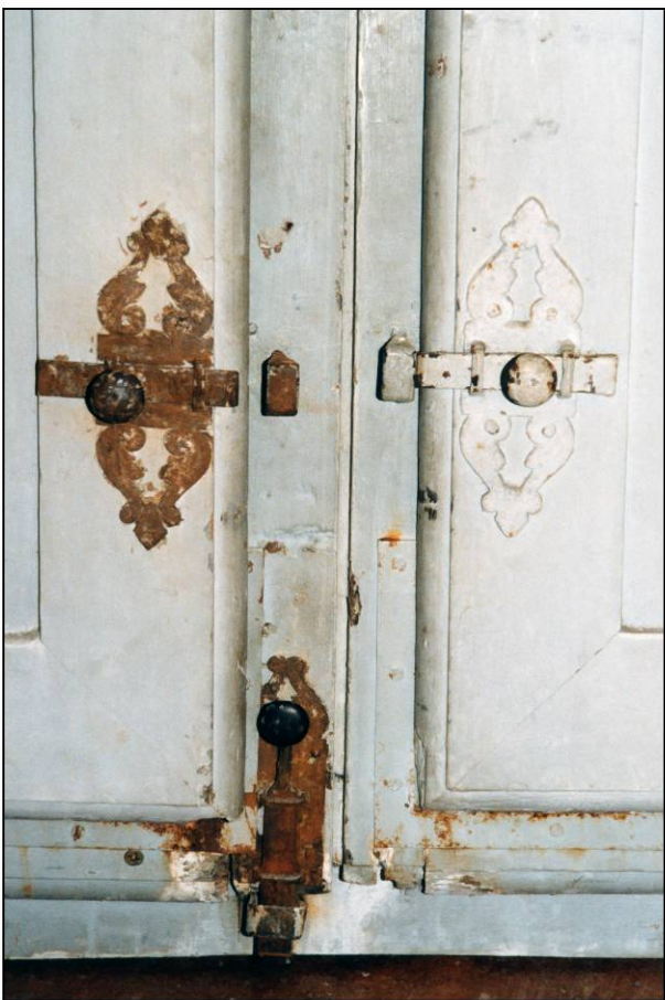
Fig. 3.4. Vantaux et volets inf. / targettes et verrou
