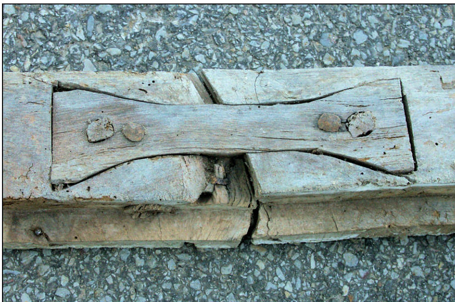
Fig. 2.3. Consolidation de la traverse
