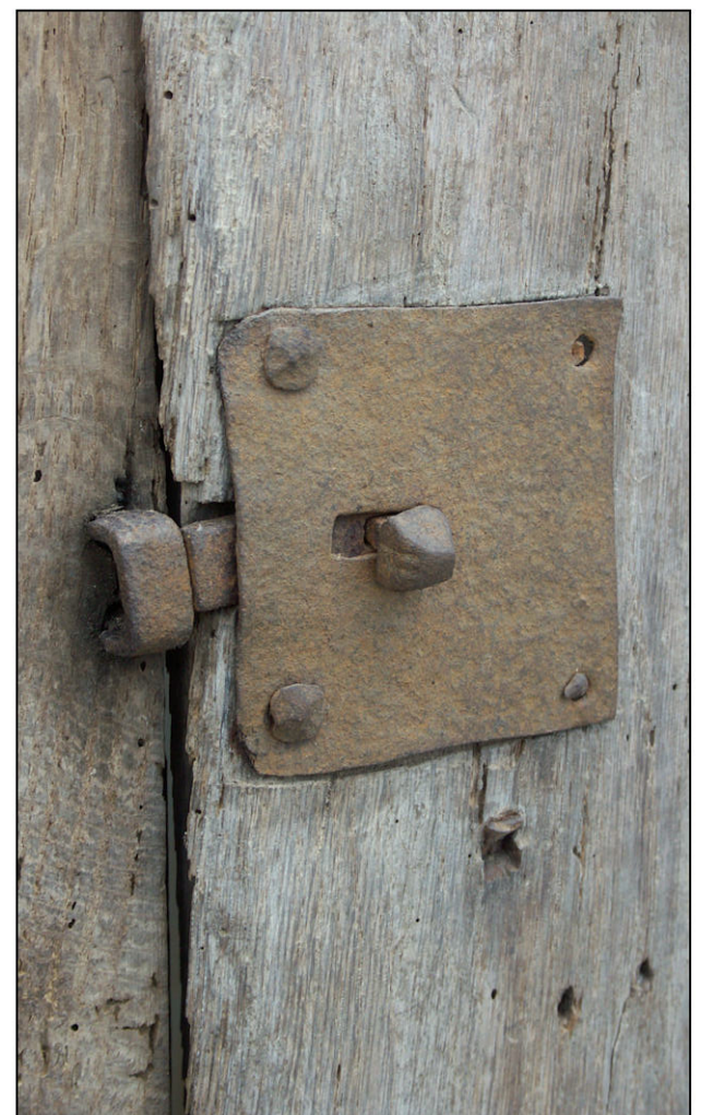
Fig. 3.7. Targette enclouonnée
