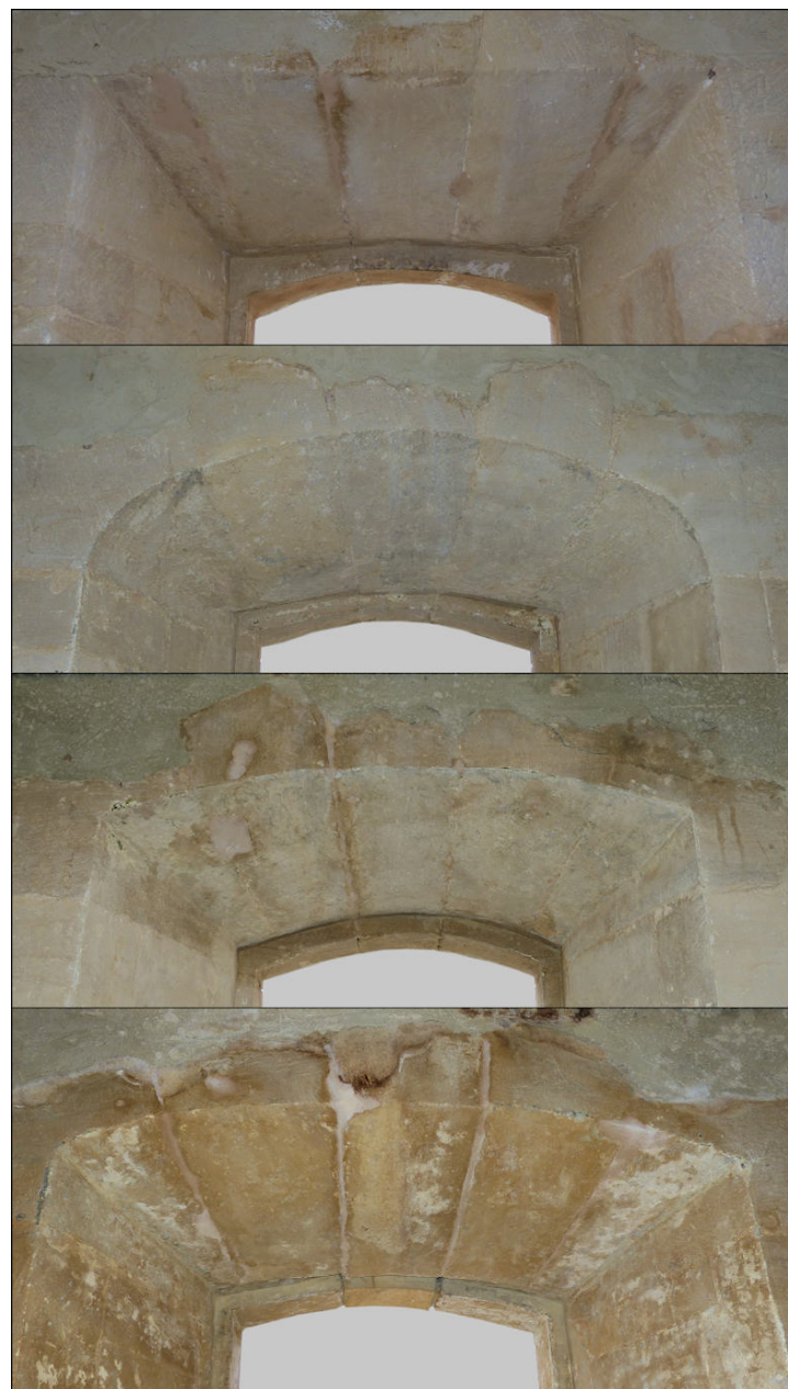
Fig. E.1. Arrière-voissures modifiées de l'étage
