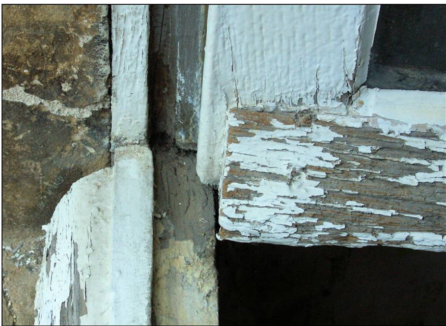
Fig. 6.3. Pièce d'appui et battants de rive
