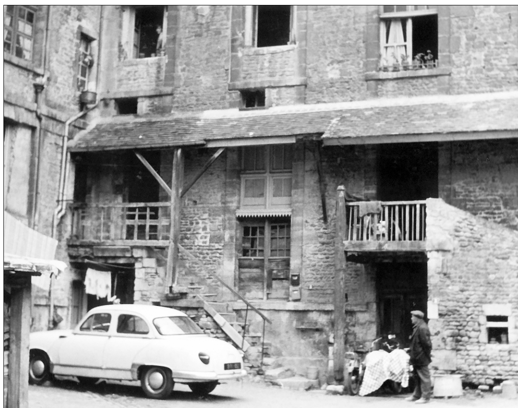
Fig. E.3. Aile orientale. Façade est (1971).
