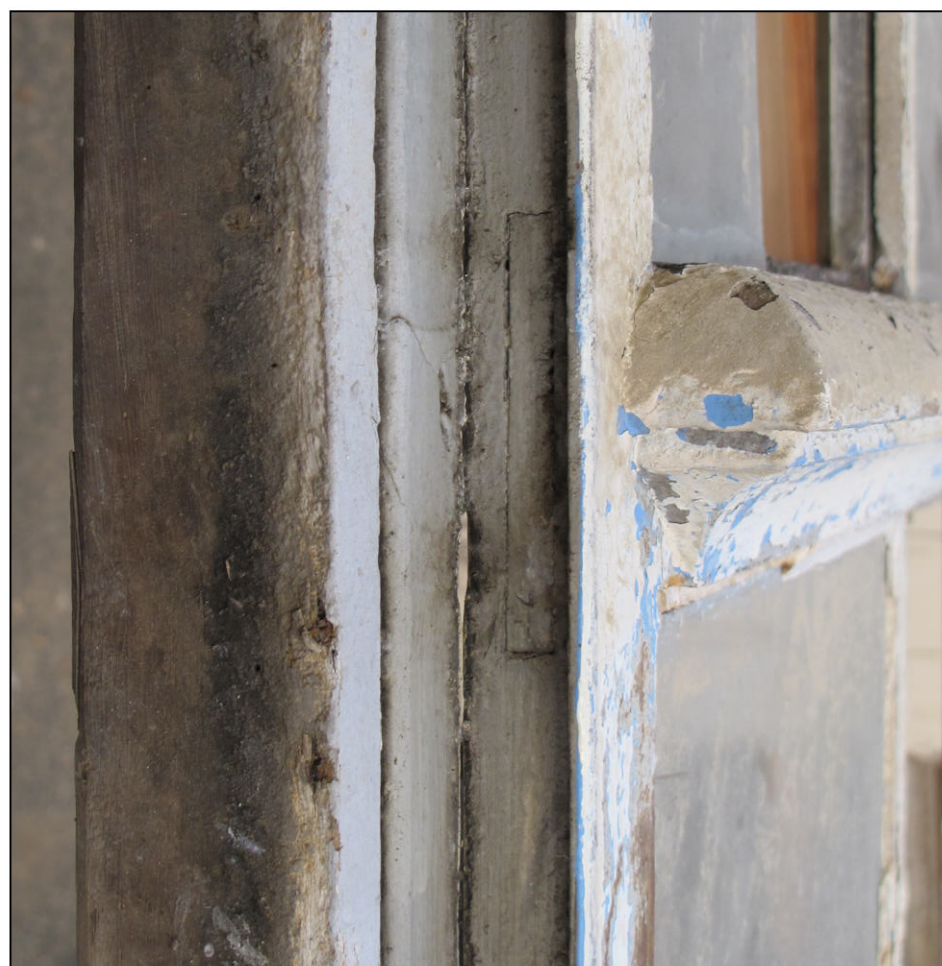
Fig. 6.5. Vantail vitré / traverse flottée (châssis D)
