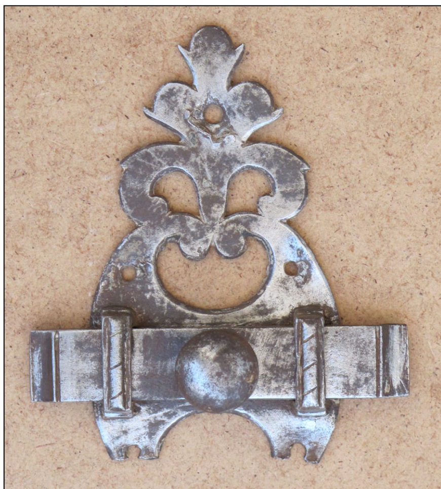
Fig. 6.4. Targette (châssis E)
