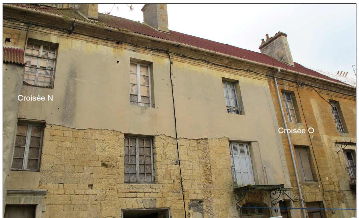
Fig. 2.4. Aile ouest (façade ouest)
