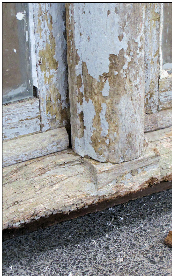
Fig. 3.4. Assemblage meneau / pièce d'appui
