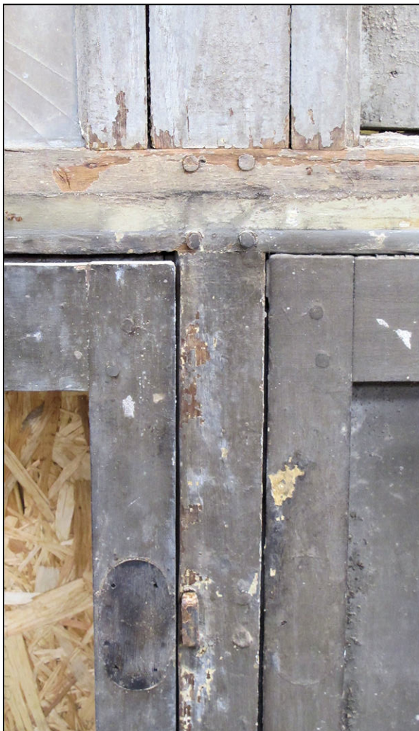
Fig. 4.3. Assemblage meneau / croisillon (B)
