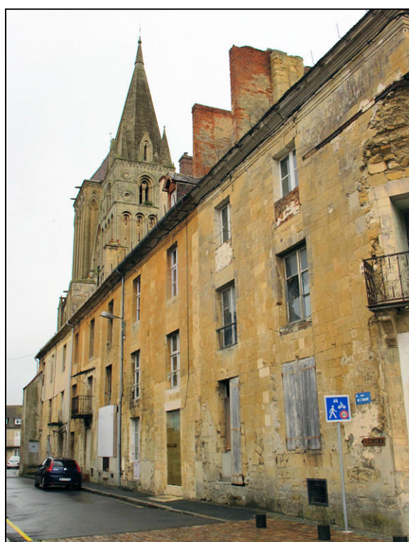
Fig. 2.3. Aile ouest (façade ouest)
