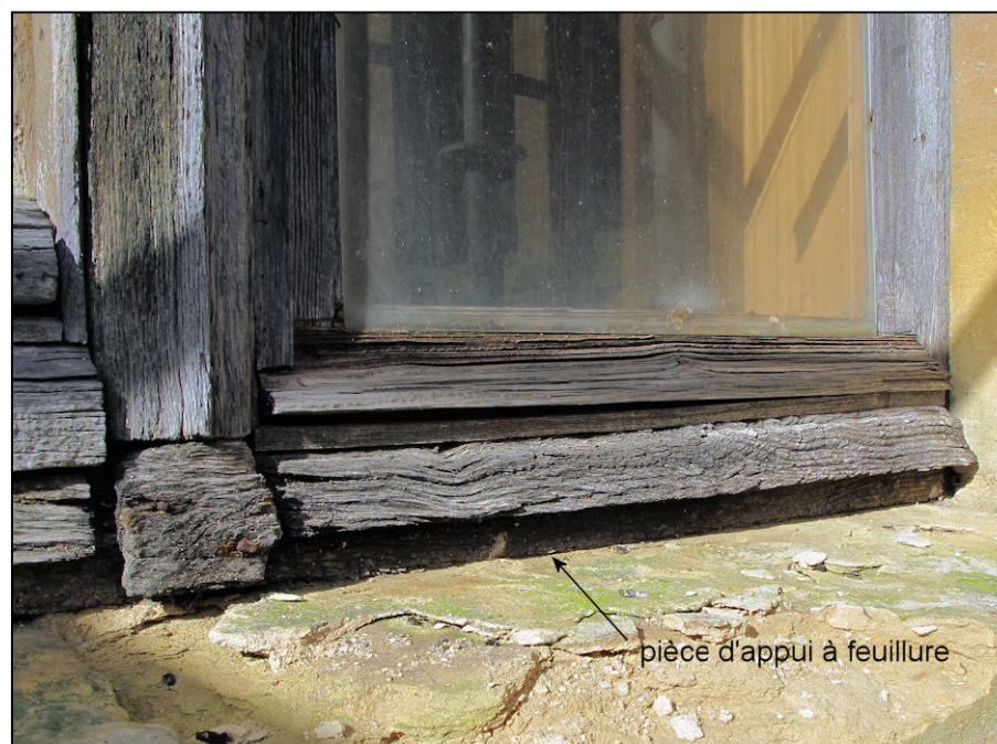
Fig. 12.3. Pièce d'appui (K)
