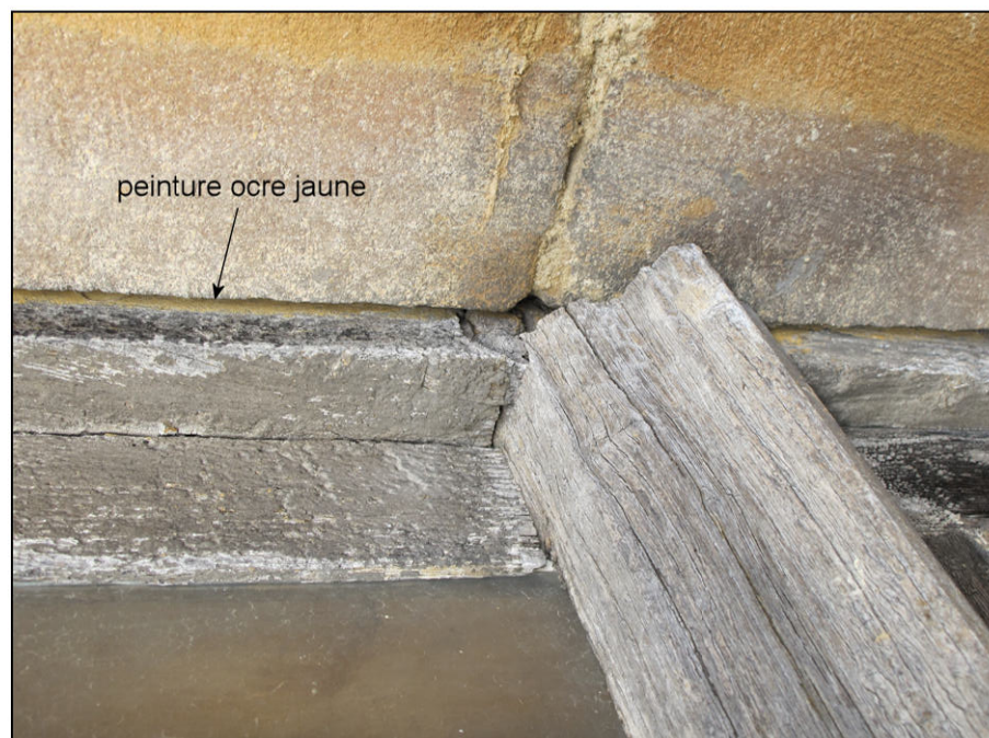
Fig. 12.2. Meneau et traverse haute (K)
