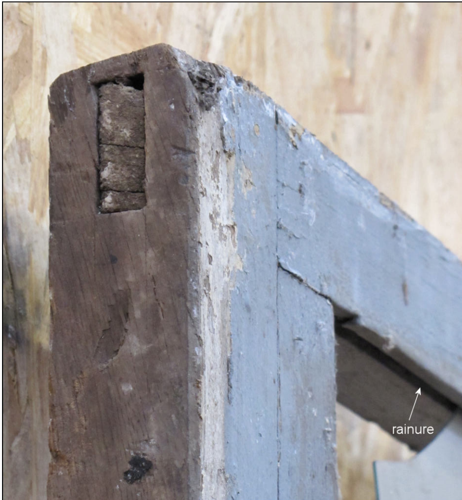
Fig. 11.1. Traverse haute / assemblage
