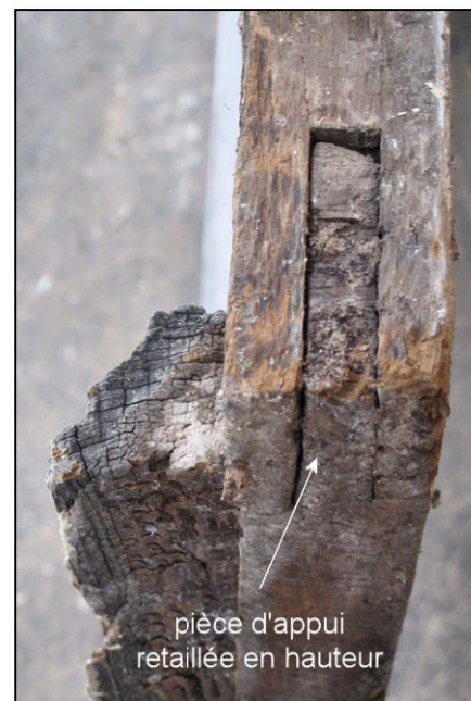
Fig. 11.7. Pièce d'appui pièce d'appui retournée en hauteur
