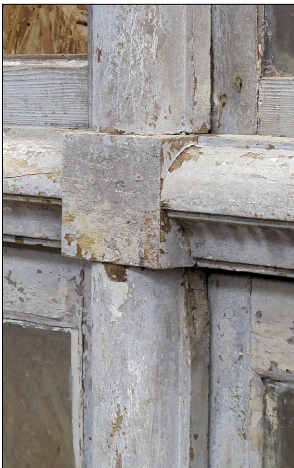
Fig. 3.3. Assemblage meneau / croisillon
