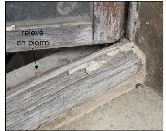
Fig. 9.3. Appui et pièce d'appui (I)
