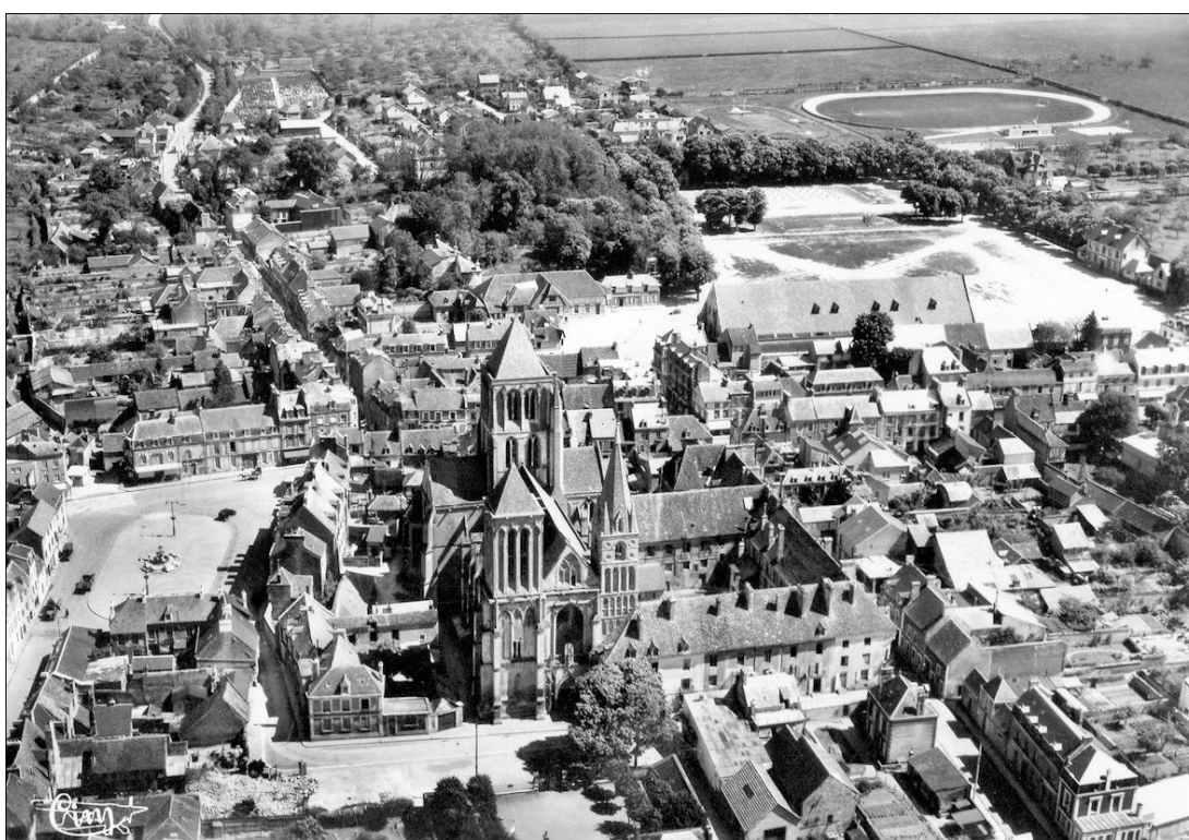
Fig. E.8. L'abbaye vue depuis l'ouest. Milieu du XX e siècle.
