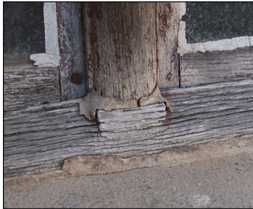
Fig. 9.2. Pièce d'appui (I)
