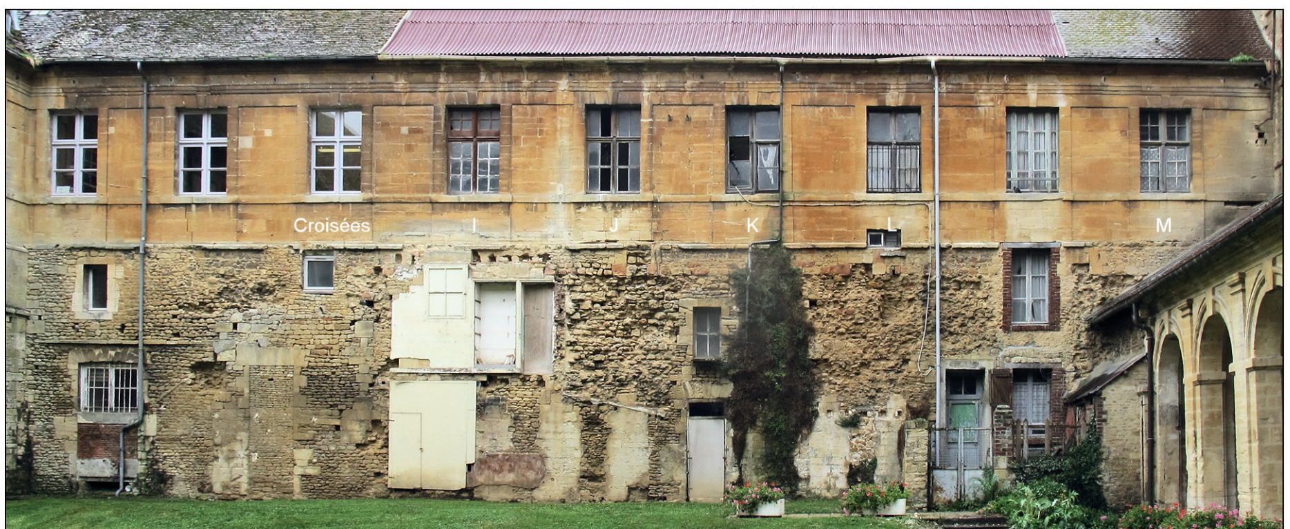
Fig. 2.2. Aile ouest (façade est sur le cloître)
