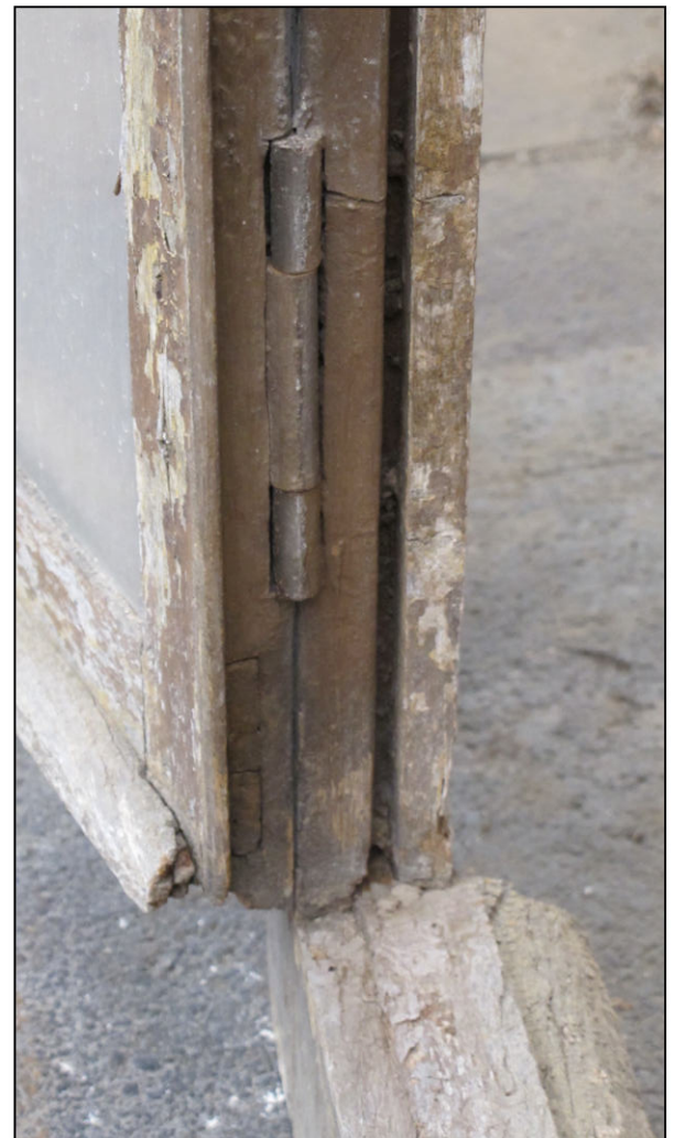
Fig. 4.5. Pièce d'appui et jet d'eau (B)
