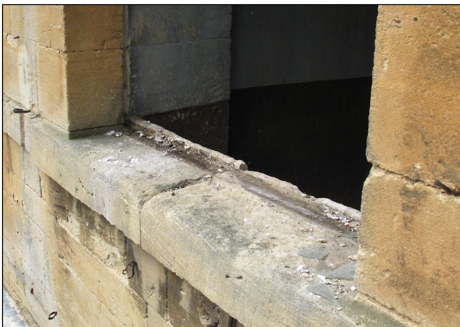
Fig. 11.5. Appui avec relevé (aile ouest / extrémité nord)
