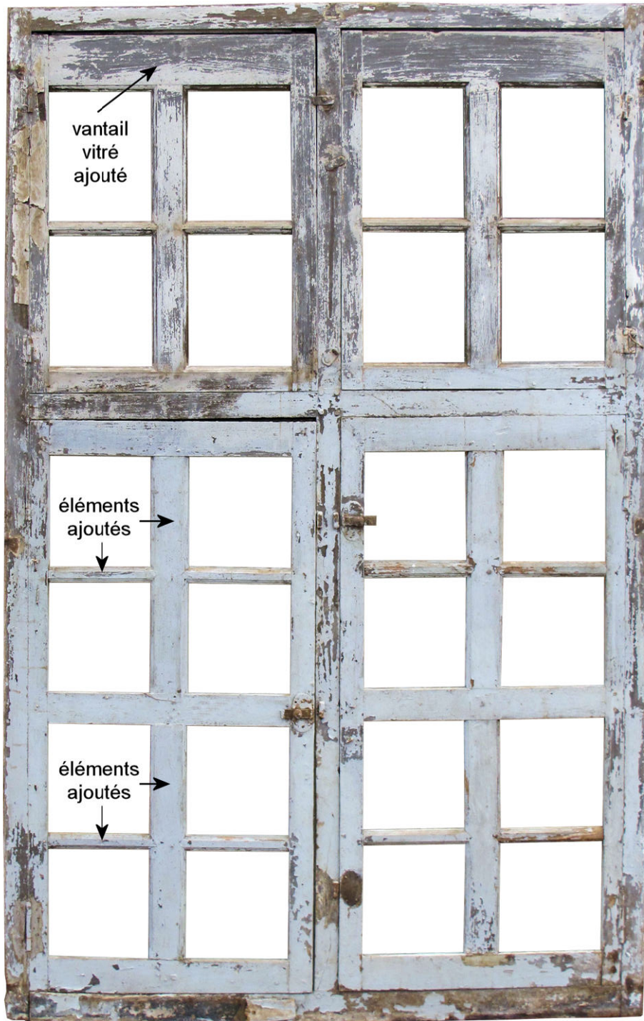
Fig. 3.1. Elévation intérieure
