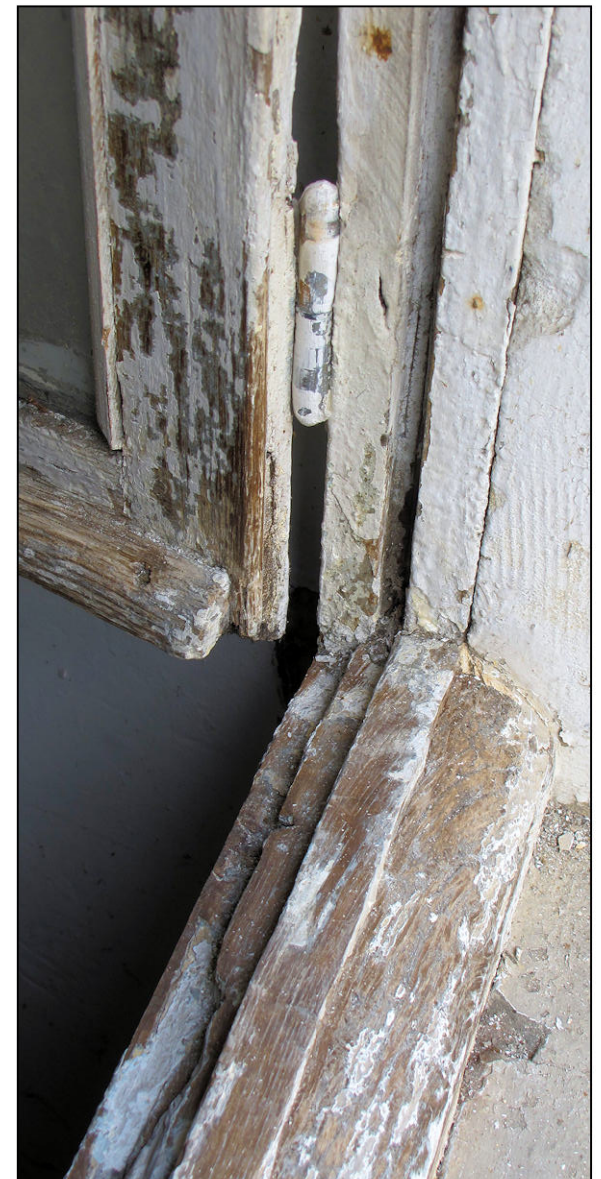
Fig. 8.4. pièce d'appui et jet d'eau
