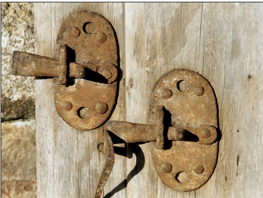
Fig. 1.7. Loquets (vantail vitré et volet sup.)
