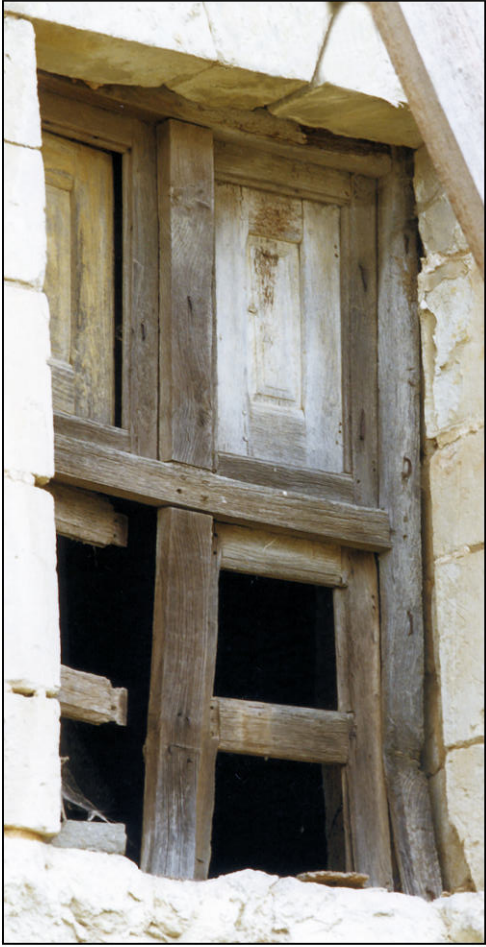
Fig. 1.1. Croisée (élévation extérieure)
