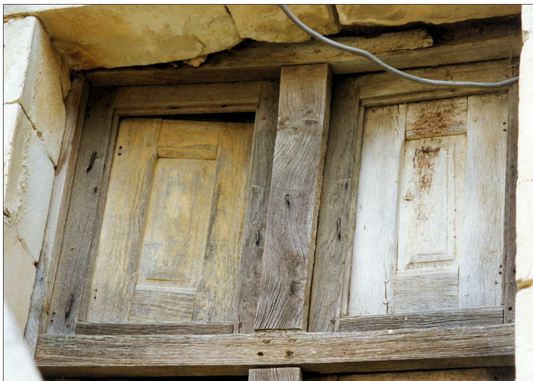
Fig. E.2. Les compartiments du haut de la croisée. A noter, les traces de peinture ocre jaune sur les volets
