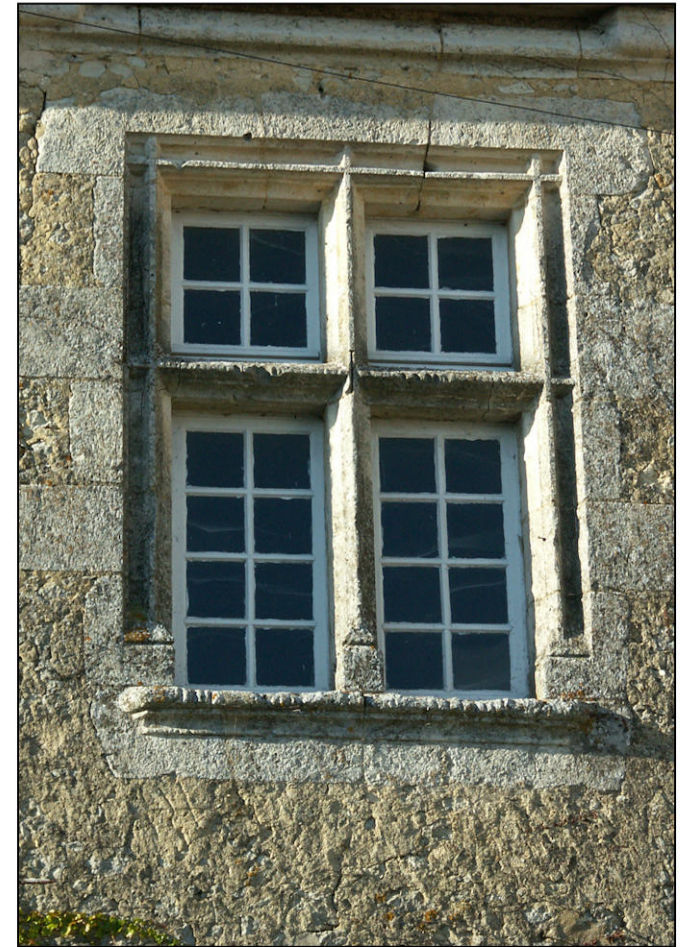
Fig. 4.2. Croisée (façade sud)
