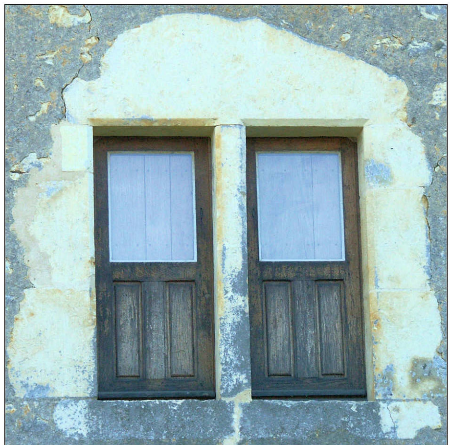
Fig. 1.4. Fenêtre et châssis restitué
