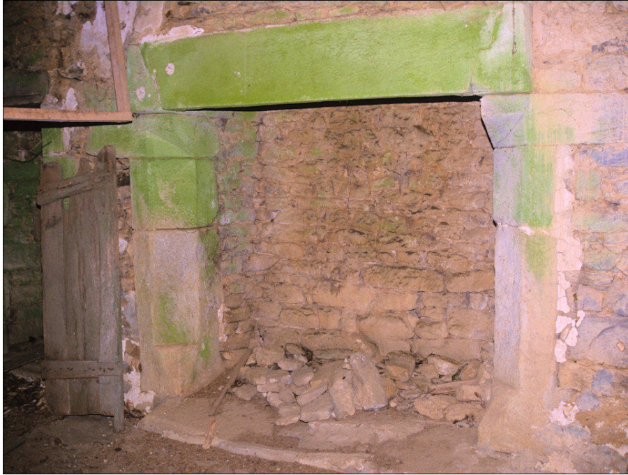
Fig. E.4. Cheminée du pignon sud
