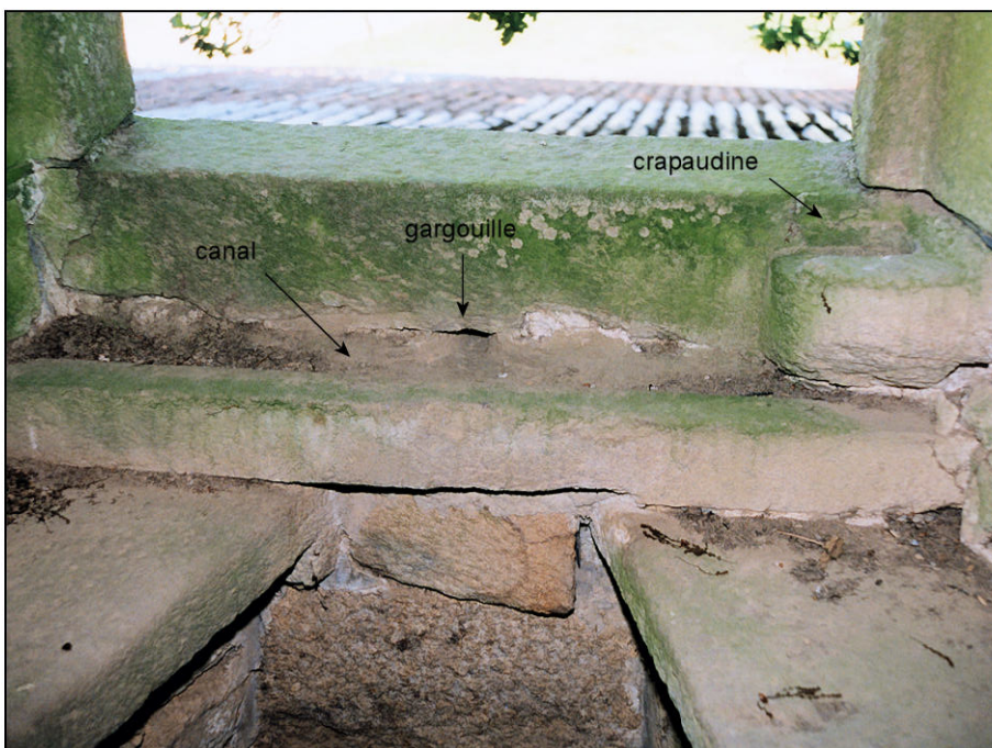
Fig. 2.7. Appui de la fenêtre
