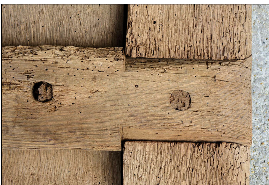
Fig. 4.5. Volet du bas (assemblage supérieur)
