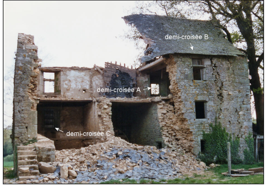
Fig. 1.2. Façade ouest (état en 1997, avant démolition)
