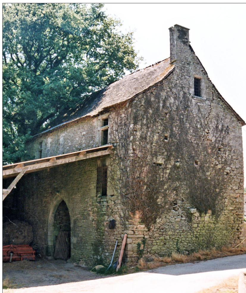
Fig. E.1. Façade antérieure (est)
