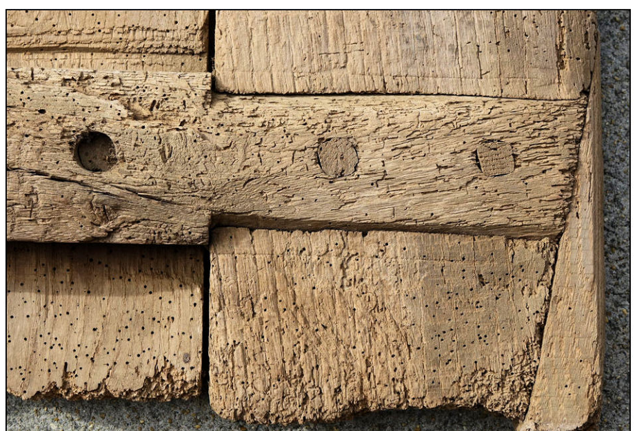
Fig. 4.6. Volet du haut (assemblage inférieur)
