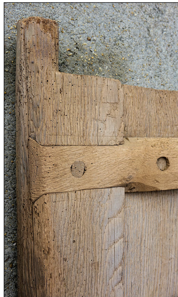
Fig. 5.5. Assemblage supérieur
