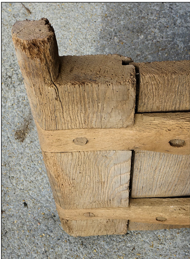
Fig. 5.3. Assemblages du montant
