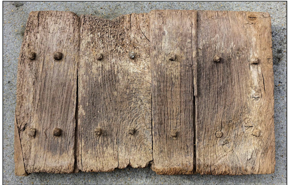
Fig. 4.2. Volet du haut (vue extérieure)
