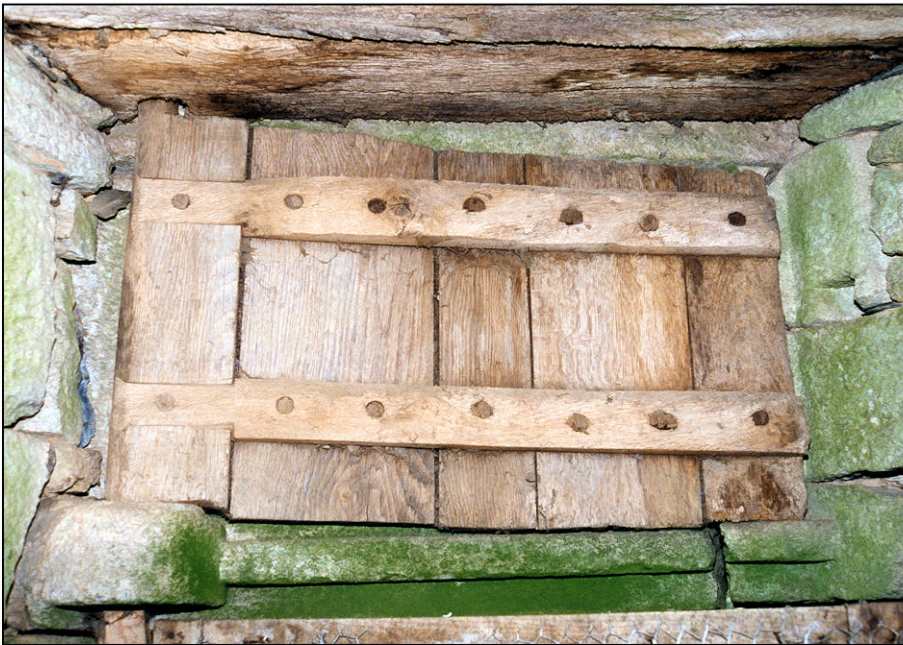
Fig. 3.4. Volet (vue intérieure)
