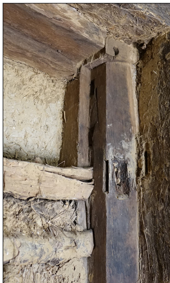
Fig. 2.5. Entaille de la fiche supérieure
