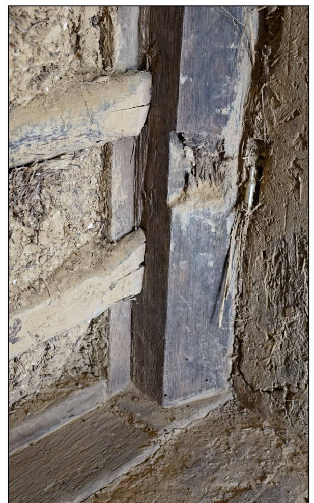
Fig. 2.6. Entaille de la fiche inférieure
