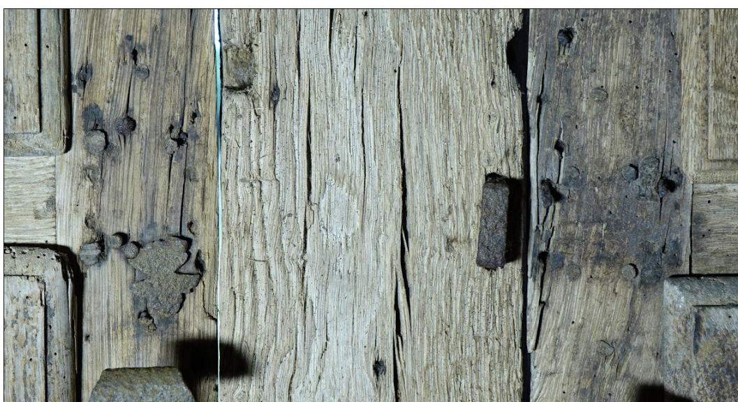
Fig. E.7. Châssis C et B, traces des targettes supérieures
