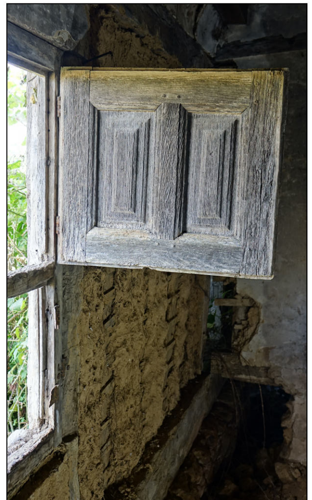
Fig. 10.5. Volet sup. (volet inf. déposé)
