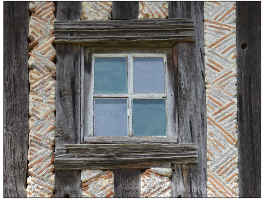
Fig. 6.2. Petite fenêtre (façade est / 1 er étage)
