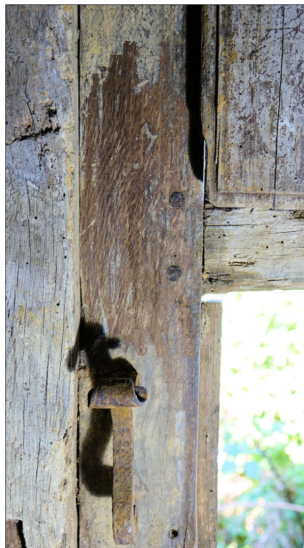
Fig. E.9. Châssis C, targette inférieure Fig. E.10. Châssis F, targette supérieure Fig. E.11. Châssis F, sondage au droit de la traverse intermédiaire
