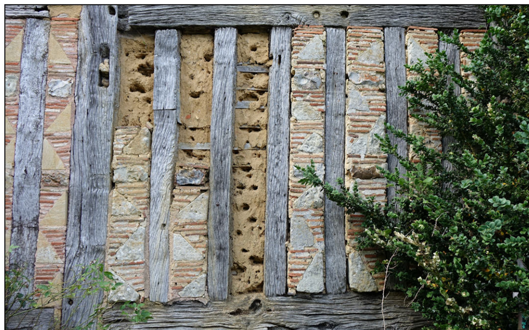
Fig. 1.4. Pan de bois et hourdis de pierres, tuileaux et silex (pignon sud)
