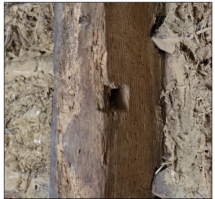
Fig. 2.3. Gâche supérieure du meneau
