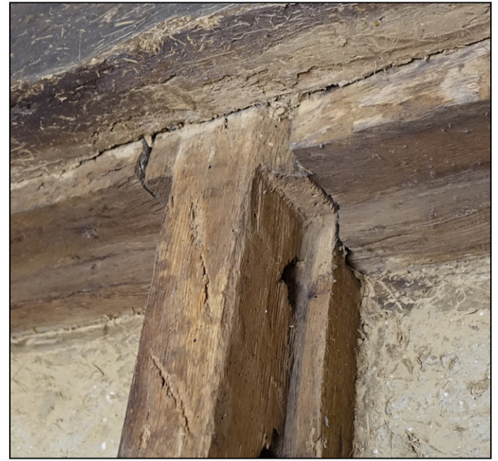
Fig. 2.2 Asemblage du meneau
