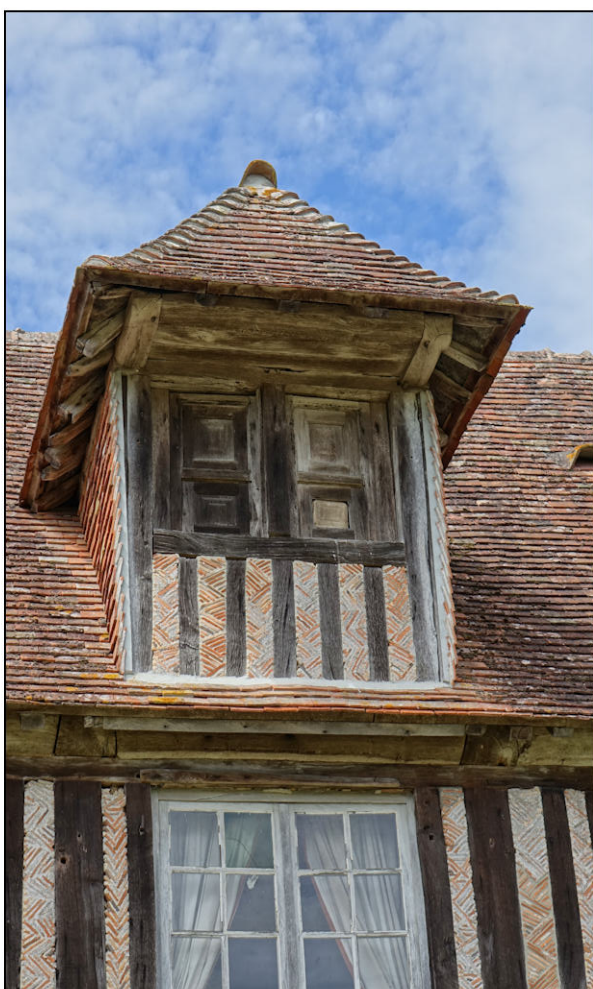
Fig. 7.2. Lucarne (façade est, côté sud)
