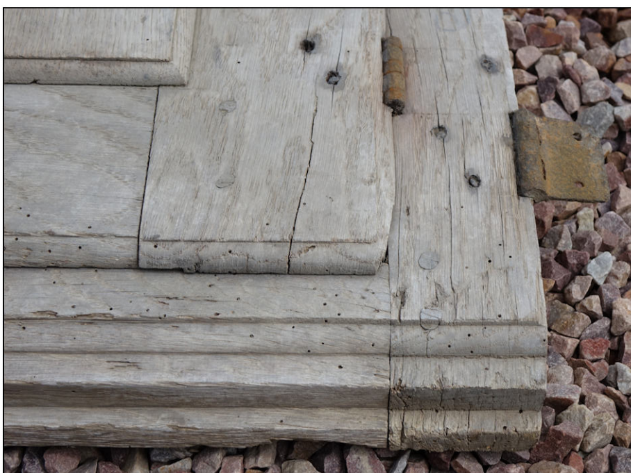
Fig. 9.6. Feuillures de recouvrement
