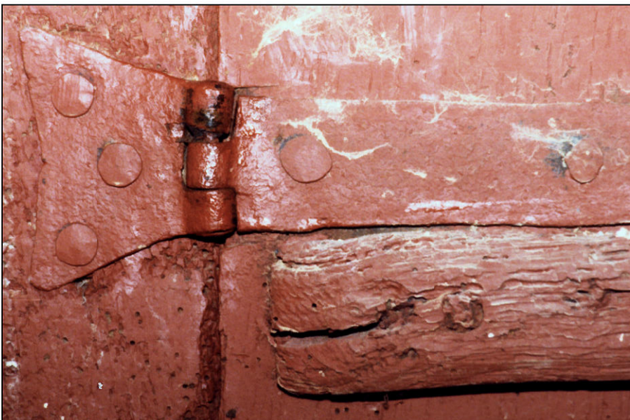
Fig. 3.5. Charnière inférieure (détail)
