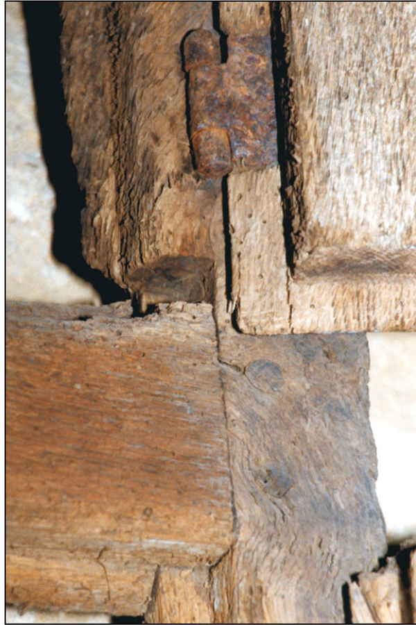
Fig. 2.2. Dormant A - montant d. / croisillon (int.)
