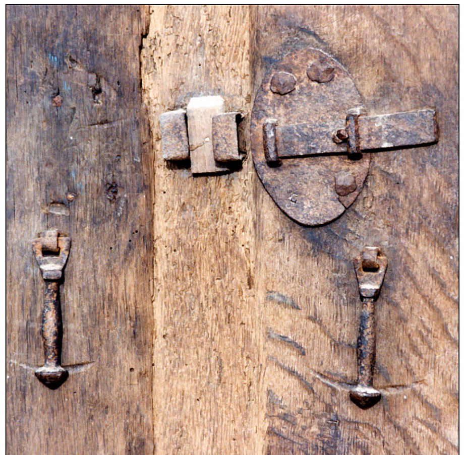
Fig. 1.4. Targette et pendeloques
