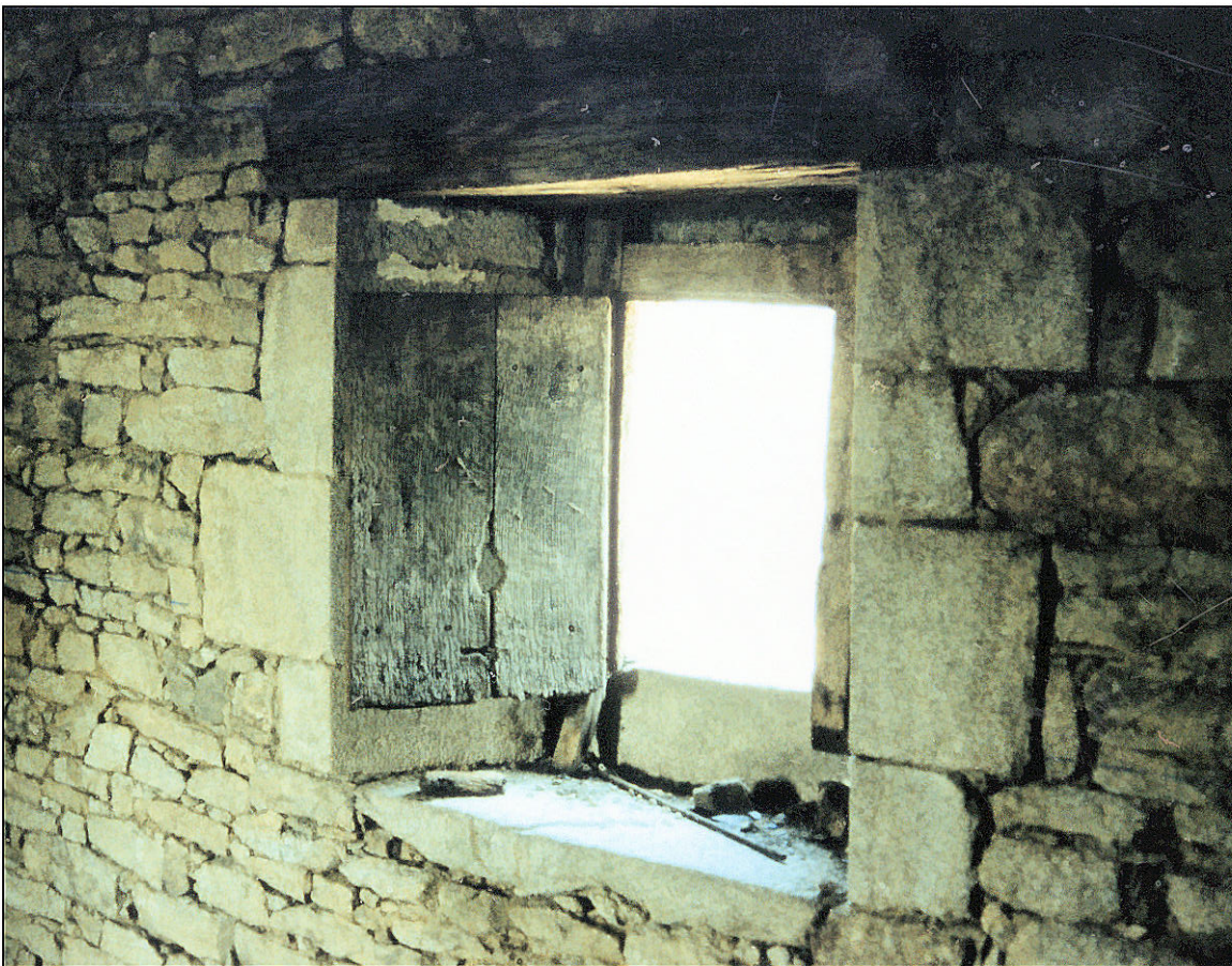
Fig. 3.3. Volet (élévation extérieure / avant restauration)
