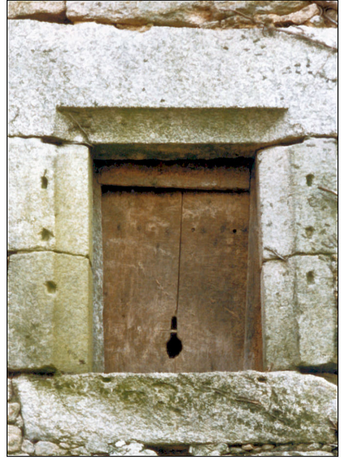
Fig. 3.2. Fenêtre (élévation ext. / avant restauration)
