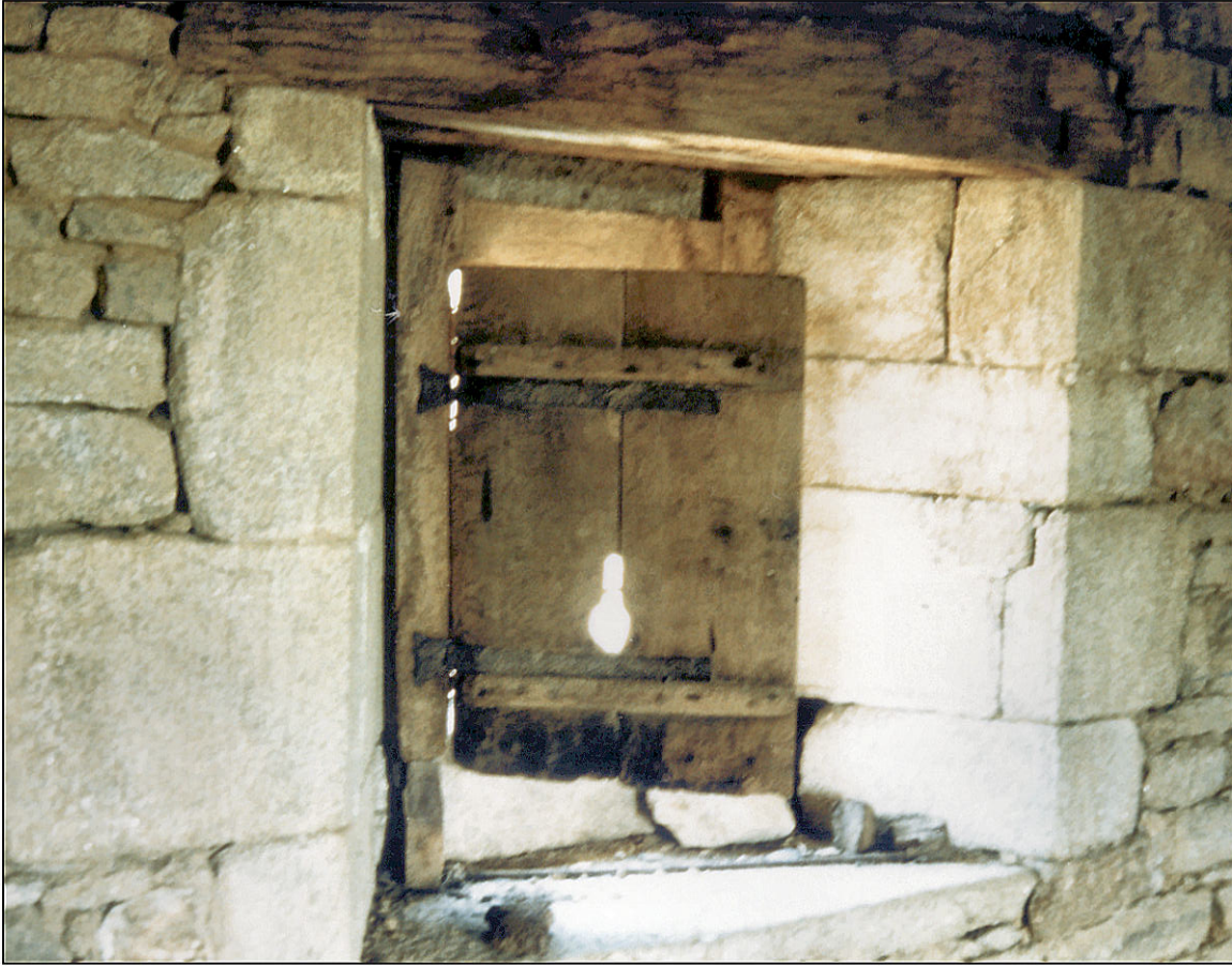
Fig. 3.1. Volet (élévation intérieure / avant restauration)
