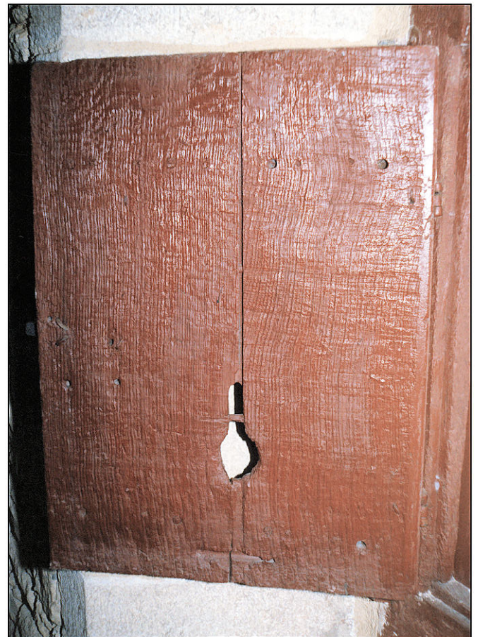
Fig. 3.4. Volet (élévation ext. / après restauration)
