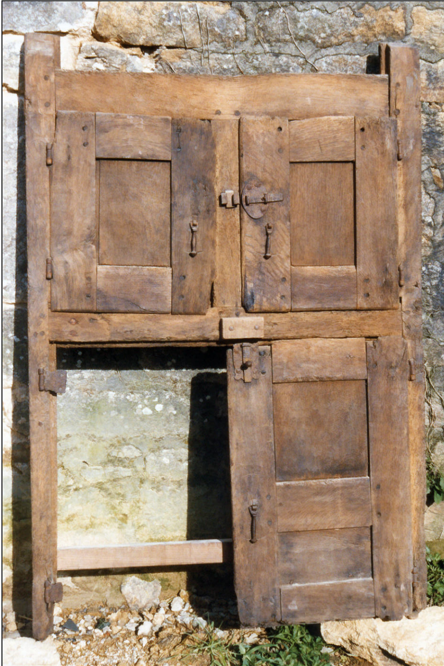
Fig. 1.1. Croisée (élévation intérieure)
