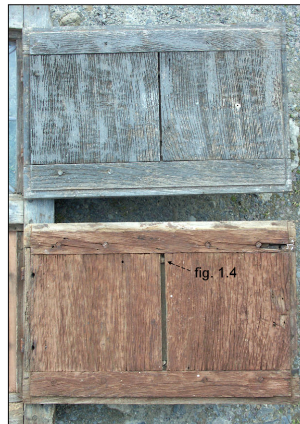
Fig. 1.5. Volets inférieurs (parement extérieur)
