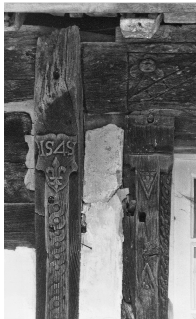
Fig. E.2. Fenêtre de l'étage (façade sud) Photo M.-H. Since, 1979, DRAC de Normandie
