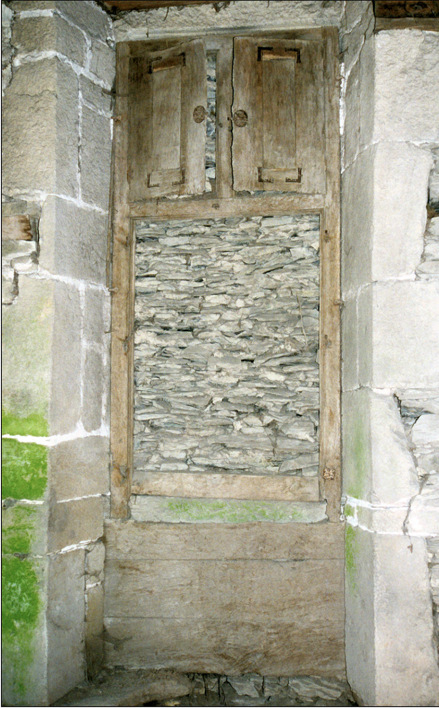
Fig. 4.1. Croisée (élévation intérieure)
