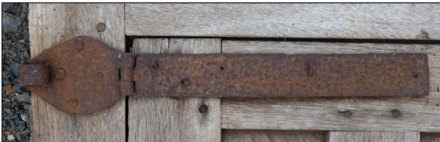
Fig. 2.2. Penture à charnière (vantail inférieur)
