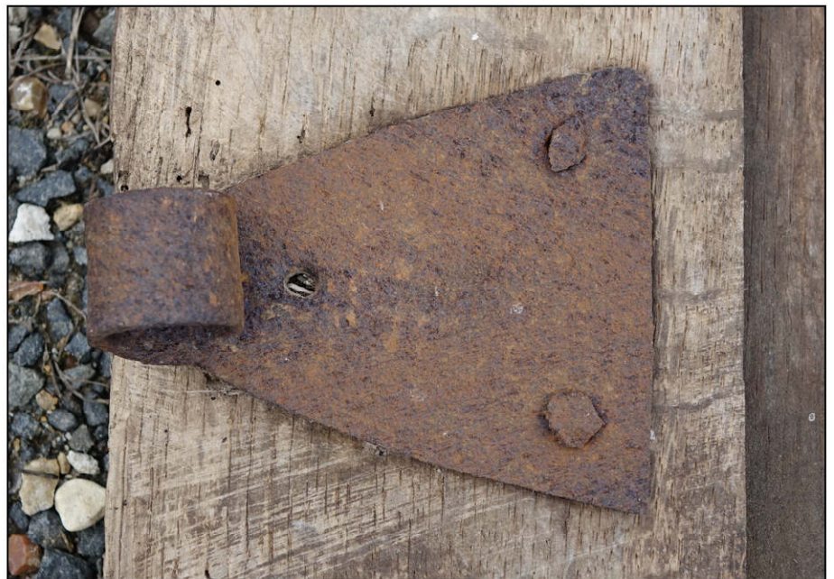
Fig. 2.5. Paumelle (vantail inférieur)
