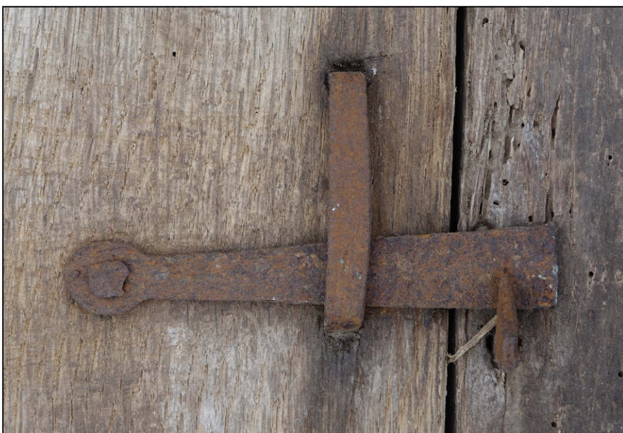
Fig. 2.3. Loquet (volet inférieur)
