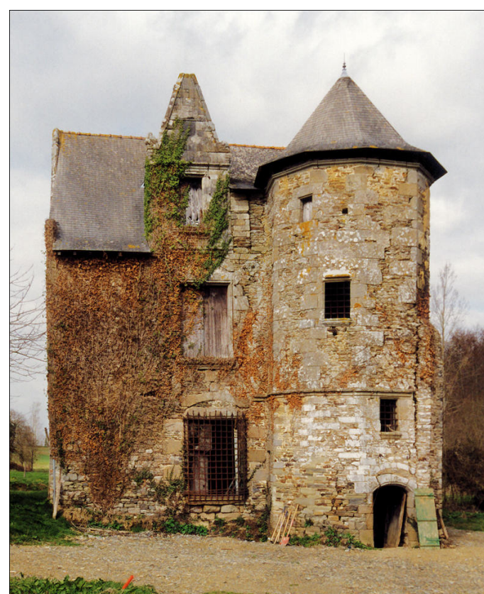
Fig. E.1. La façade antérieure
