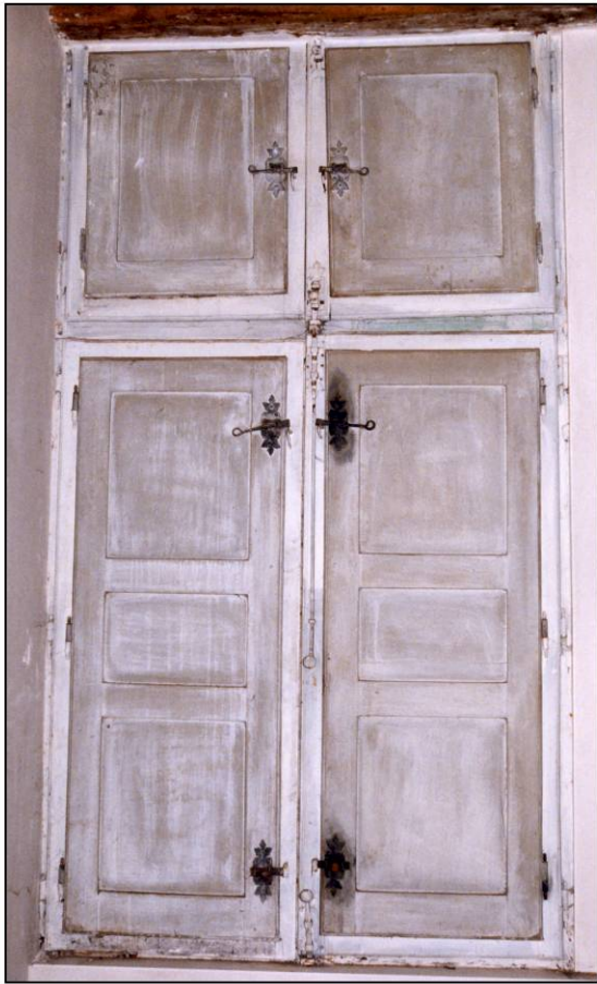
Fig. 1.1. Croisée (élévation intérieure)
