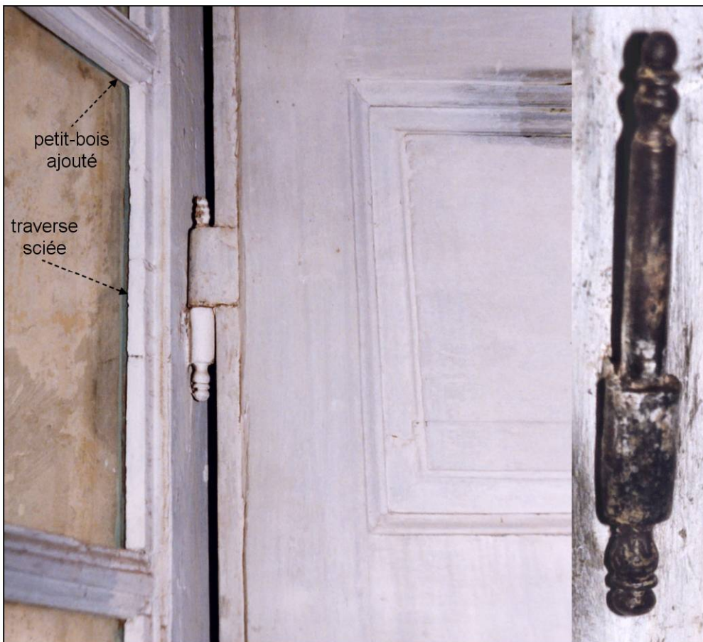
Fig. 1.4. Fiche à gond / volet et vantail vitré (détails)
