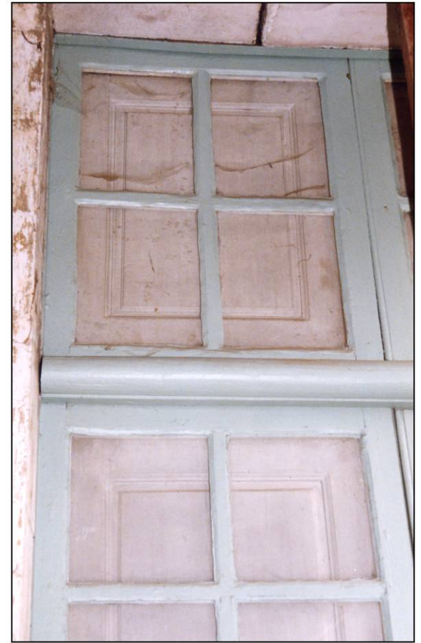
Fig. 1.3. Croisée (détail / élévation extérieure)
