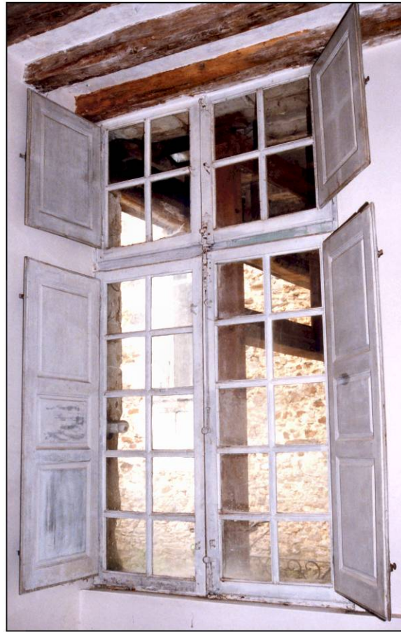
Fig. 1.2. Croisée (élévation intérieure)
