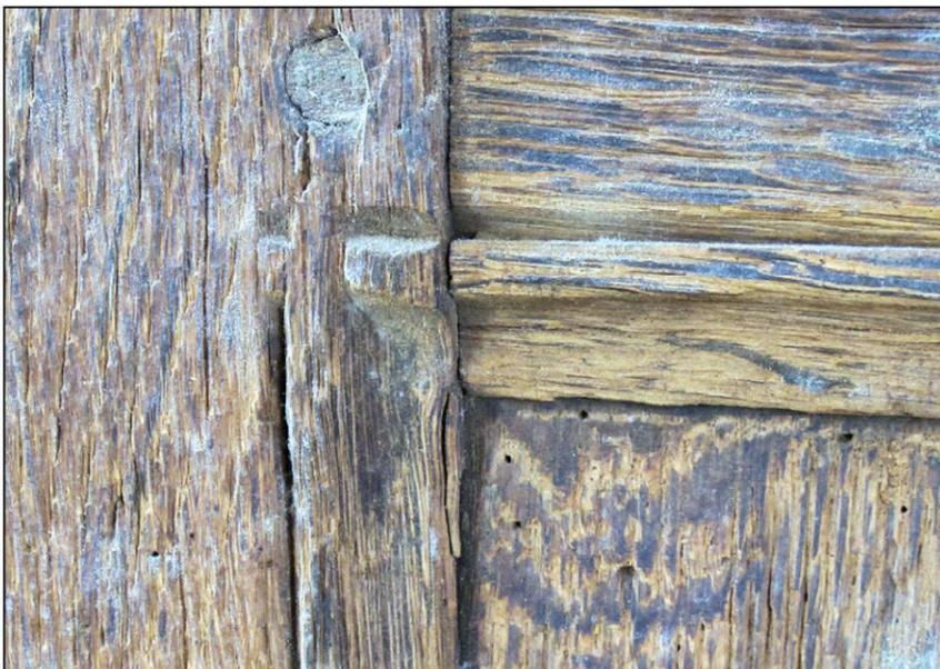
Fig. 6.4. Moulures (A / raccord d'angle supérieur)
