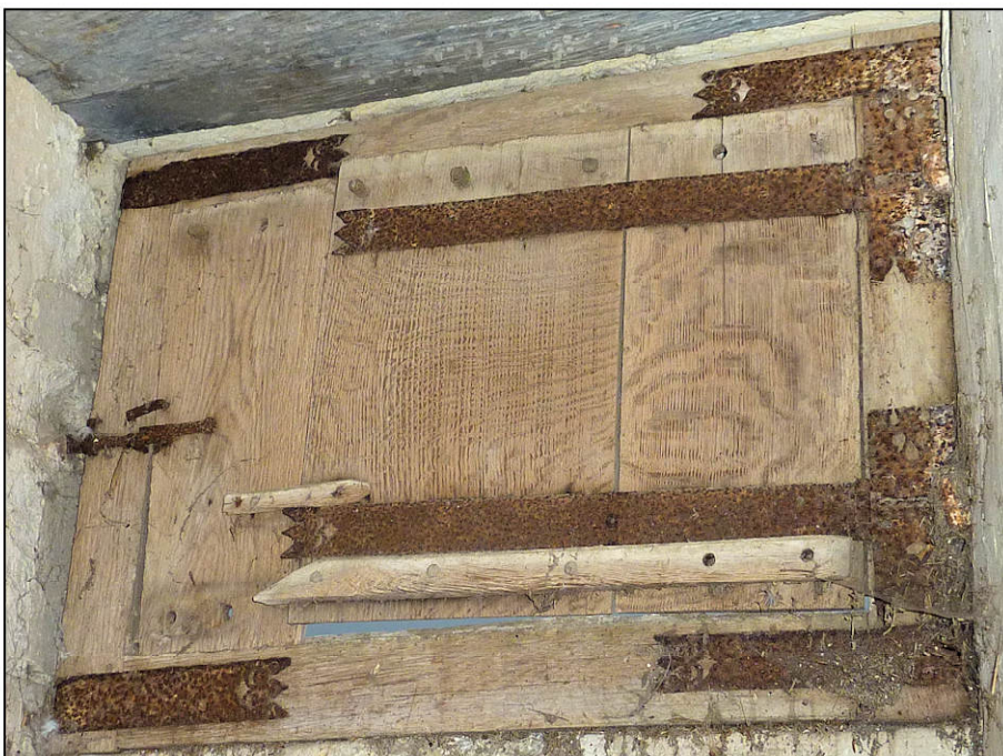
Fig. 3.5. Elévation intérieure (avant restauration)**
