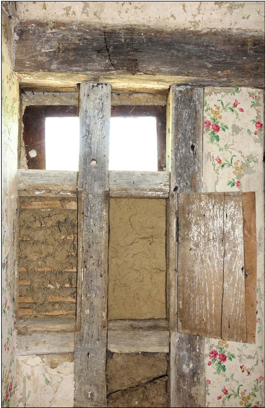
Fig. 2.2. Croisée (après dégagement des compartiments supérieurs)
