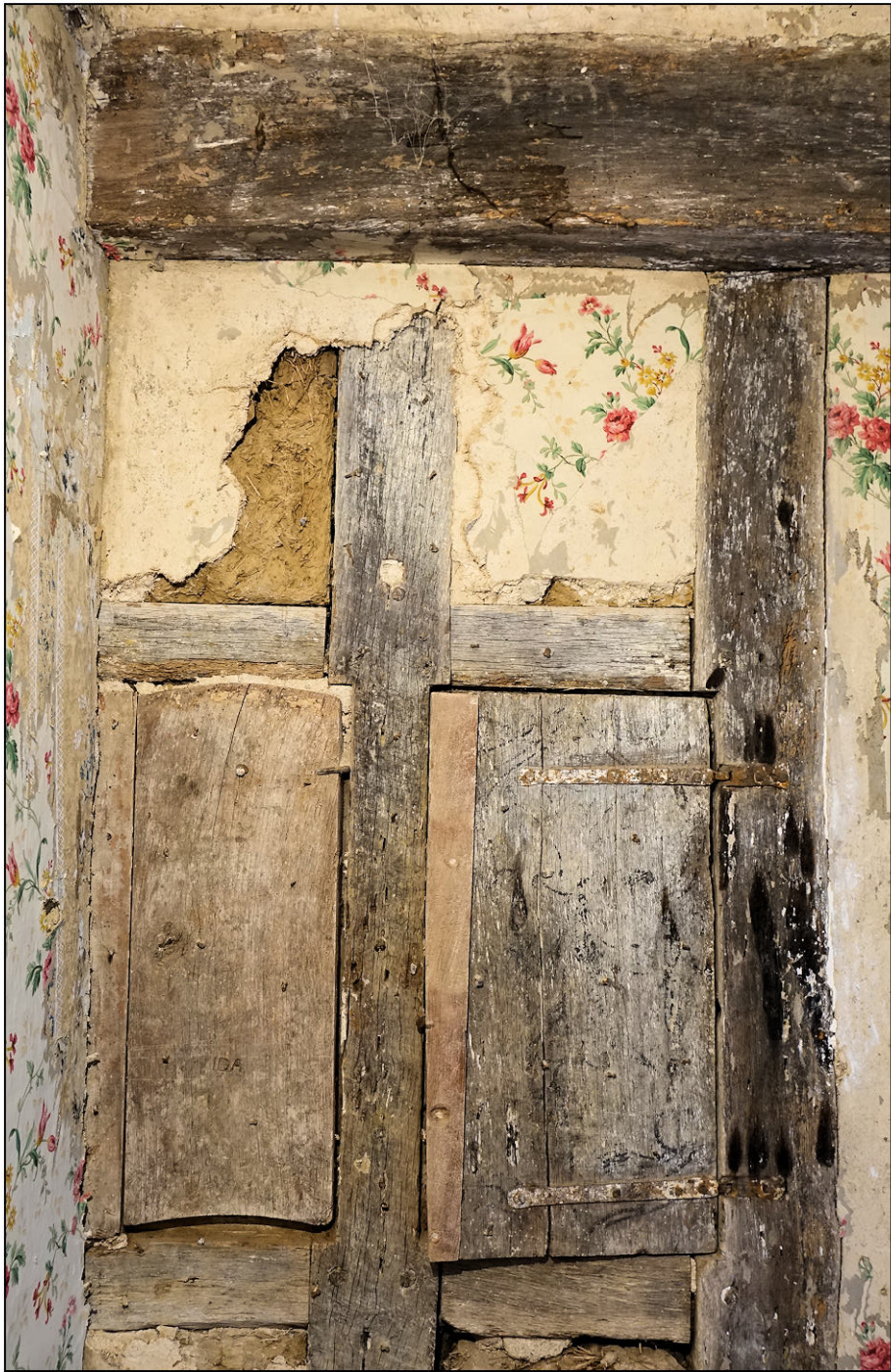
Fig. 2.1. Croisée (avant dégagement des compartiments supérieurs)
