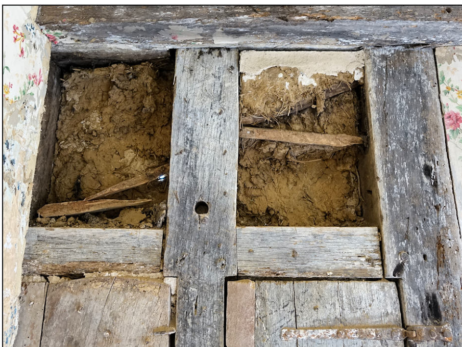
Fig. 3.7. Remplissage en torchis des compartiments supérieurs
