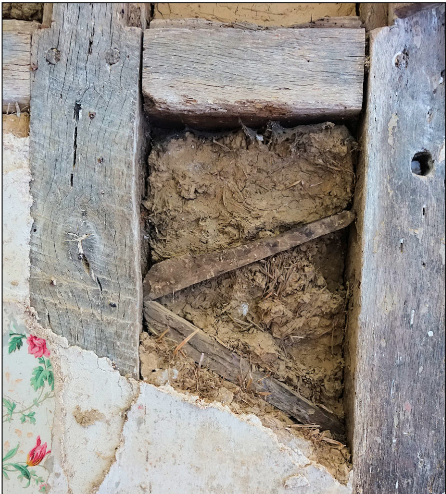
Fig. 2.4. Remplissage de l'allège
