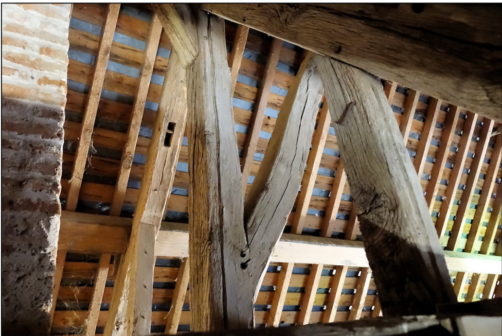
Fig. 1.3. Ferme de charpente fermant le pignon du vieux logis
