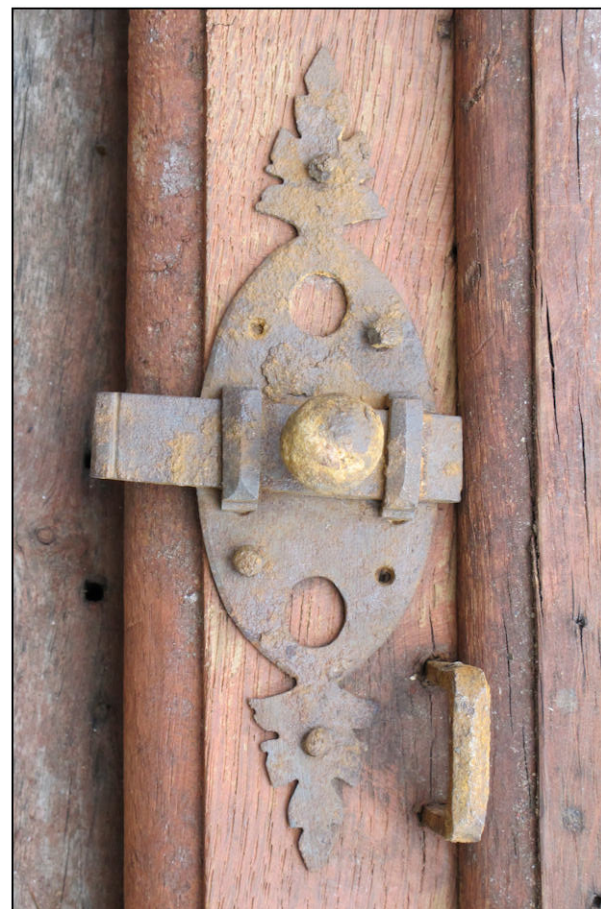
Fig. 2.3. Targette (vantail intermédiaire)
