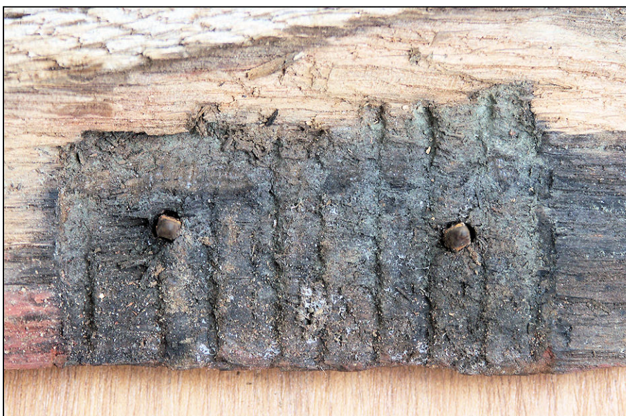
Fig. 3.5. Fiche (mortaise de l'aile)
